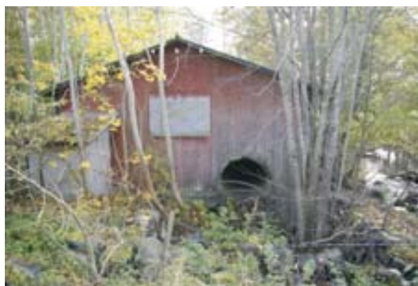
Här har kraftutnyttjandet upphört.
