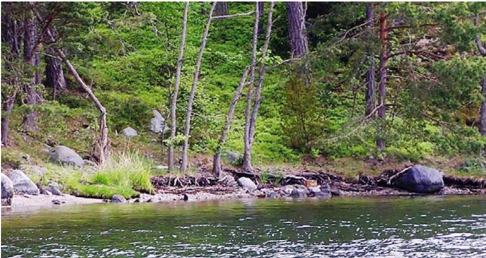
Figur 4: Strand inom klass 1, det vill säga en strand som uppvisar lätta erosions-skador. Erosionsbrinken är mindre tydlig än vad som är fallet för svår erosion, men syns trots allt tydligt
