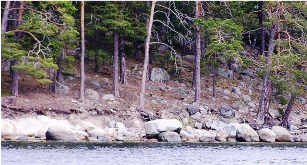
Figur 5: En svårt skadad strand inom klass 2. Erosionen har nått högt upp på stranden. En tydlig vegetationsförlust och frispolade trädrötter syns. Finare material har spolats bort och stranden är fylld av block.
