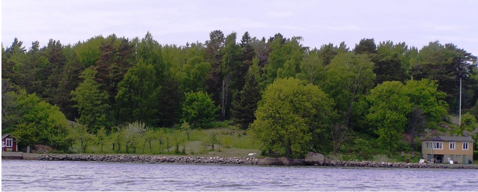
Figur 8: Långa sträckor i anslutning till passagerarfartygens rutter har stenlagts i syfte att skydda dem mot erosion.
