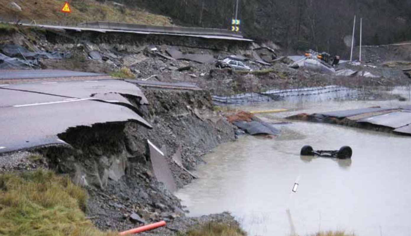
Figur 30. Skredet i Munkedal 2006. Väg E6 raserad. Foto: Susanne Edsgård, MSB.
