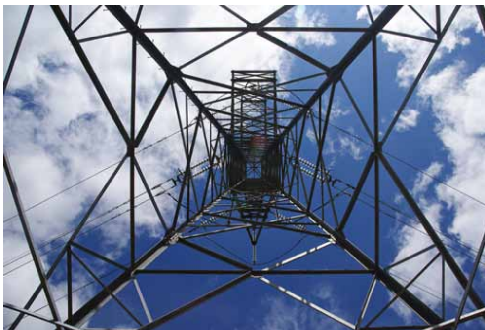
Figur 40. Luftburen ledning. Foto: Lovisa Lagerblad.
