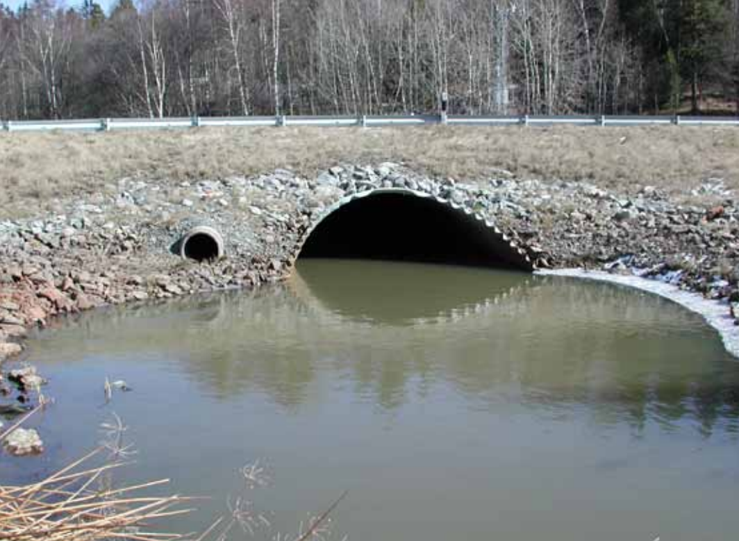
Figur 51. Kvarnbäcken under väg nr 73 i Nynäshamn kommun. Trumman är bra placerad för den akvatiska faunan, och mindre däggdjur kan passera vid den lilla trumman till vänster. Foto: Martin Larsson.
