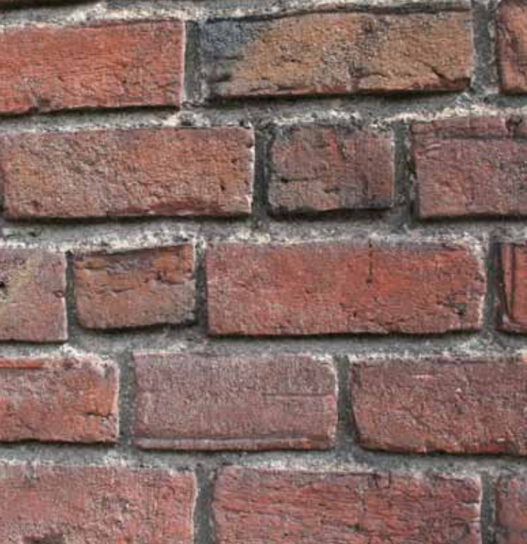
Figur 34. Tegelfasad. Foto: Emma Östlund.
