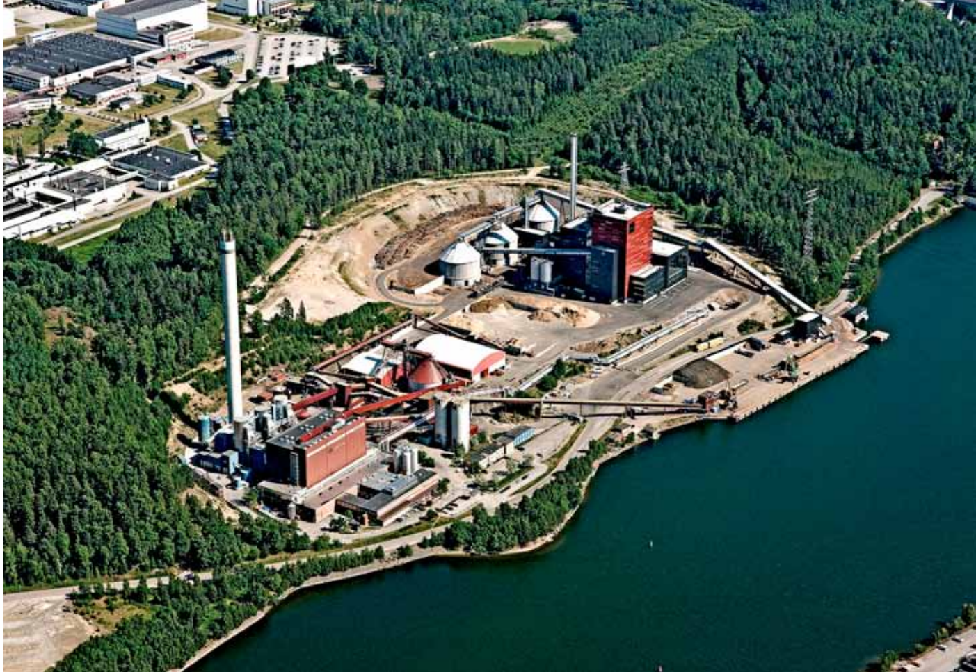
Figur 41. Flygbild över Igelstaverket och Igelsta kraftvärmeverk i Södertälje. Till höger på bilden syns det nya kraftvärmeverket – det hittills största biobränsleeldade kraftvärmeverket i Sverige. Foto: Söderenergi AB.
