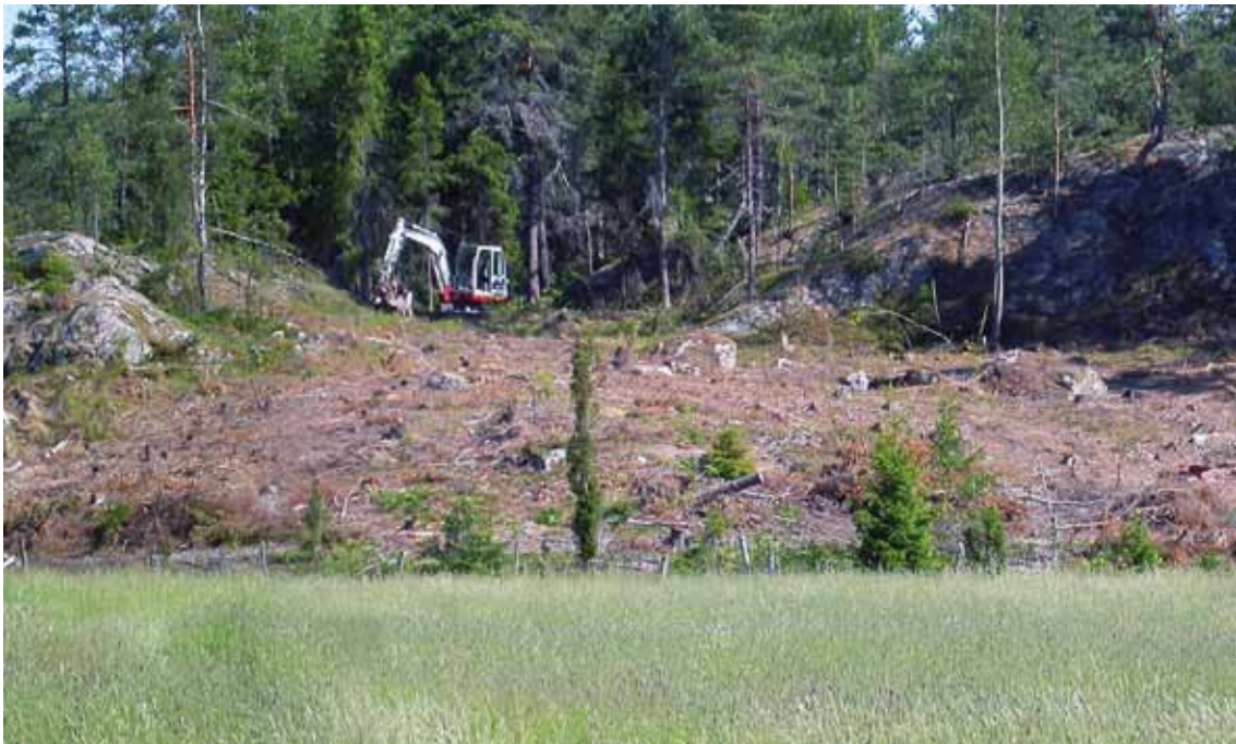
I allt större utsträckning undersöks även boplatslämningar från den äldsta stenåldern i länet. Bilden visar arbetet på boplatzen Lissleäng 2 i Ösmo socken. Denna liksom flera andra liknande undersöktes i samband med bygget för nya väg 73 mellan Stockholm och Nynäshamn. Foto: Arkeologikonsult.
