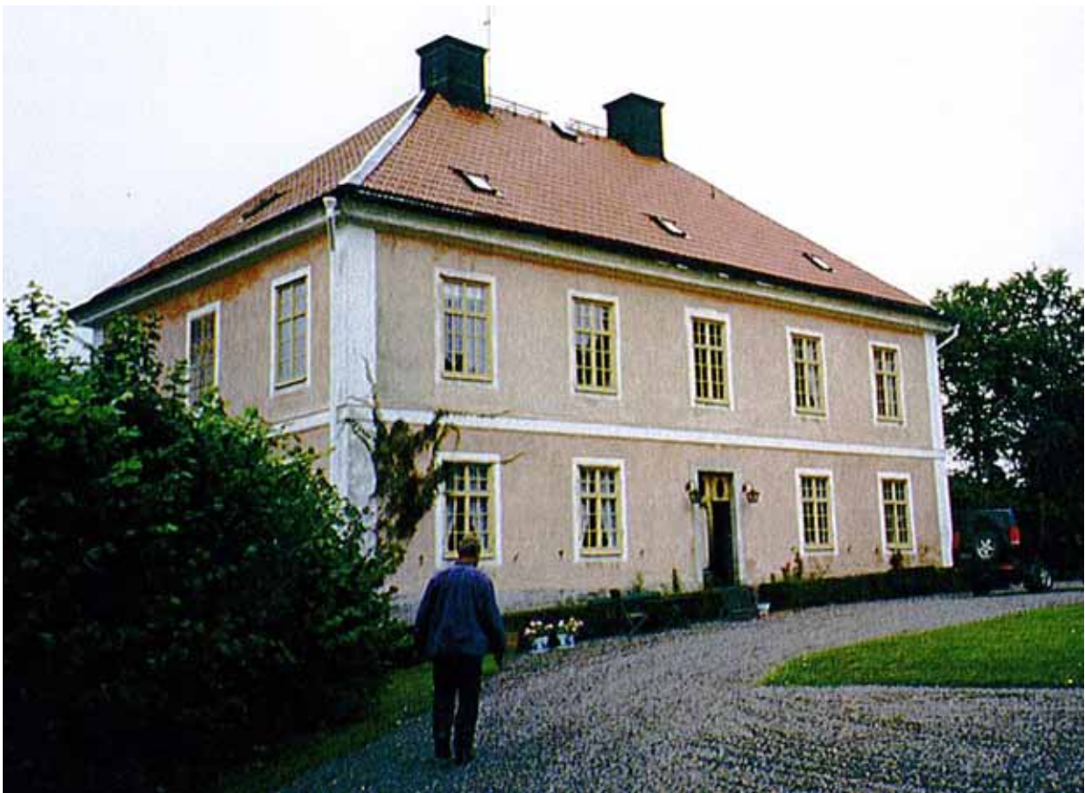
Källarvåningen i den norra flygeln på Fällnäs gård i Sorunda socken, Nynäshamns kommun har efter en byggnadsantikvarisk dokumentation daterats till slutet av 1400-talet. Foto: Lars Bengtsson.
