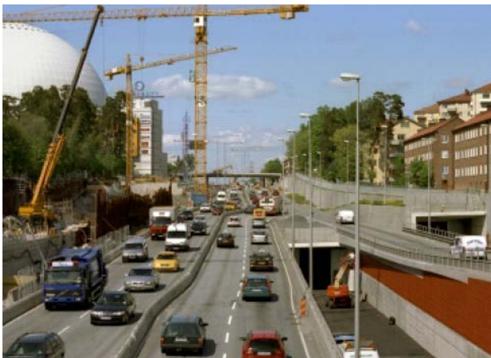
Figur 8. Ny trafikled i S Nynäsvägens överdäckning. Från Södra Länken - en ny trafikled i Stockholm.
