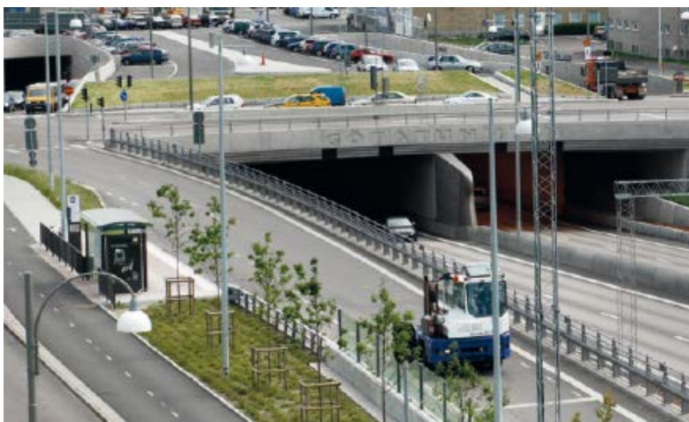
Figur 15. Götatunneln. Figur hämtad från Götatunneln - utvärdering arkitektur och stadsbyggnad, Vägverket, se Trafikverkets hemsida.
