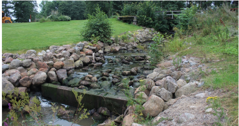
Figur 1. Vandringshindret i Taxingeån består av gjutna trösklar som skapades för att säkra den närliggande kyrkan. Foto: Rickard Gustafsson.
