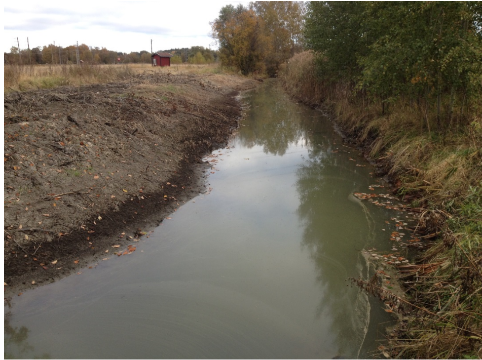
Figur 12. Nydikat och rensat avsnitt vid provtagningsstationen i Odensalabäcken hösten 2015. Förlusterna av fosfor har varit stora efter ingreppet.
