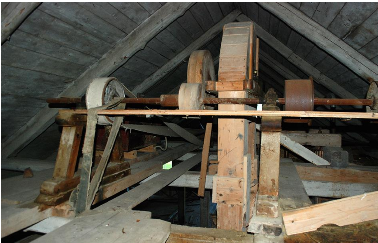
På siktbotten högst upp mot taket finns en mindre transmissionsaxel och en elevator topp. Foto LKU 2014
