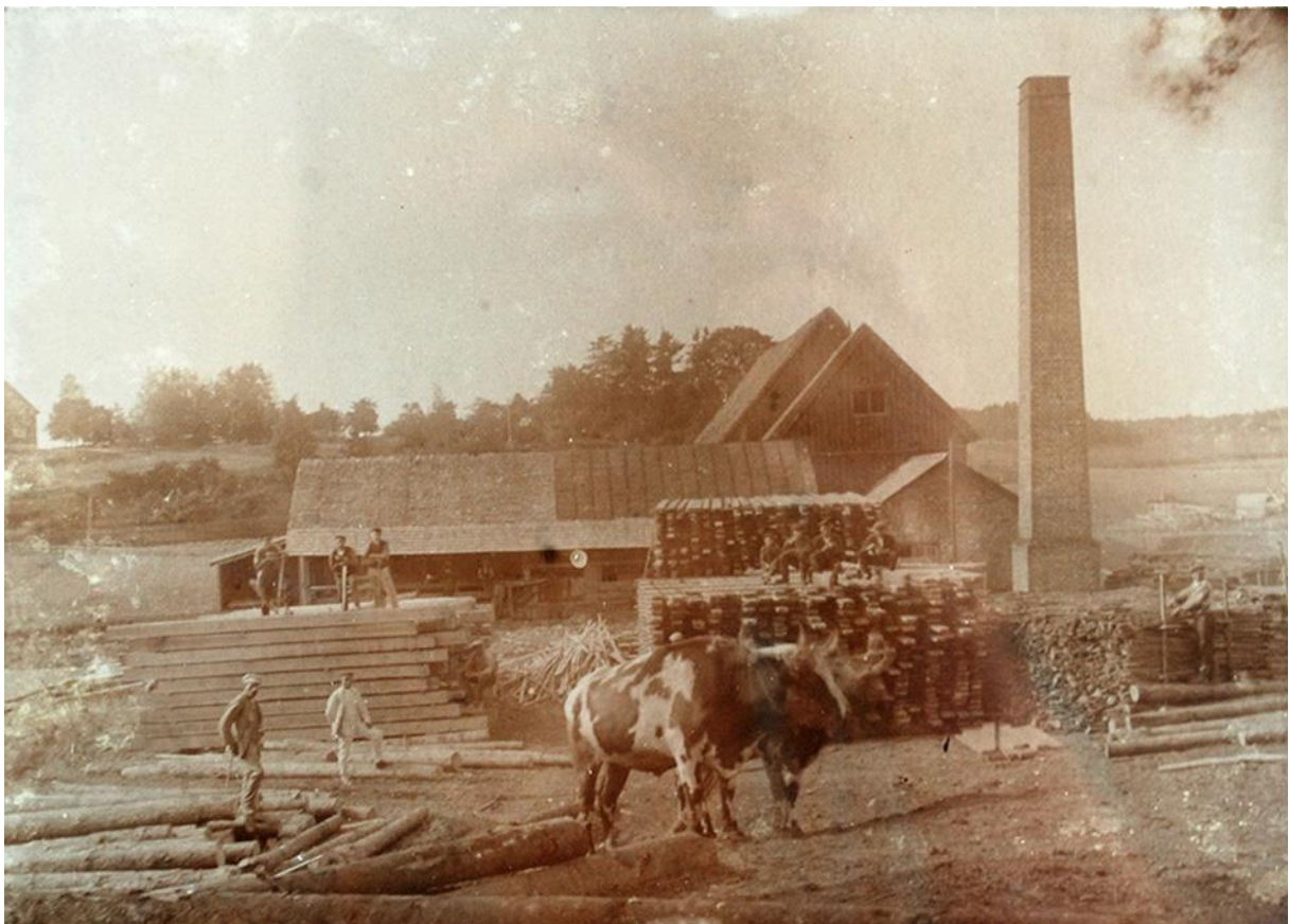
Här är sågverksamheten i full sving. Mitt i bilden ser vi sågbyggnadens långsida där virke och timmer togs in och ut, och till höger om den syns maskinhuset med den fyrkantiga skorstenen. Byggnaden längst bak i bilden är troligen kvarnen som också drevs av ångmaskinen. Privat odaterat foto ur Karin och Johans album
