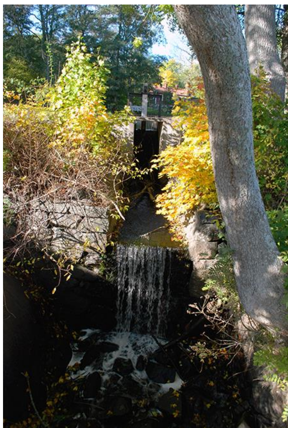
Kvarndammen (ovan) och sågdammens bräddavlopp ut till Vaddövikén (vänster). Foto LKU 2014
