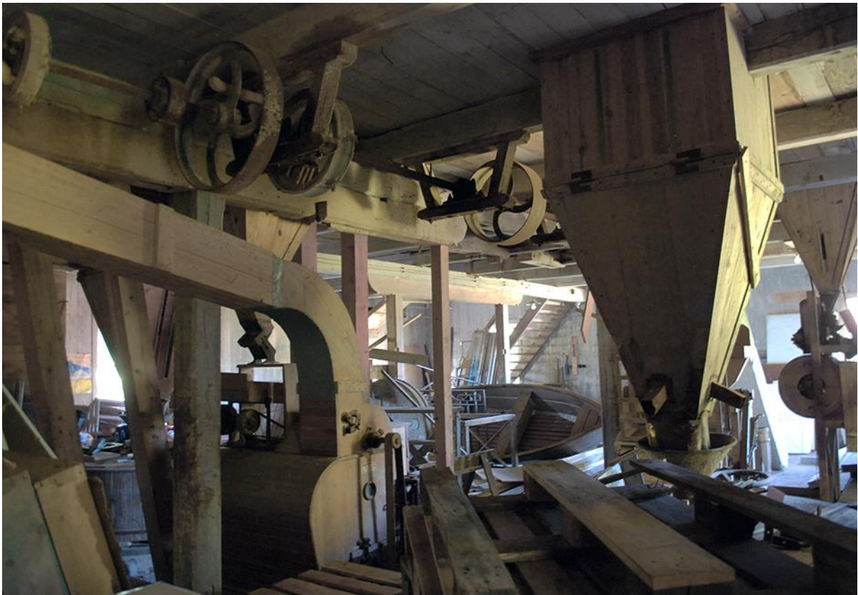
Transmissionsbotten (överst) och malbotten (ovan). Foto LKU 2014
