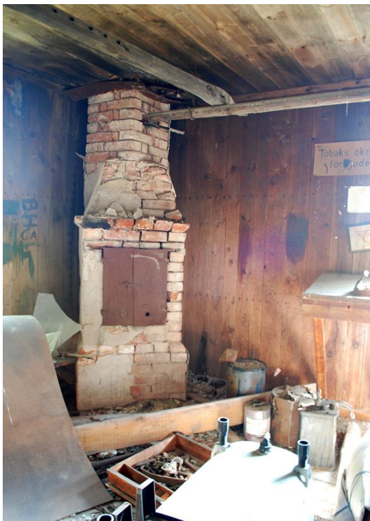
I kvarnen finns en liten kvarnkammare med en murad eldstad. Bilden ovan visar en del av byggnadens grund med en sättningskada. Foto LKU 2014
