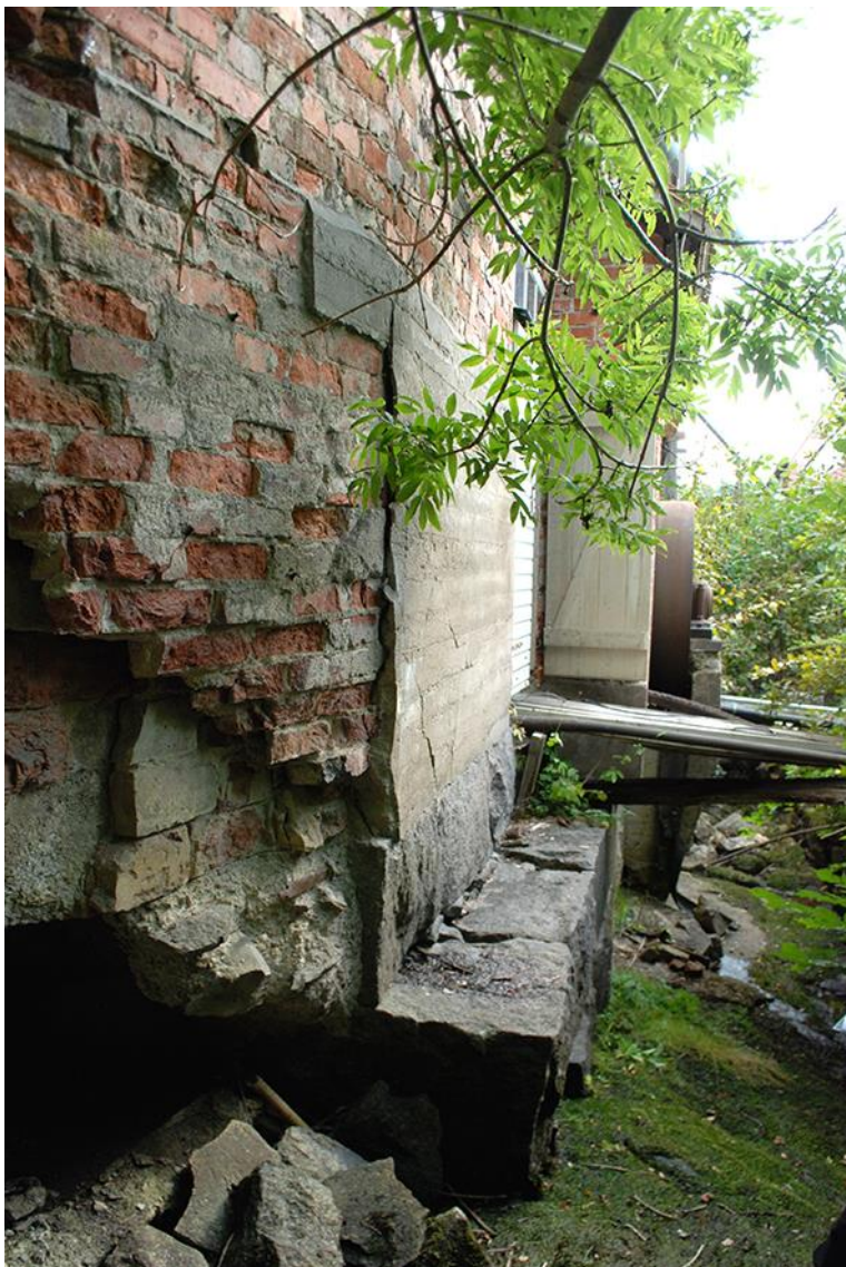
Här längs med maskinhuset passerade vattnet. Notera transmissionshjulet som fortfarande sitter kvar bakom dörren. Foto LKU 2014
