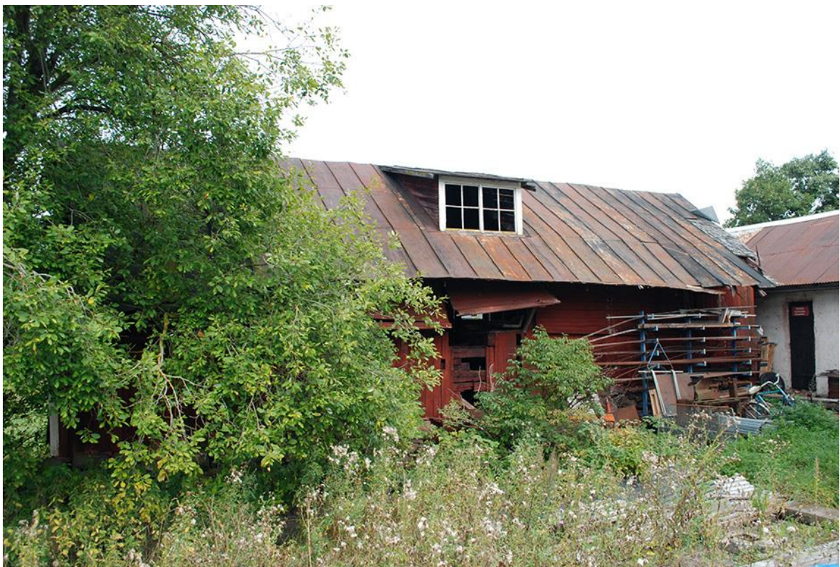
Såghuset till vänster i bild och maskinhuset skymtar höger. Foto LKU 2014
