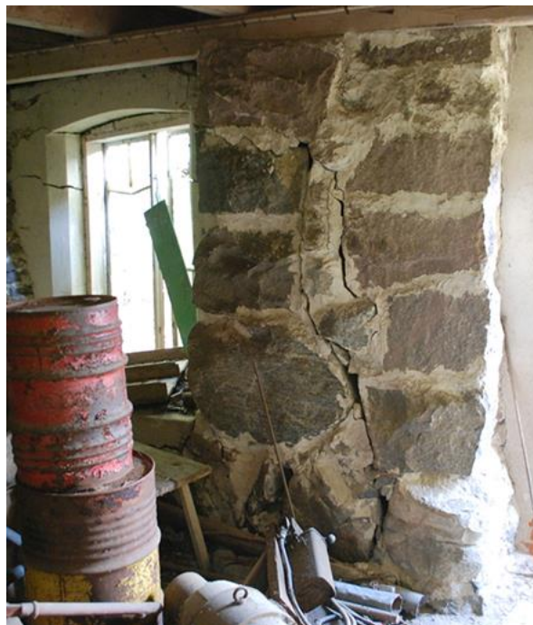
I kvarnen finns en liten kvarnkammare med en murad eldstad. Bilden ovan visar en del av byggnadens grund med en sättningskada. Foto LKU 2014
