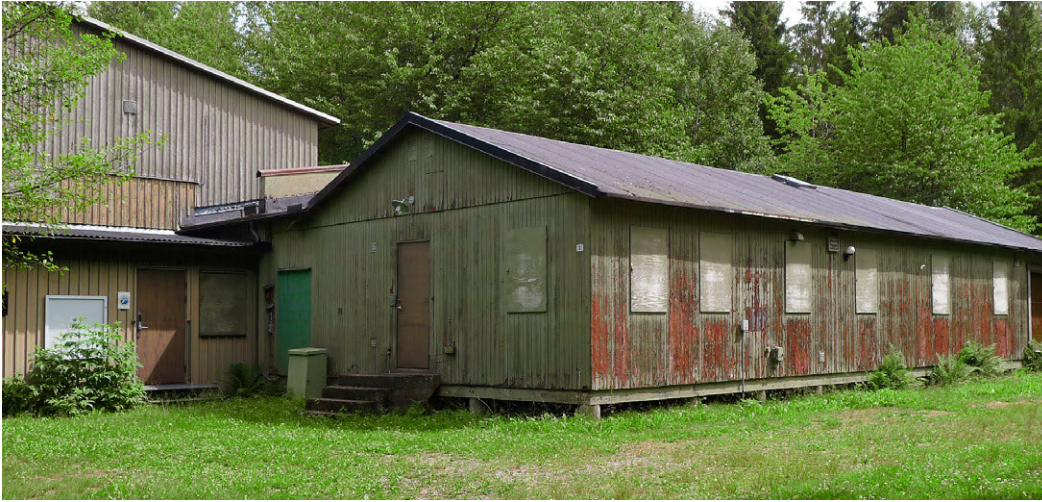
Byggnad 1 på Ledningsplats Björn, med den höga ledningscentralen "Kyrkan" till vänster i bild. Fotograf: Robin Gullbrandsson, Västergötlands museum, 2023.
