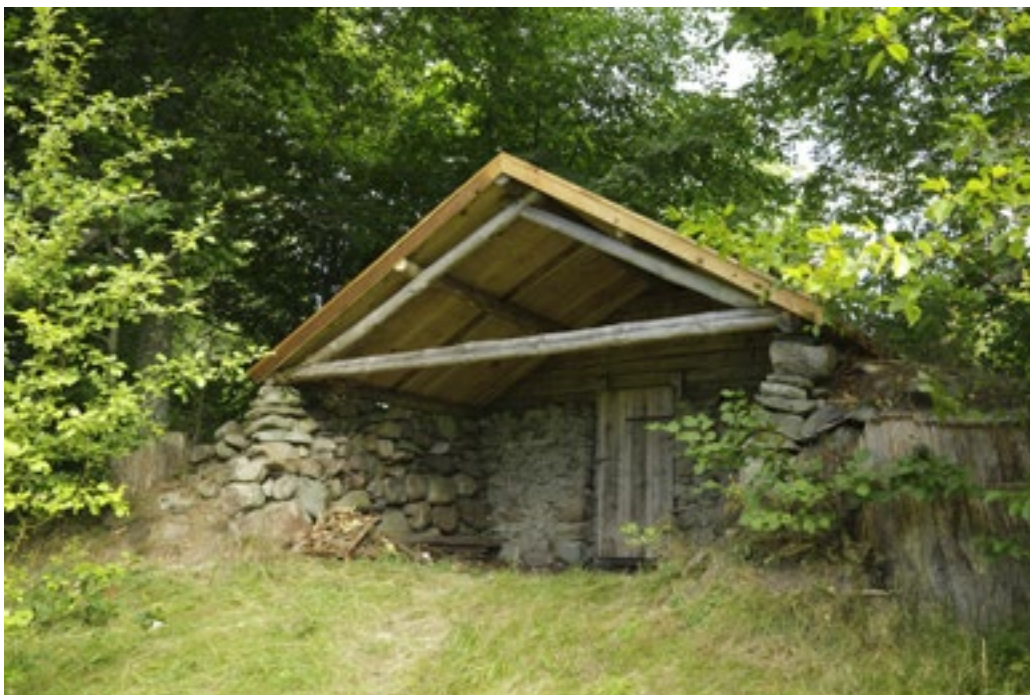
Under sommaren 2020 fick linbasta ett nytt tjärat faltak.
