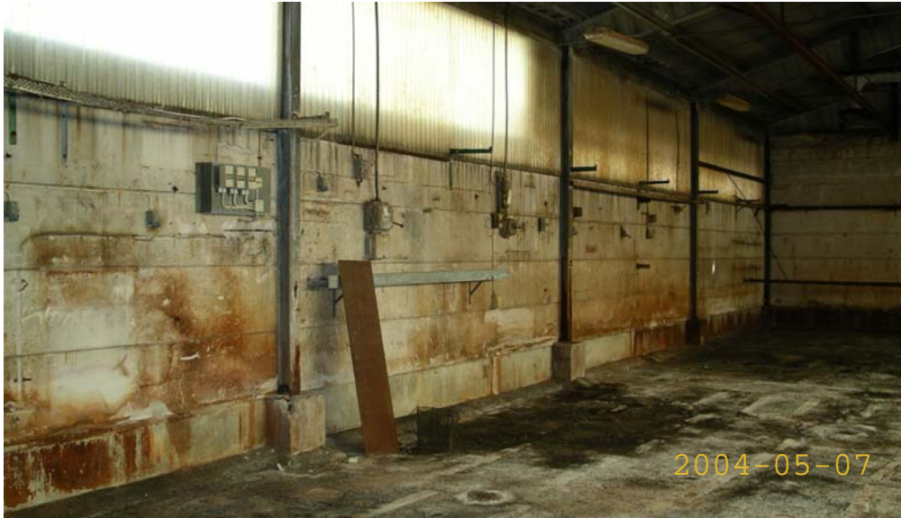
53. Västra väggen industribyggnad
