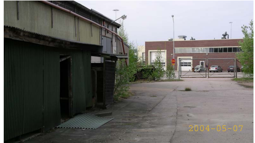
50. Västra sidan om industribyggnaden mot syd
