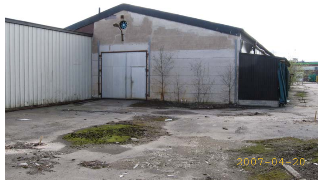
4. Industribyggnad från norr
