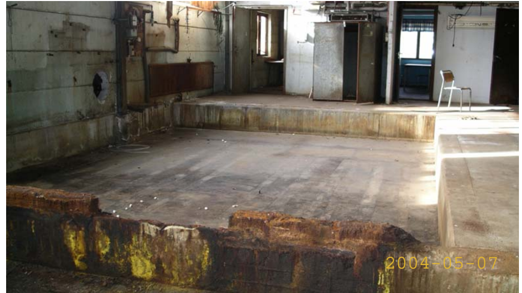
54. Sydöstra delen av industribyggnaden
