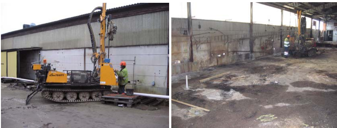
Figur 7 Fotona visar skruvprovtagning med borrhandsvagn.
