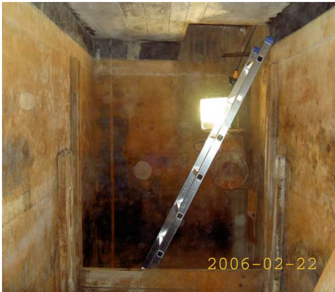
63. Bassäng gamla reningsverket
