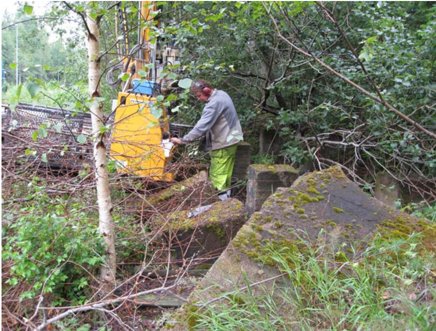
Figur 8. Skruvprovtagning vid tryckimpregneringsplatsen (0805).
