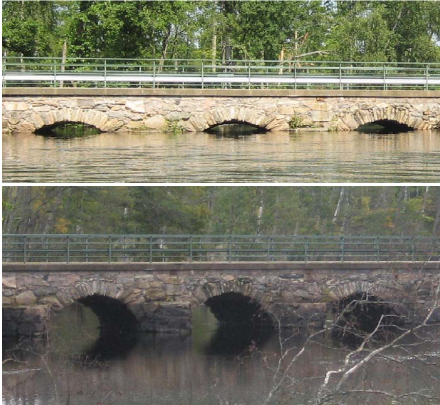
Fig 8. Två tillfällen med olika vattenstånd i Möckeln. Bilderna visar samma tre valv fast med en skillnad i vattenstånd kring 1,3 meter.
