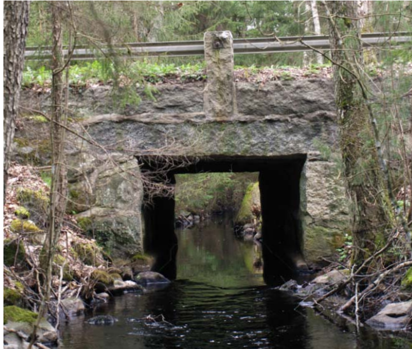
Figur 16 Vägbro över Bastaremlåbäcken strax söder om Bastaremlå. Sektionen har nyttjats för flödesmätningar.
