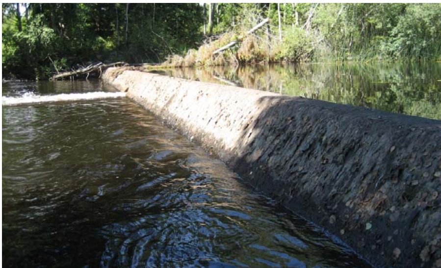
Fig 5. Grunddammen tvärs över Trässhults kanal. Dammhöjden är ca 70 cm på nedströmssidan. Tyvärr utgör dammen ett vandringshinder förutom vid högoattenflöden. Uppströms dammen fastnar också sediment. Ett ca 60 cm stort hål har tagits upp genom dammkroppen men det är ytterst tveksamt att detta möjliggör uppströmsvandring.
