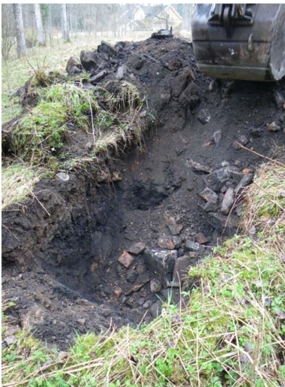
Grävning av provgrop ÖG1 vid platsen för hyttan.
