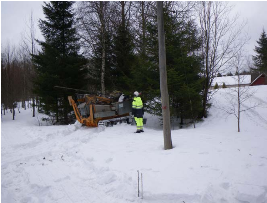
Installation av Ö2. Platsen för hyttan är bakom granarna, uppför backen.
