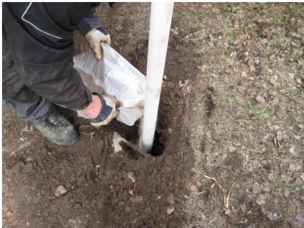
Figur 4 Installation av GV-rör
