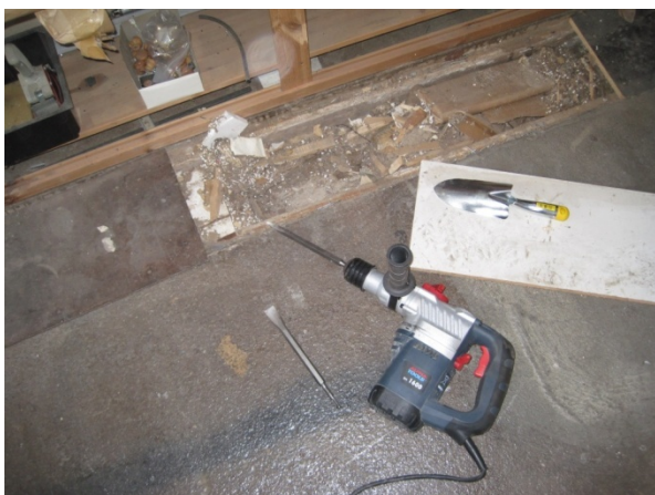
Figur 6 Bilning i betongen med borrhammare i rännan
