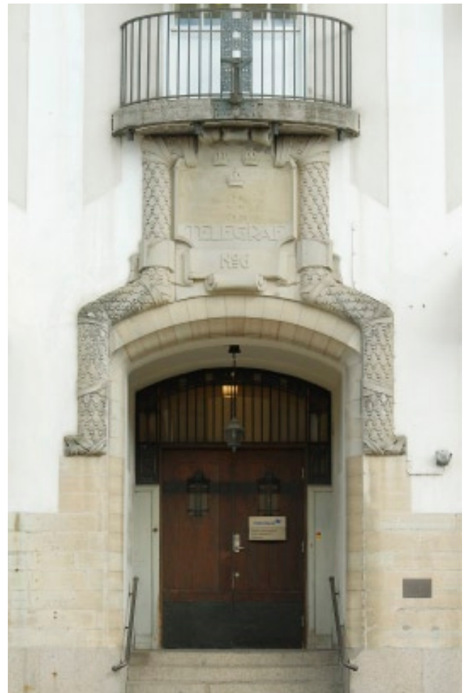
Post- och Telegrafverkets entré mot Storgatan. De ursprungliga ekportarna finns ännu kvar. Foto: Thomas Lissing.
