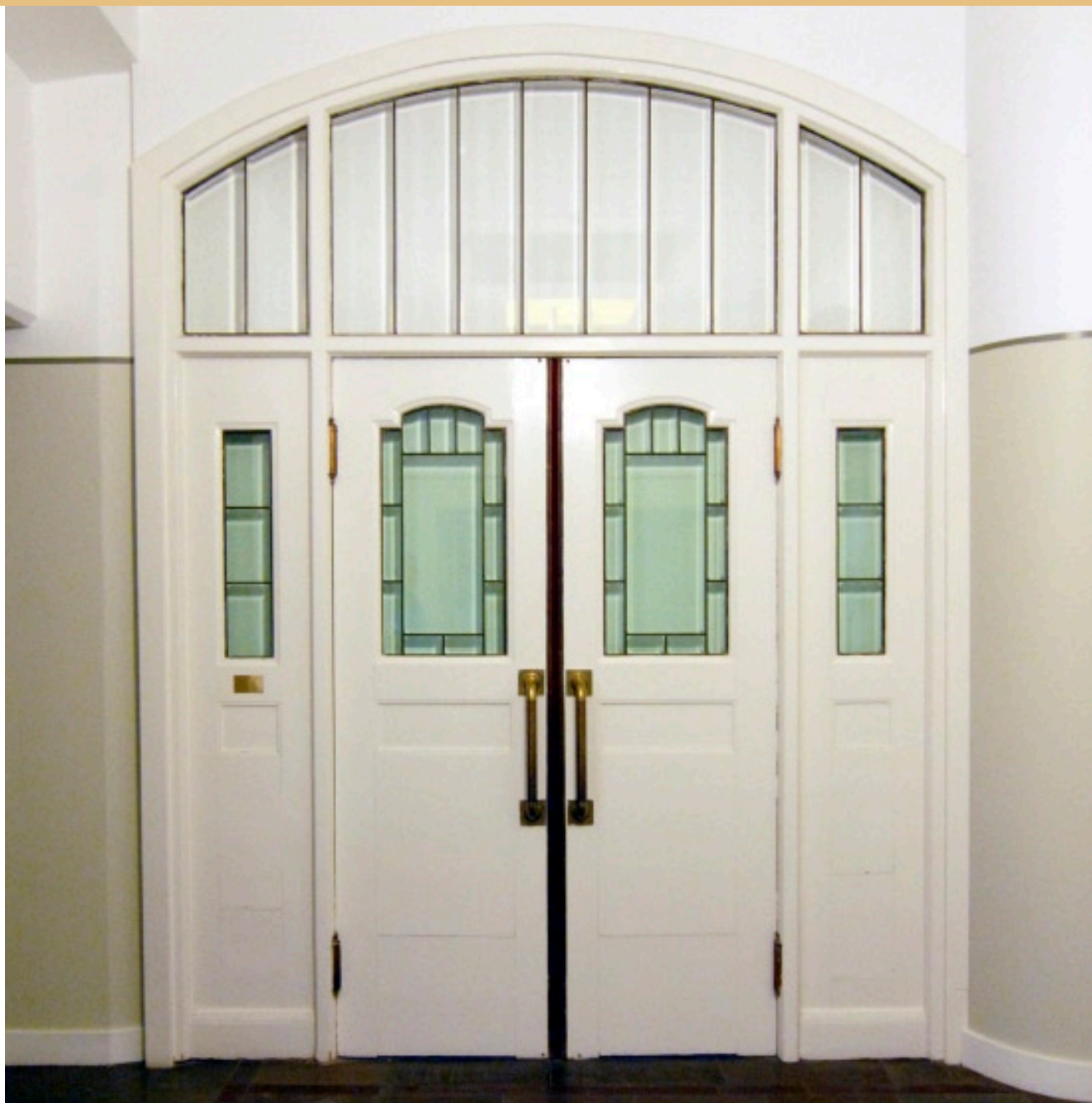
Post- och Telegrafverkets innerdörrar sparades vid en tidigare renovering och sitter nu som blinddörrar i en annan del av fastigheten. Foto: Thomas Lissing.
