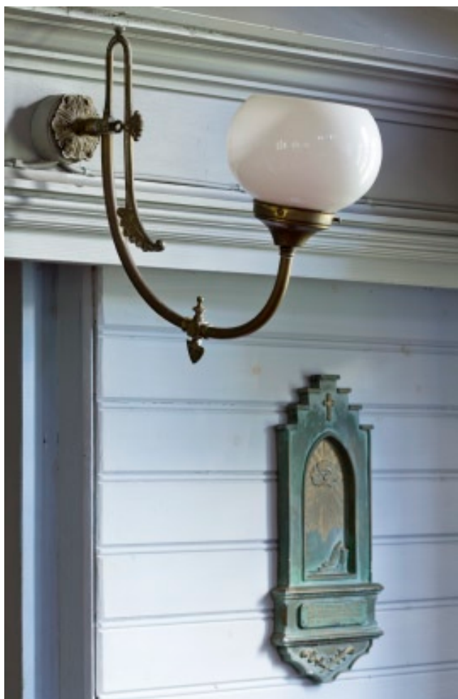
Armatyr i jugendstil på läktarens barriär som ursprungligen kan ha varit avsedd för acetylenagas. Foto: Pierre Rosberg, Kalmar läns museum.
