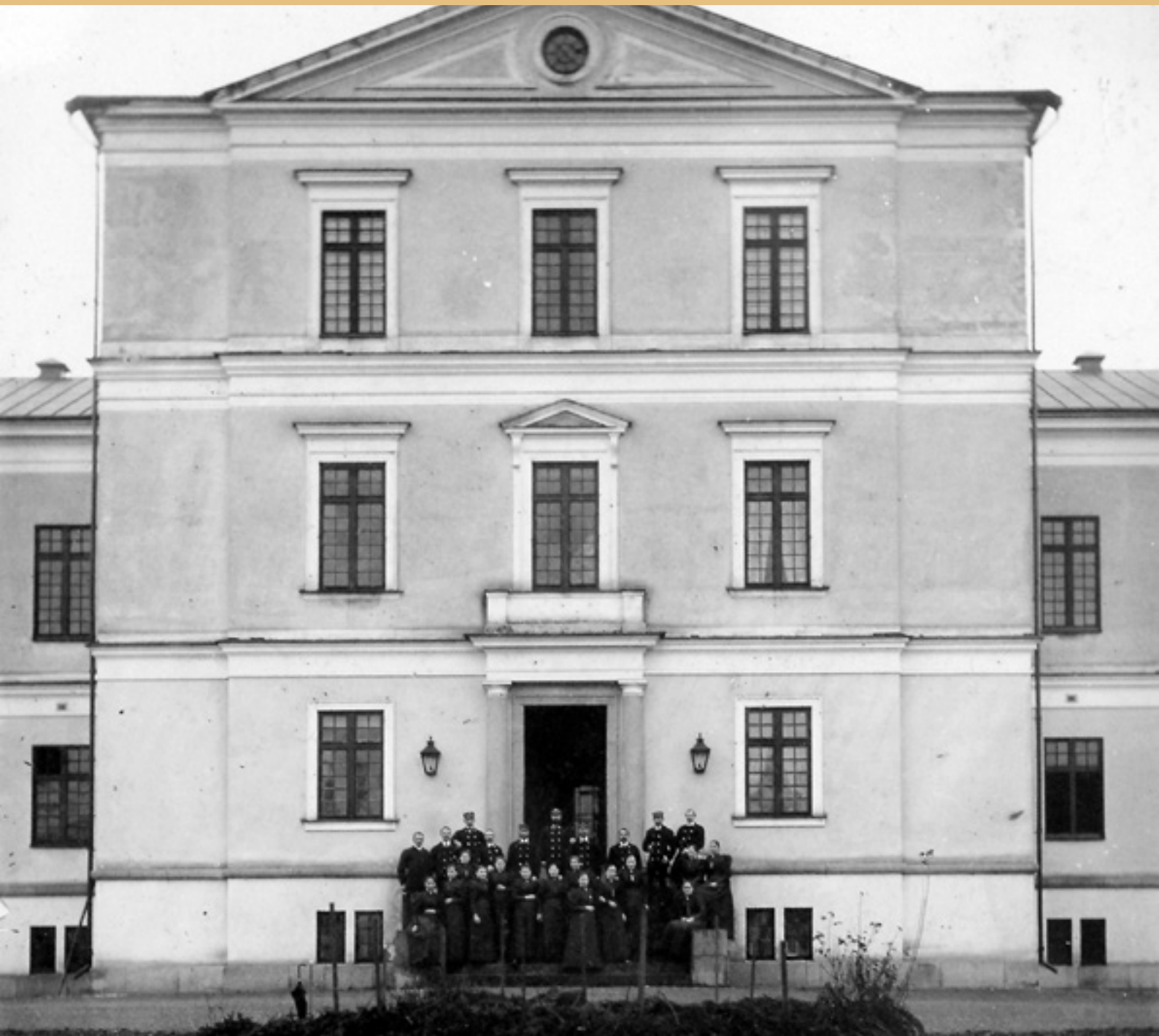
På detta fotografi från omkring 1920 kan man se att fönstren tidigare haft en mörkare kulör, liksom fasadens puts. Foto: Psykiatrihistoriska museet, Växjö.
