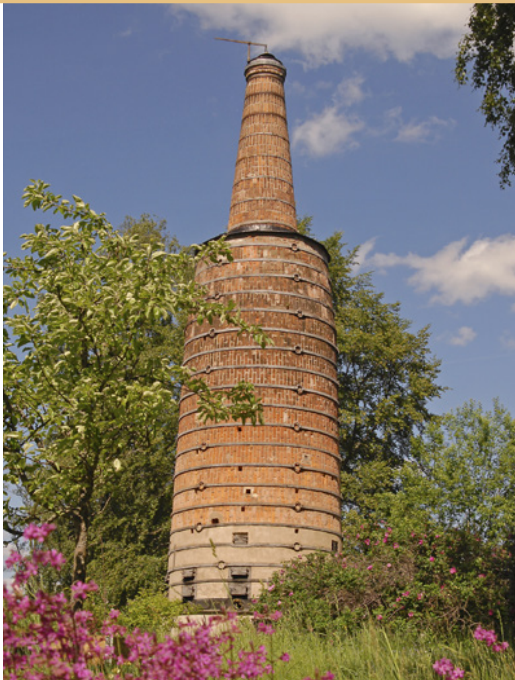
Rostugnen uppfördes 1873 och restaurerades på 1990-talet. Foto: Thomas Lissing.
