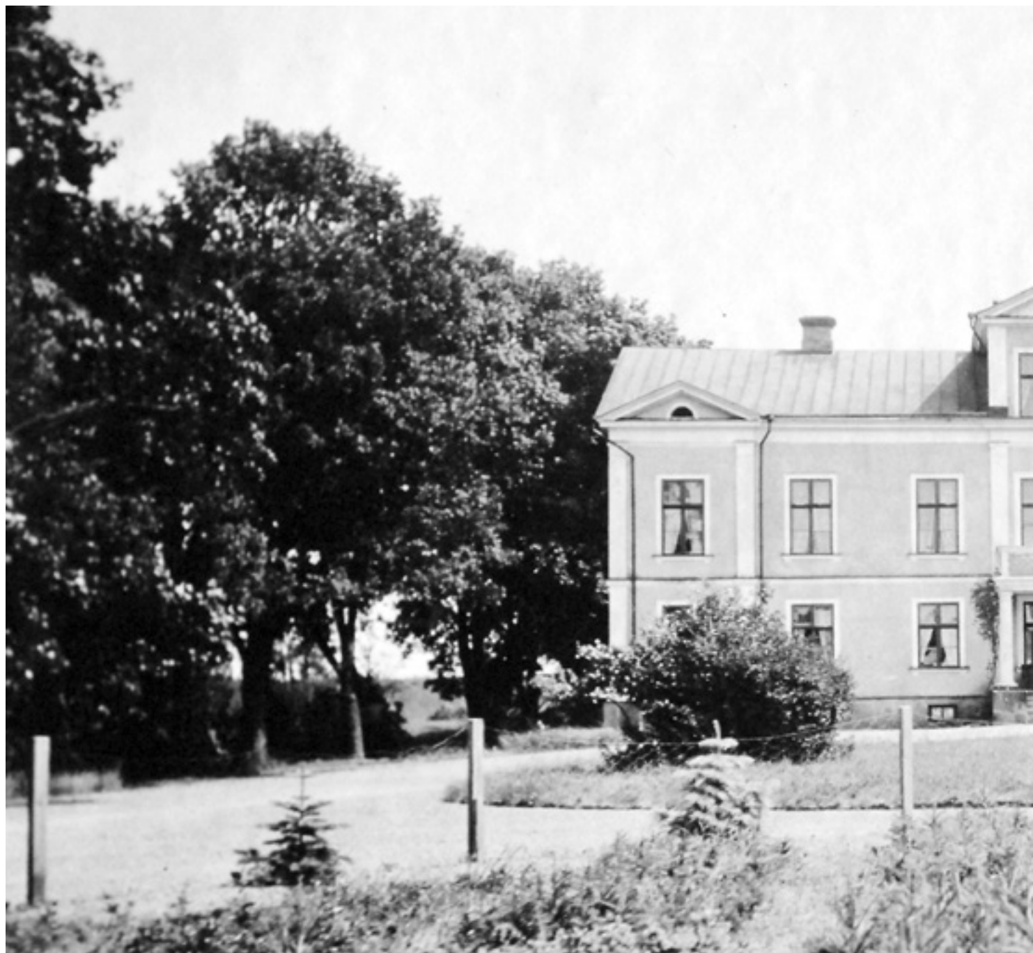
Herrgården på 1920-talet. Lägg märke till odlingarna i förgrunden och rondellens upphöjning som kröns av en urna. Foto: Hemmesjö hembygdsförening.
