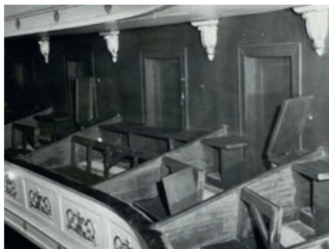
Logeradernas utförande, före den stora restaureringen på 1950-talet. Bilden ingår i ATA:s samlingar.
