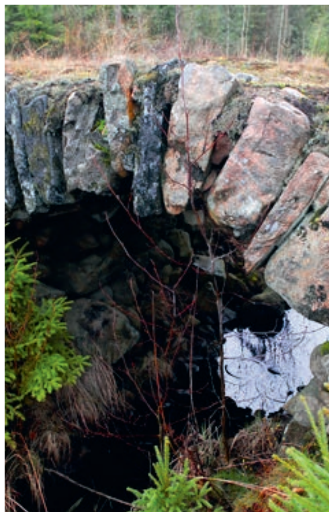
Vägbanan ligger direkt på valven. Foto: Thomas Lissing.
