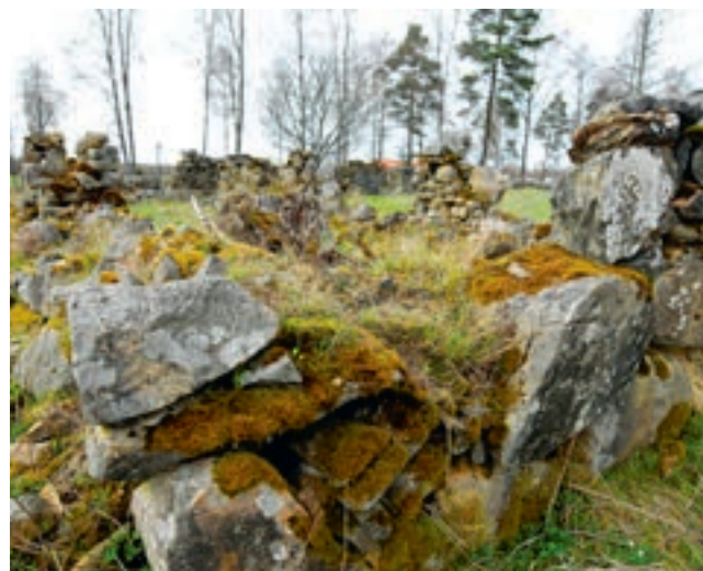
Av de kvarvarande stengrunderna kan man se att byggnaderna varit kraftigt dimensionerade. Foto:Thomas Lissing.
