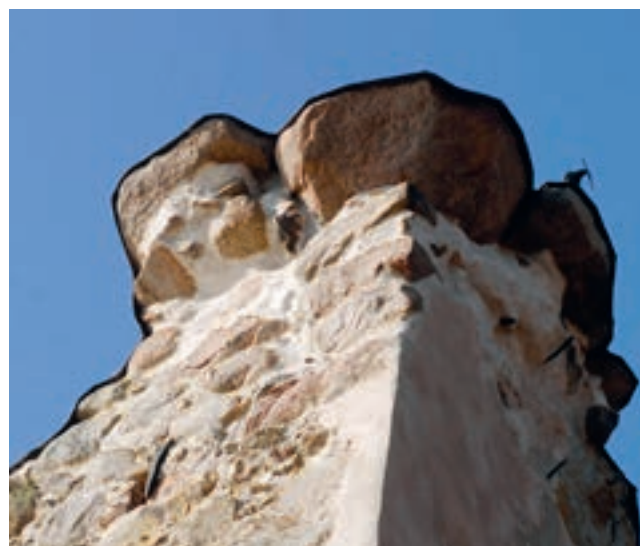
Utkragande stenar efter ett tidigare hörntorn. Foto: Thomas Lissing.
