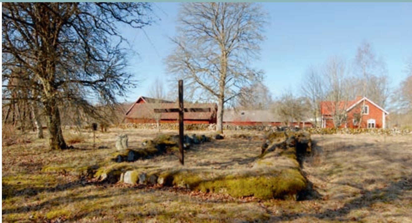
I den låga grundmuren syns tydligt att koret var smalare än långhuset. Foto: Thomas Lissing.
