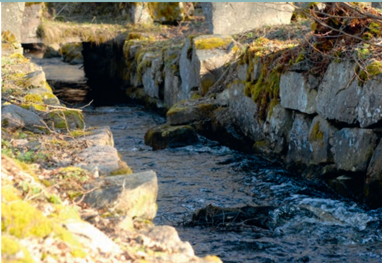
Stensatt vattenränna. Foto:Thomas Lissing.
