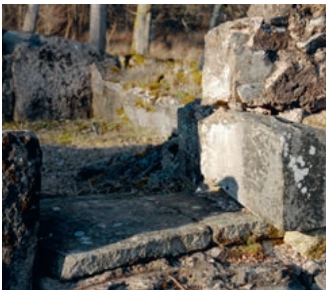
I de låga murarna finns dörrhål klädda med släthuggna stenar. Foto:Thomas Lissing.
