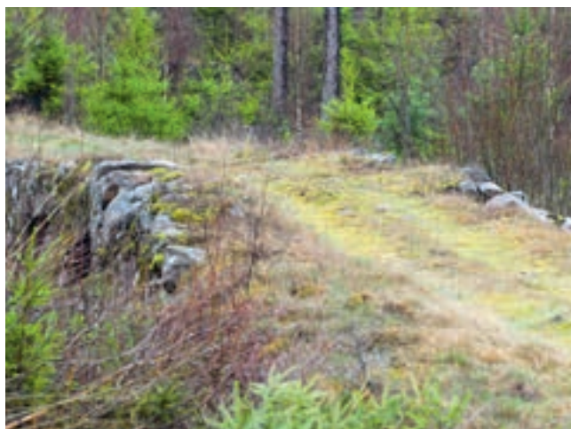
Vägbanan över bron är smal. Foto: Thomas Lissing.
