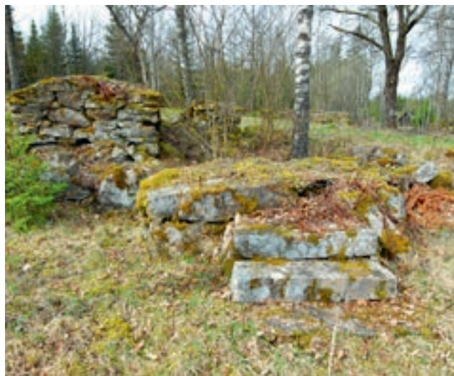
Av bostadshuset återstår en grund med trappa och den kraftiga murstocken. Foto: Thomas Lissing.
