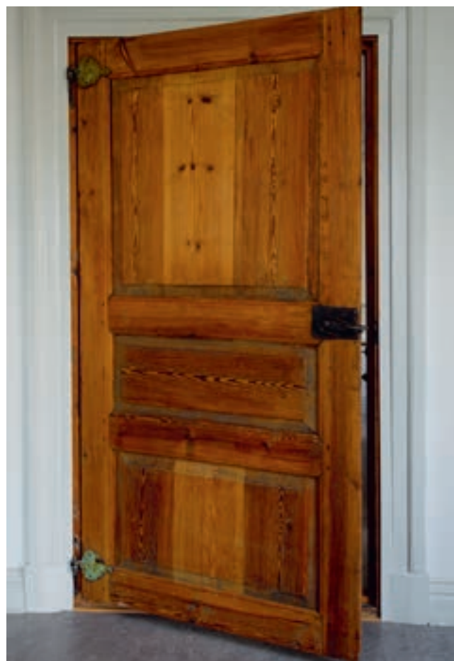
Ursprunglig spegeldörr i trä som återbördades till gamla domprostgården vid restaureringen 1942.
