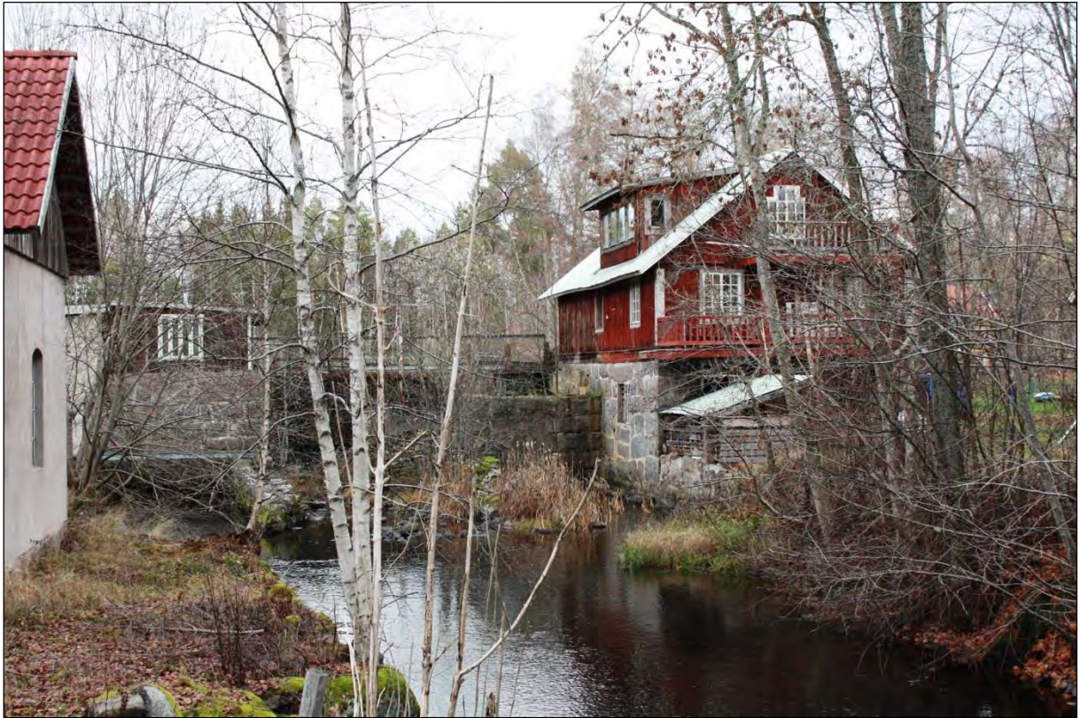
Bild 7. Utloppskanalen sedd ifrån söder.
