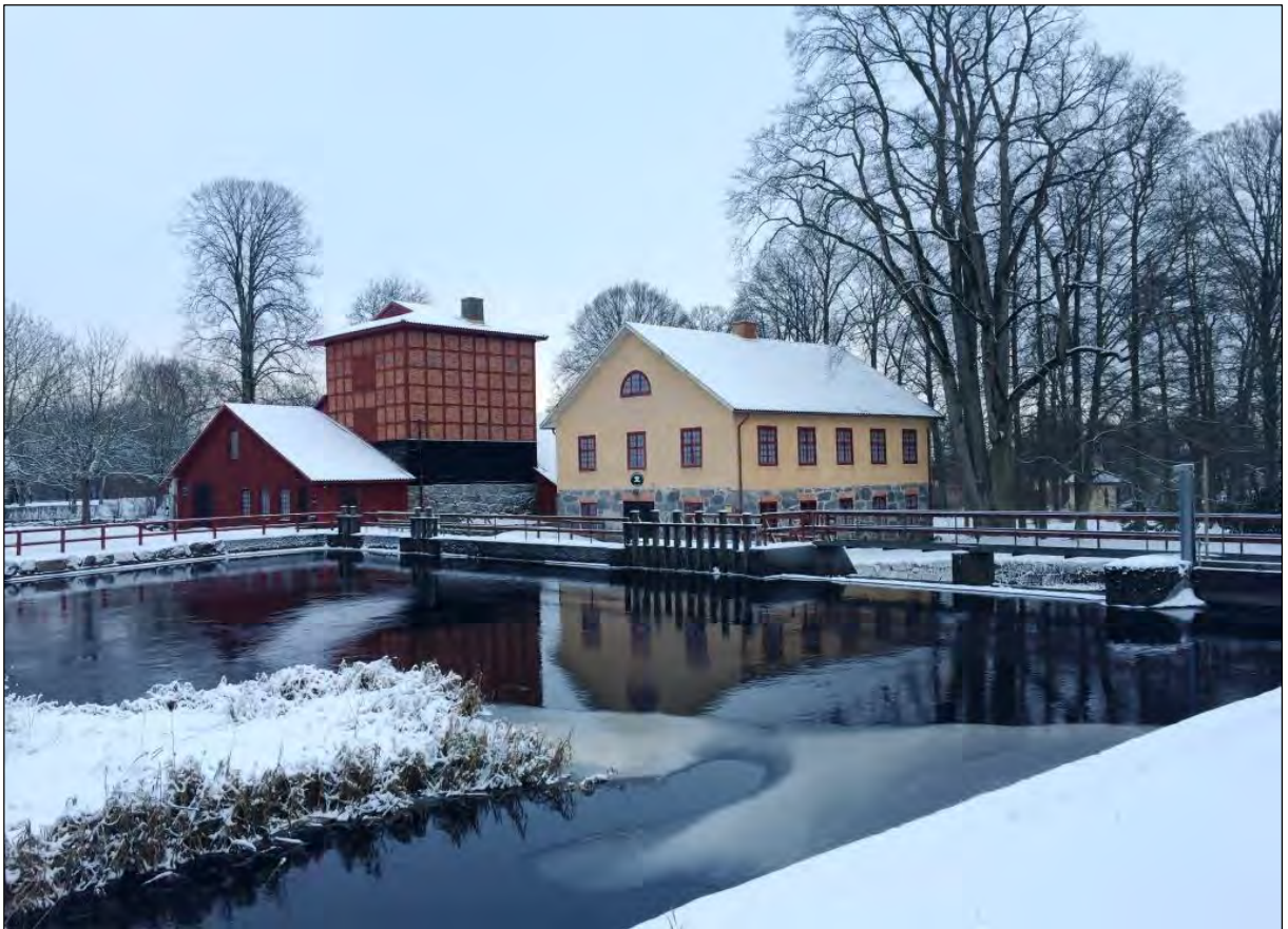
Bild 5 & 6. Överfallsdamm som regleras av utskov med spettluckor.
