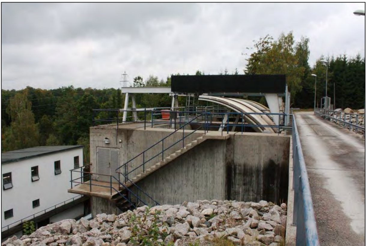
Bild 4. Betongsumpen som ligger i anslutning till kraftstationen.
