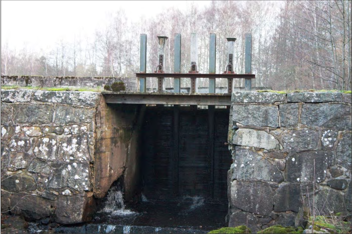
Bild 11. Ett av utskoven i dammvallen som regleras med spettluckor.
