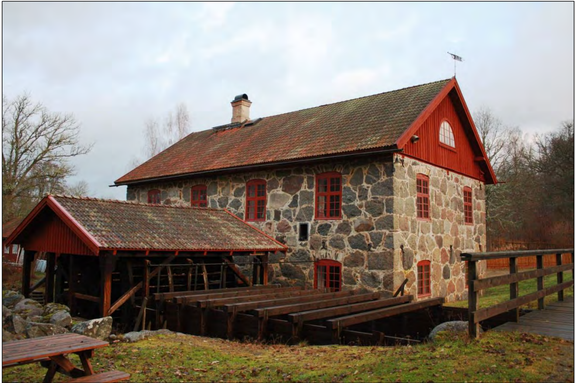
Bild 3. Kvarnbyggnadens västra sida med det relativt nykonstruerade vattenhjulet och träsump. Vattenhjulet skyddas under ett tak.
