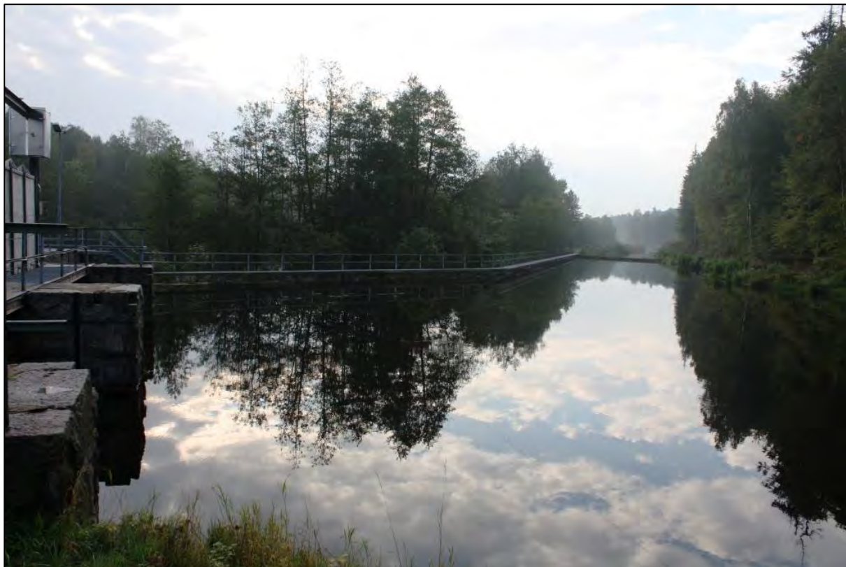
Bild 1. En dammkropp mellan Hemsjö övre och nedre och leder vattnet till intagskanalen vid Hemsjö nedre.
