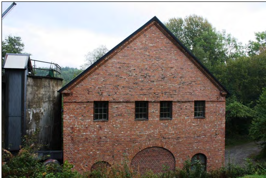
Bild 6. Till vänster i bild syns turbinsumpen i betong.
