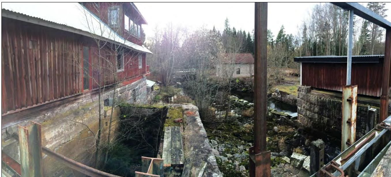
Bild 1. Kvarnhuset (till vänster) och ett senare tillkommet turbinhus (till höger) sedda ifrån norr.
