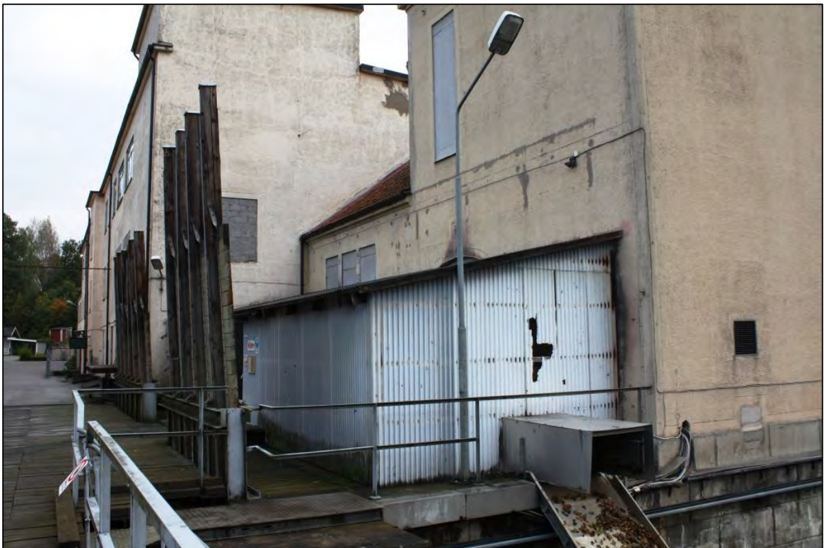
Bild 4. Kraftstationens entrédel av plåt.
