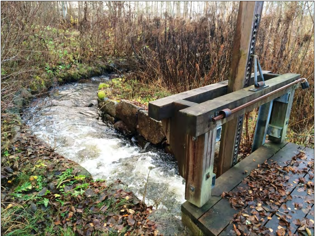
Bild 9. Fiskväg med en spetlucka.
