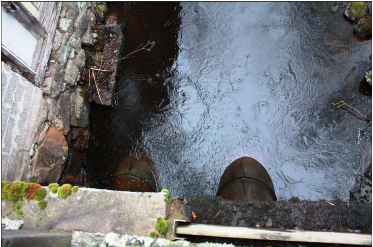
Bild 5 & 6. Turbinsumpen och sugrören som leder bort vattnet ut i uttagskanalen.
