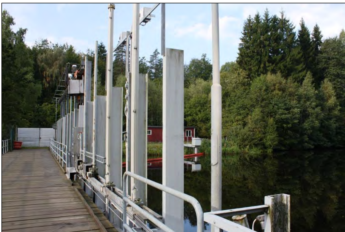
Bild 6. Skalmursdammen som regleras med spettluckor och automatiska luckor av stål.
