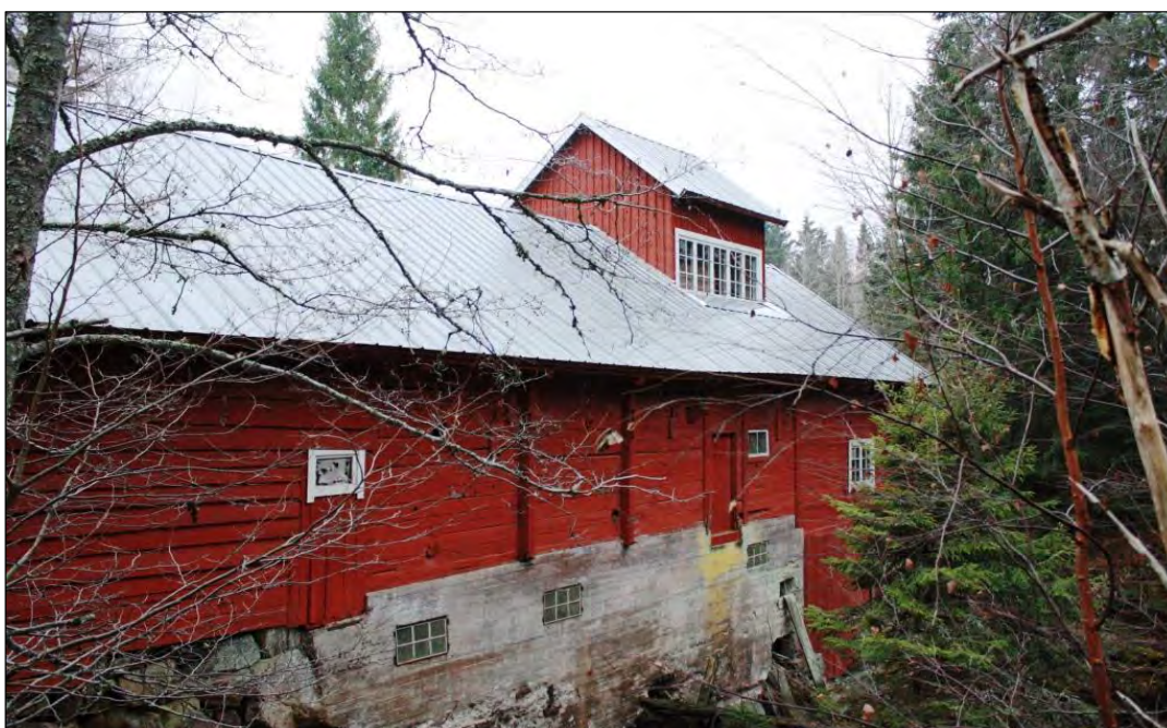
Bild 2. Kvarnen sedd från baksidan med öppningar i den nedre delen för tidigare vattenhjul.
