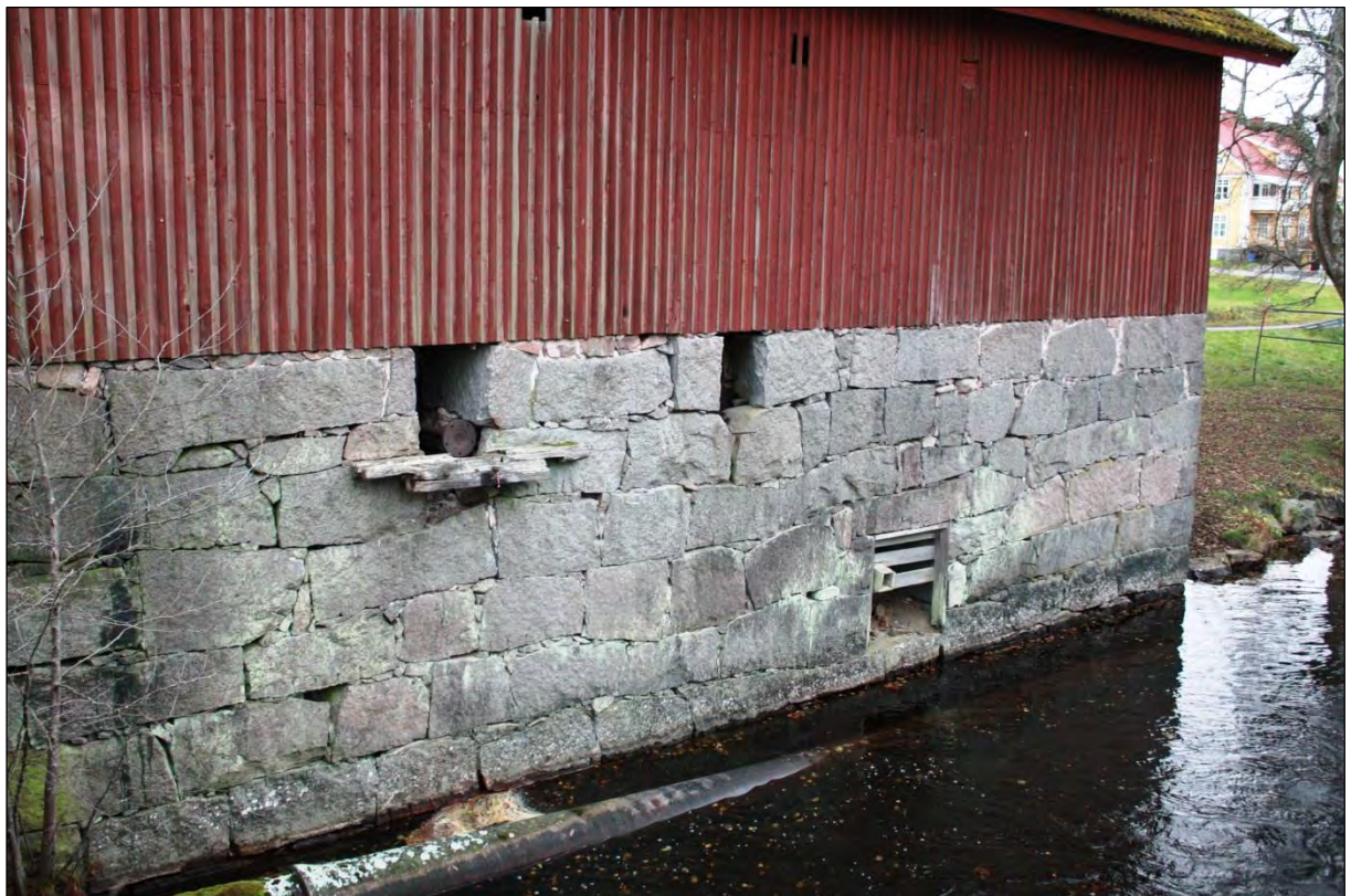
Bild 18. I sockeln finns öppningar där det tidigare troligen har suttit vattenhjul.
