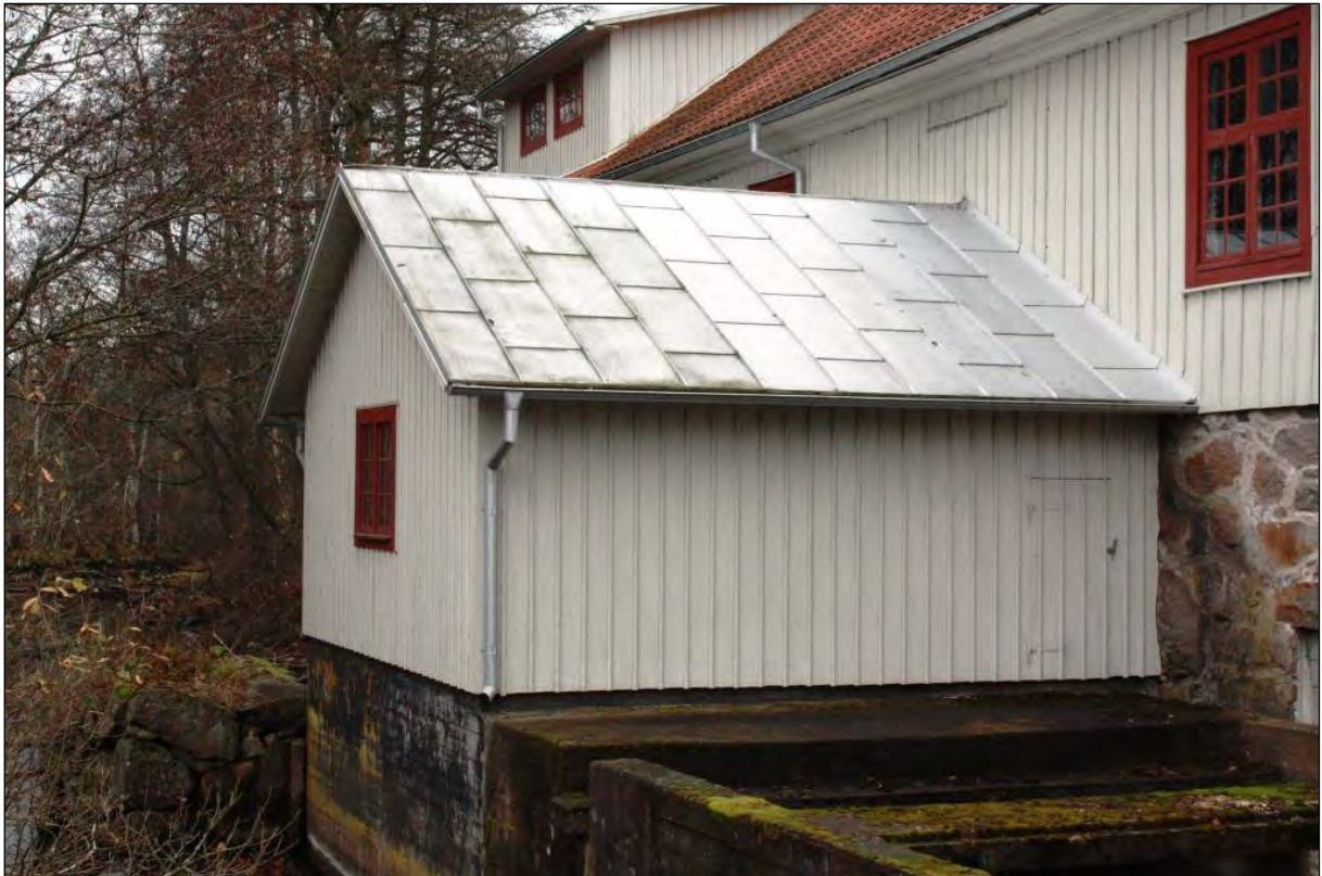
Bild 4. Det utbyggda turbinhuset.
