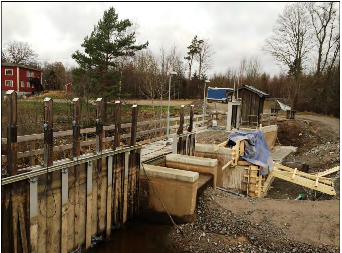
Bild 4. Automatiskt reglerade planluckor.
