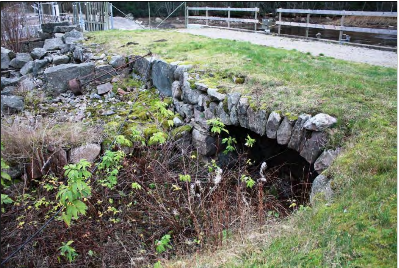
Bild 6. Husgrund från en tidigare kvarn och välvd öppning i muren för intagskanalen till kvarnen.
