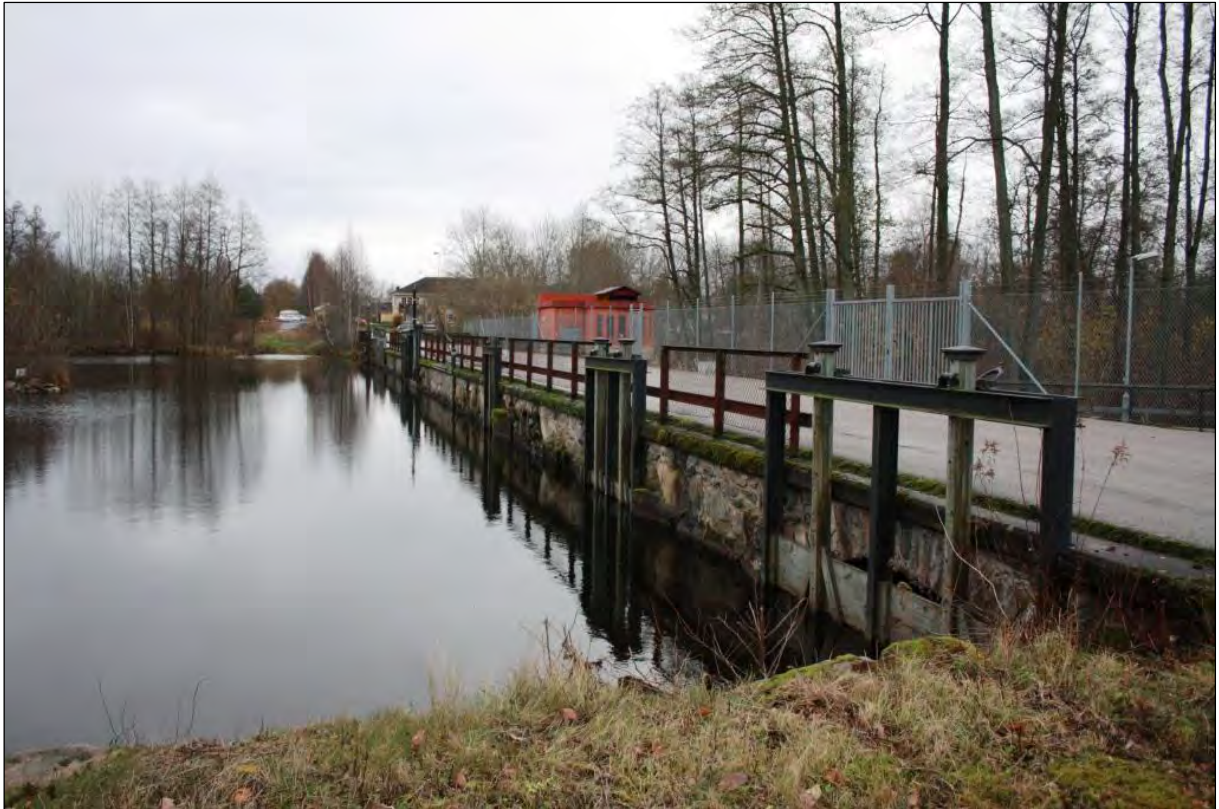
Bild 5. Skalmursdamm i sten med flera utskov.
