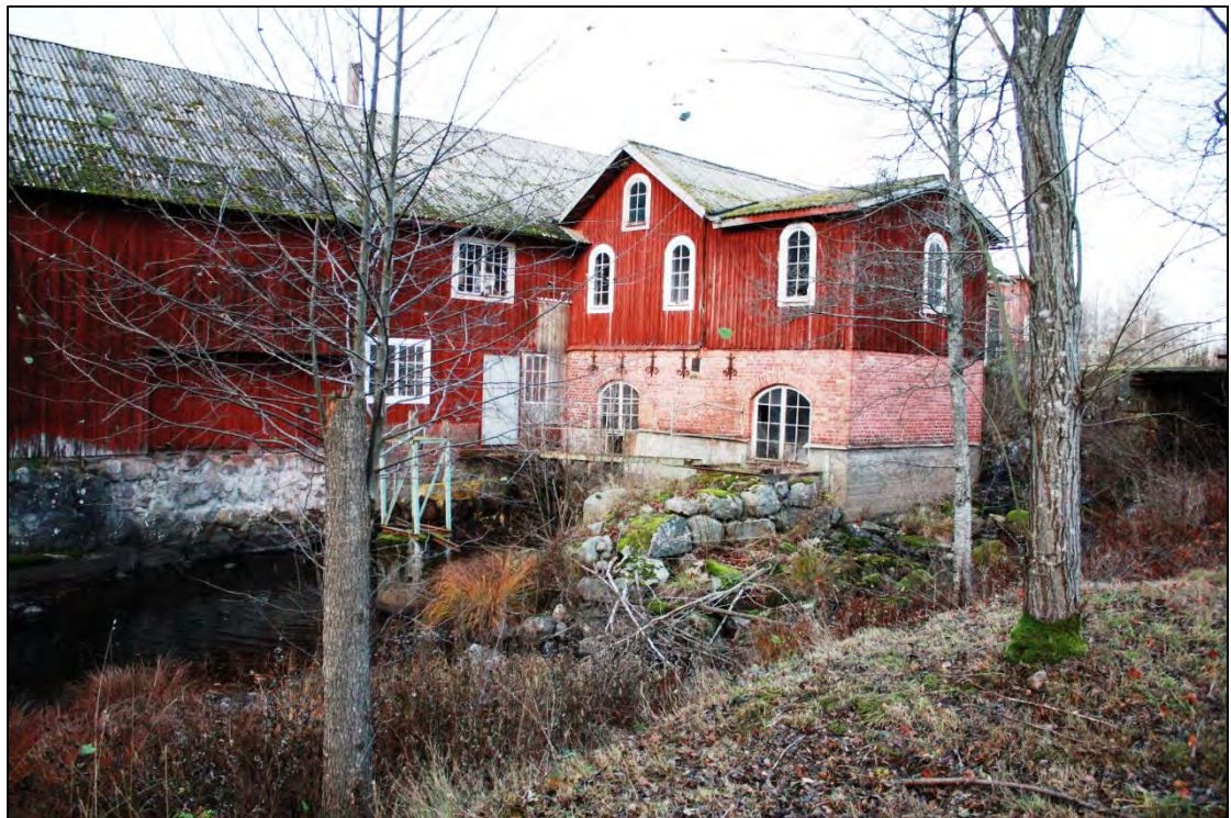
Bild 8. Utloppskanalen efter turbinhuset från sågen, här sett söderifrån.
