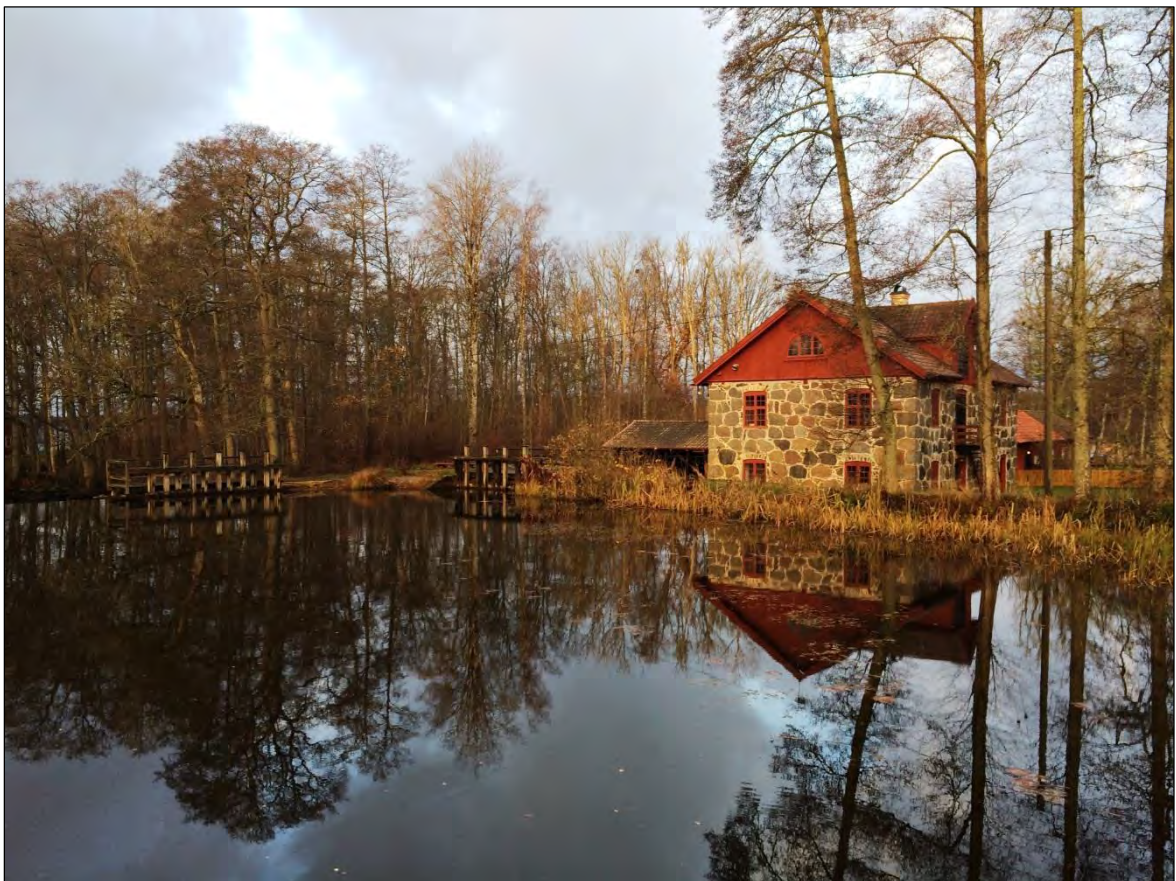
Bild 4. Dammen och intagsluckor till vattenhjulet samt regleringsluckor för dammen.
