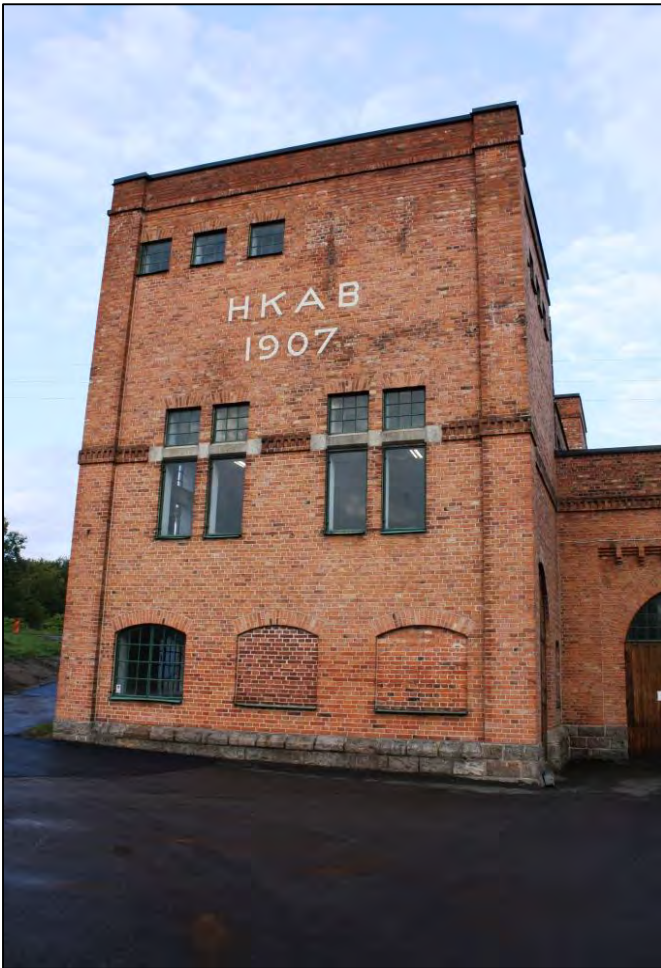
Bild 7. Hemsjö Kraft AB uppförde kraftstationen år 1907.
