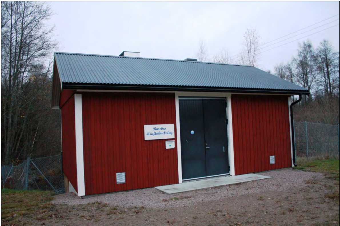
Bild 11. Den nya kraftstationen.
