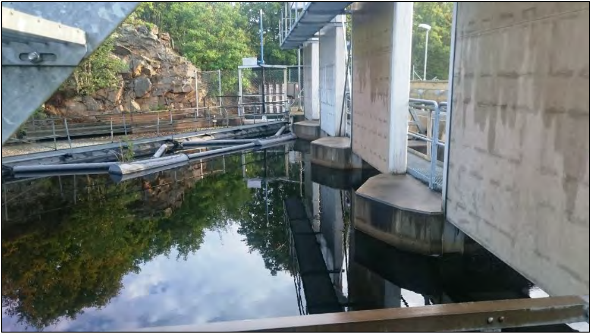
Bild 5. Vid kraftverksintaget finns pelarnosar som bryter eventuella isflak om vintern.
