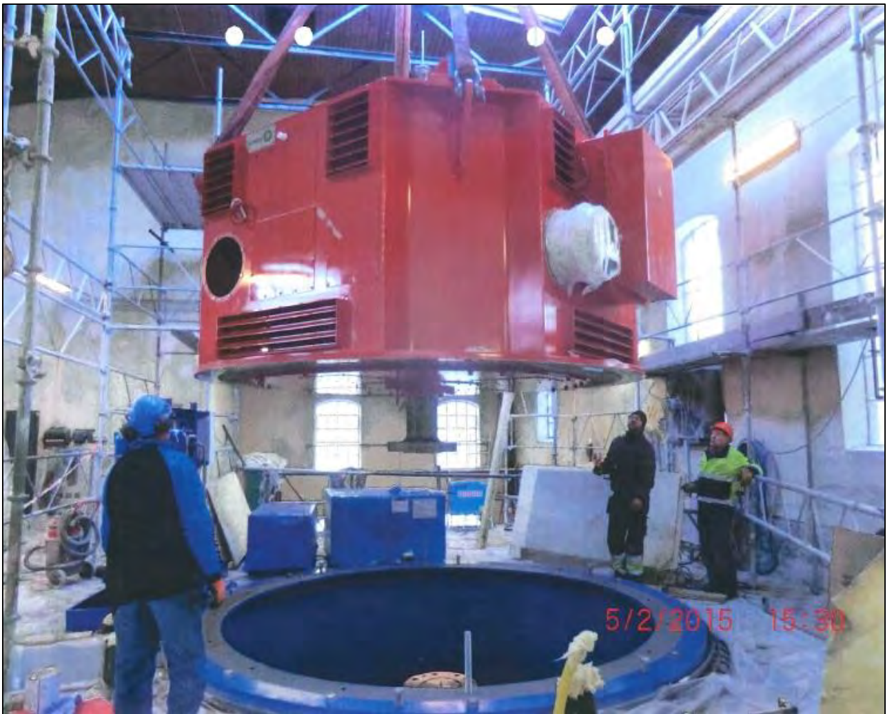
Bild 8. Inuti kraftstationen då generatorn sätts på plats. Bilden tillhör Frank Gunnarsson.
