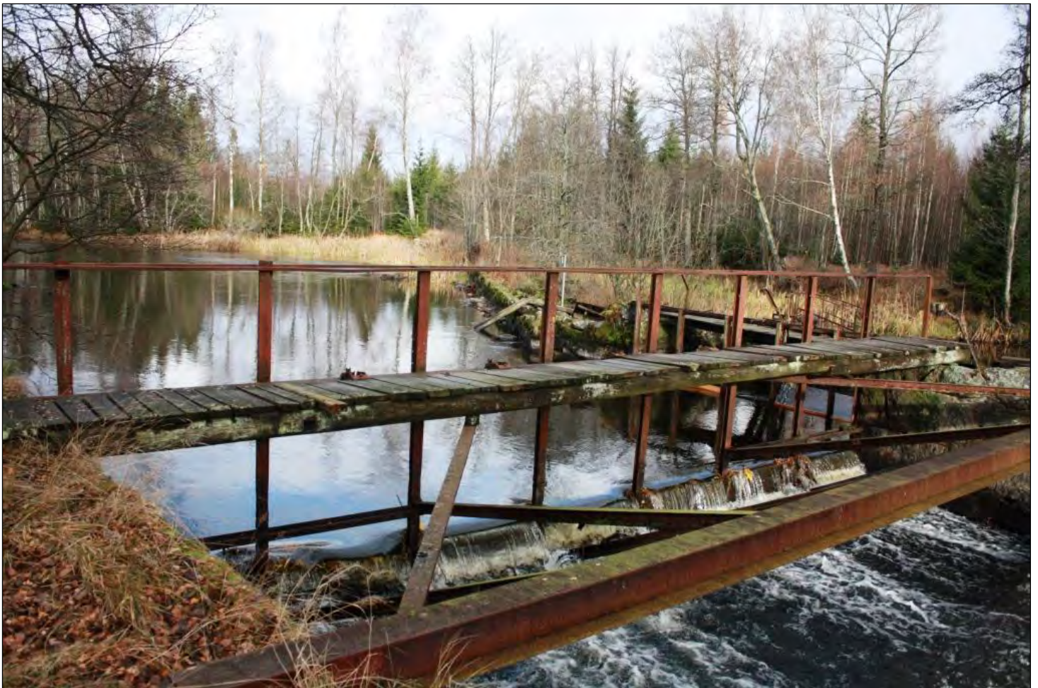
Bild 10. Ramar av järn där det tidigare troligen har suttit utskovsluckor.
