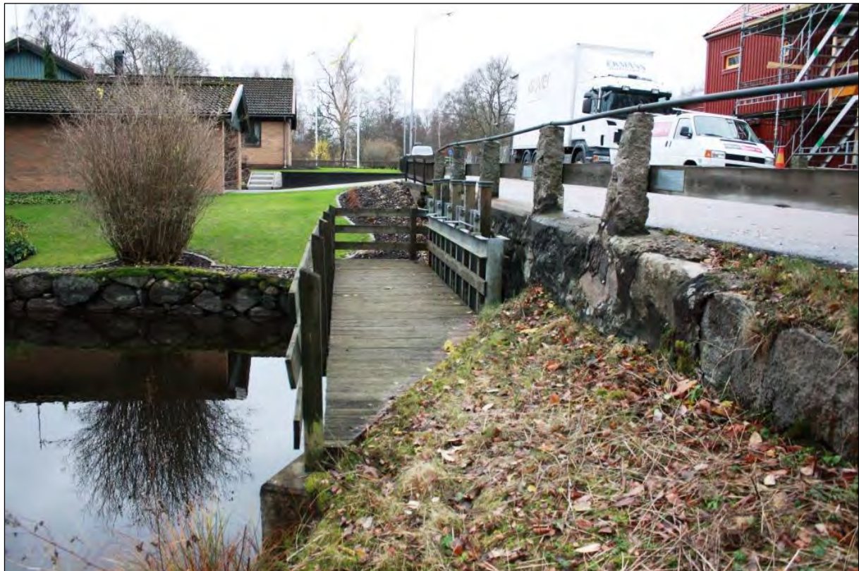
Bild 4. Fem spetluckor reglerar flödet till den f.d. kvarnkanalen.
