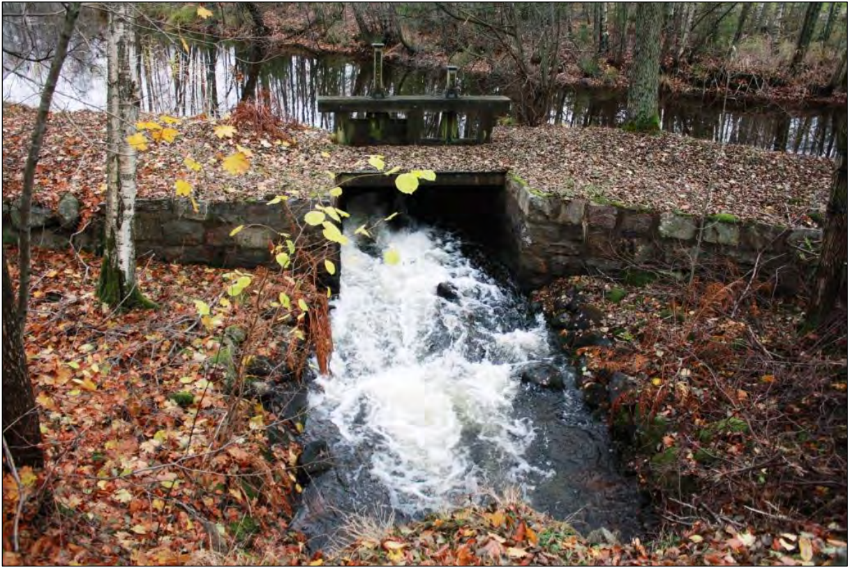
Bild 3. Här syns en del av stenstrukturen som omger dammen samt två spetluckor för reglering av vattenflödet.
