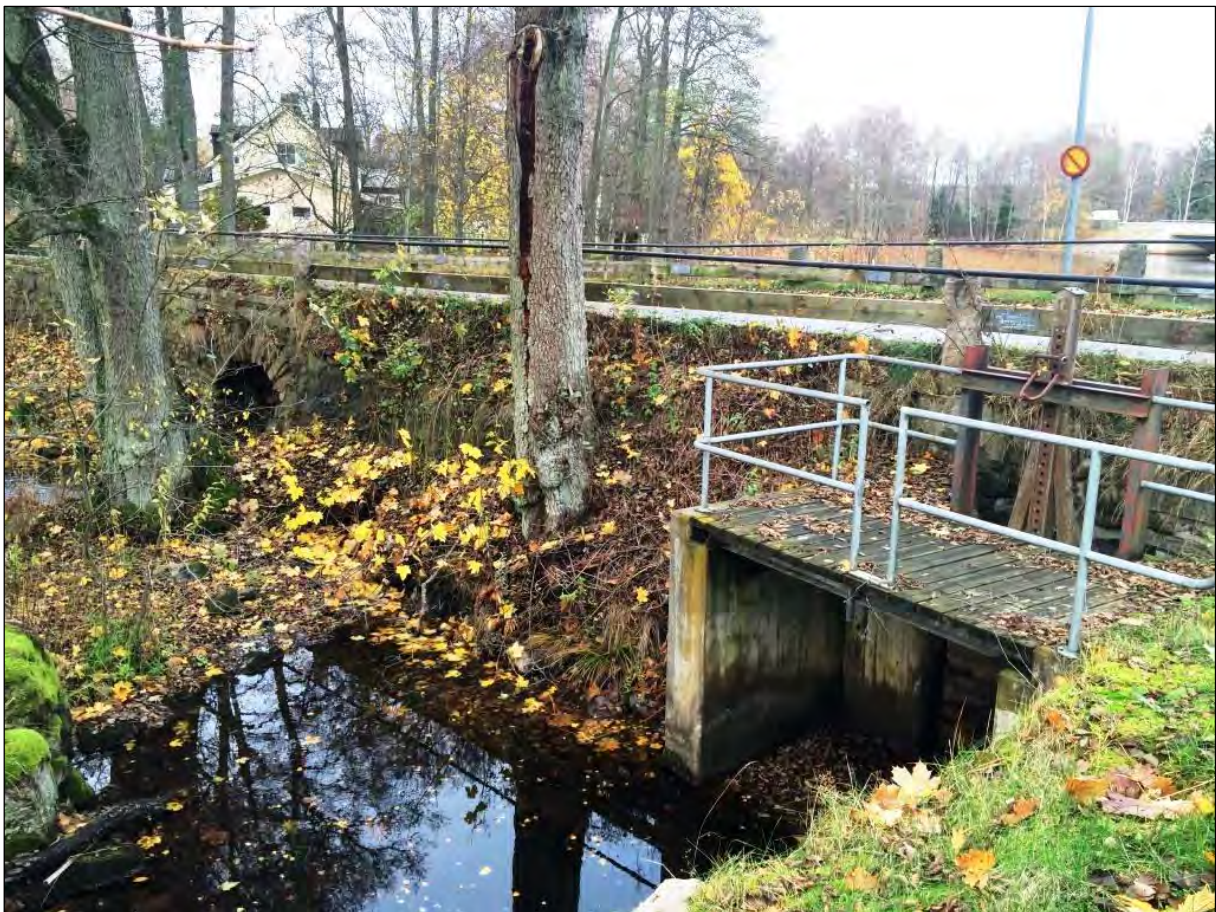
Bild 4. Skalmursdamm och kombinerad vägbro.
