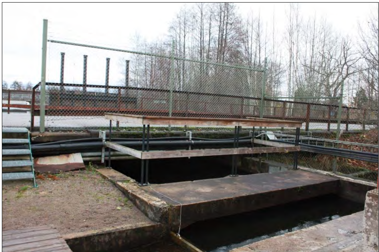
Bild 4. Intaget med betongsump till kraftstationen.
