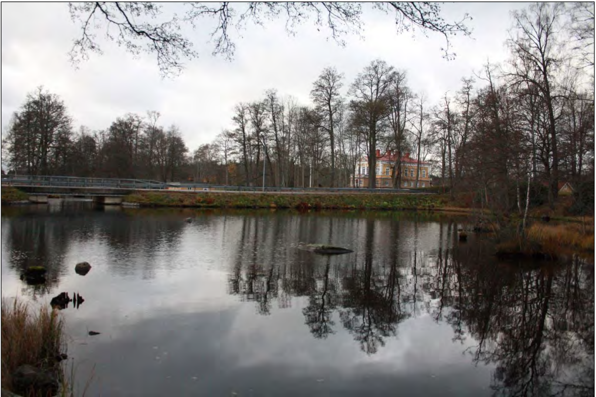
Bild 14. Delen av dammen som angränsar mot kvarnen, här sedd ifrån norr.
