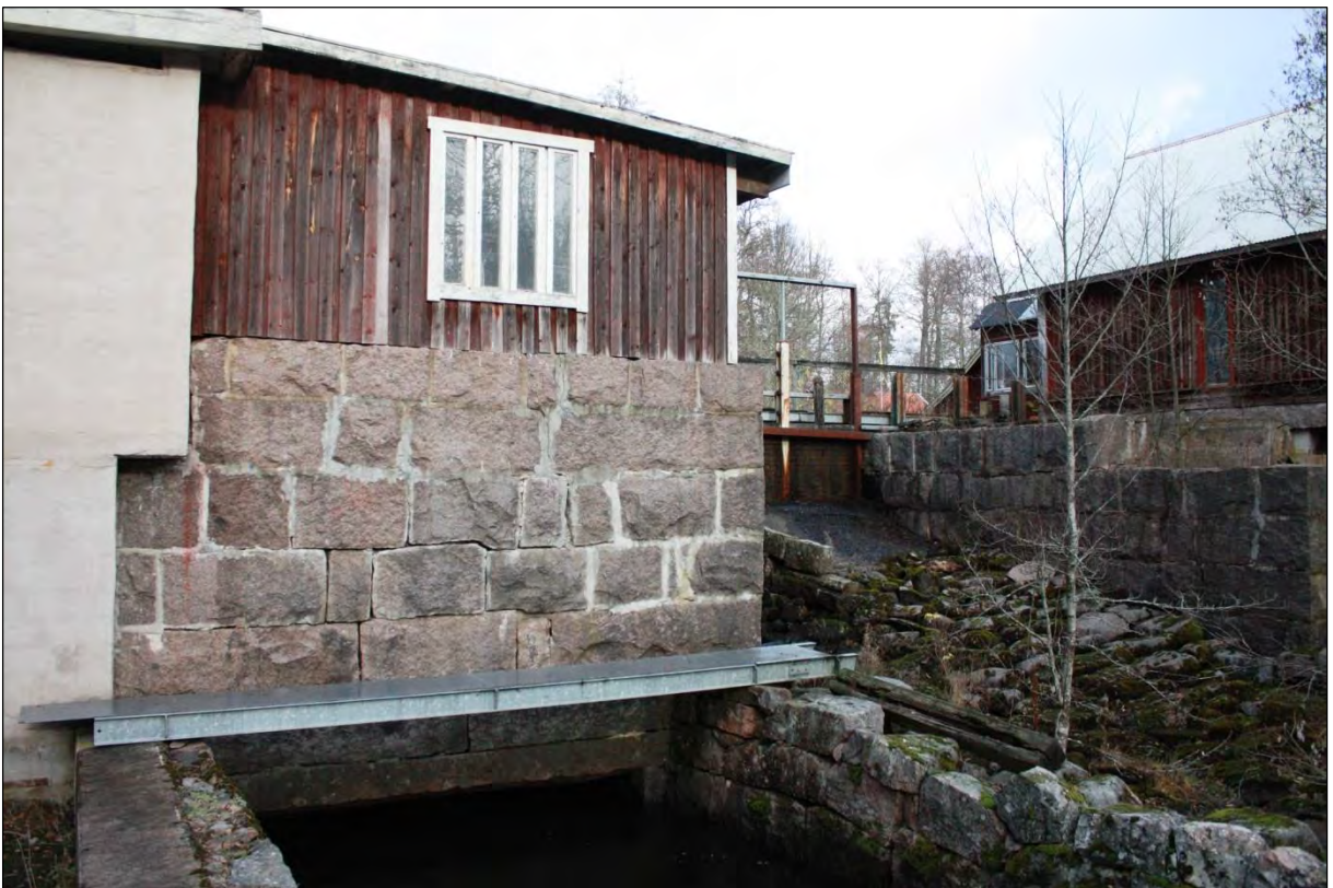
Bild 8. Kraftstationen och dess utloppskanal.
