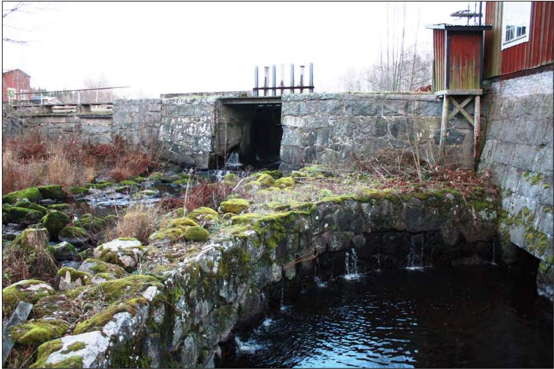
Bild 7. Dammvallen av murad sten som delvis är betongförstärkt.
