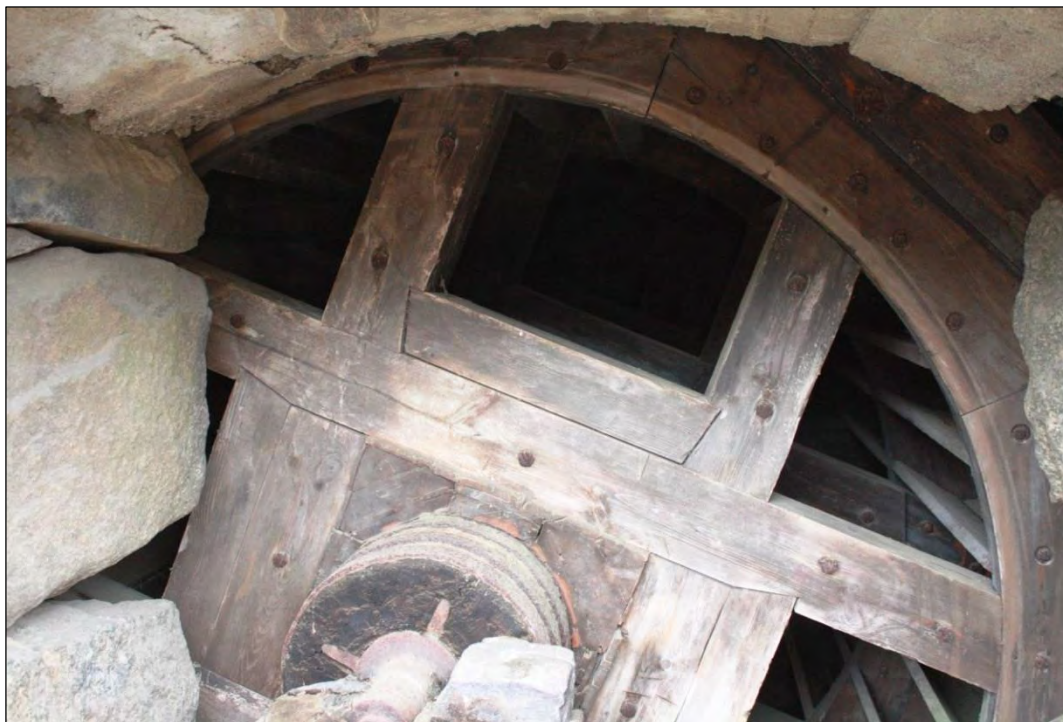
Bild 1. Här syns vattenhjulet som sitter inunder kvarnhuset och därmed skyddas väl. Kvarnkanalen går inunder huset och vattenhjulet är troligen ett underfallshjul.
