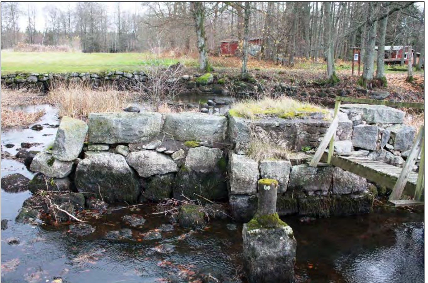
Bild 6. Delar av betongfundament finns också i fåran.
