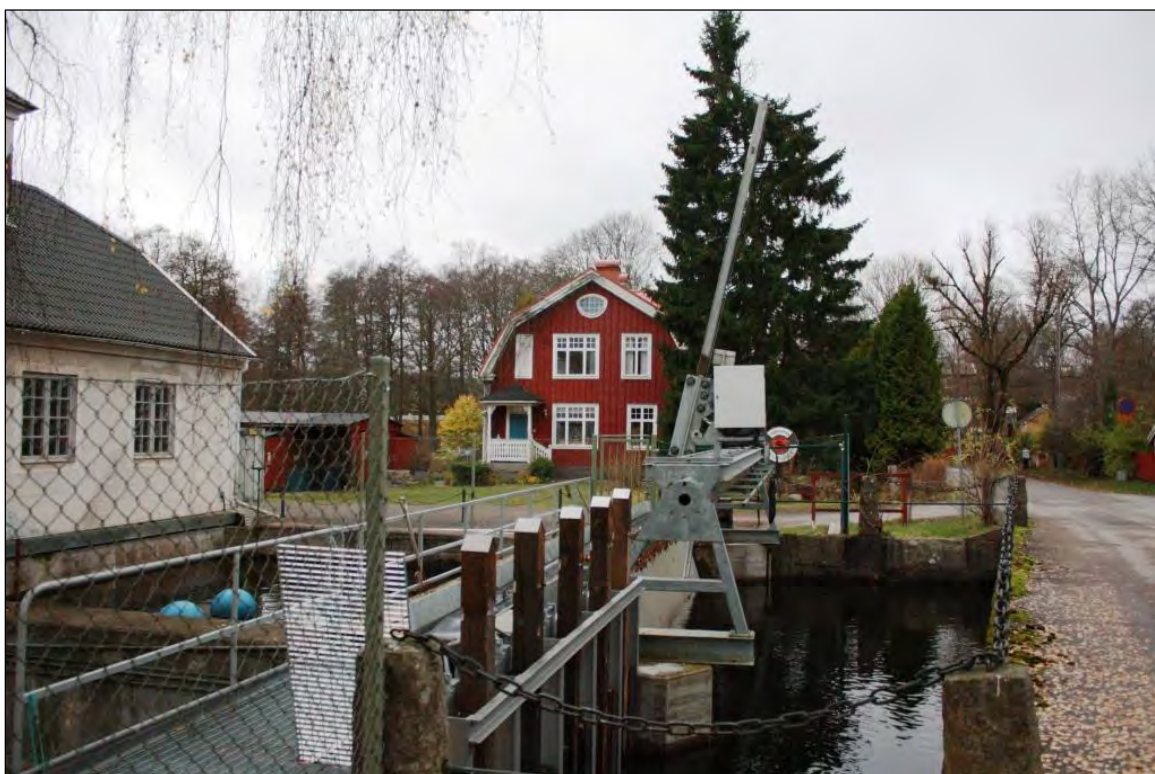
Bild 1 & 2. Kraftstationen och disponentsvillan angränsar till varandra. I bild syns även intaget till kraftstationen med betongsump.
