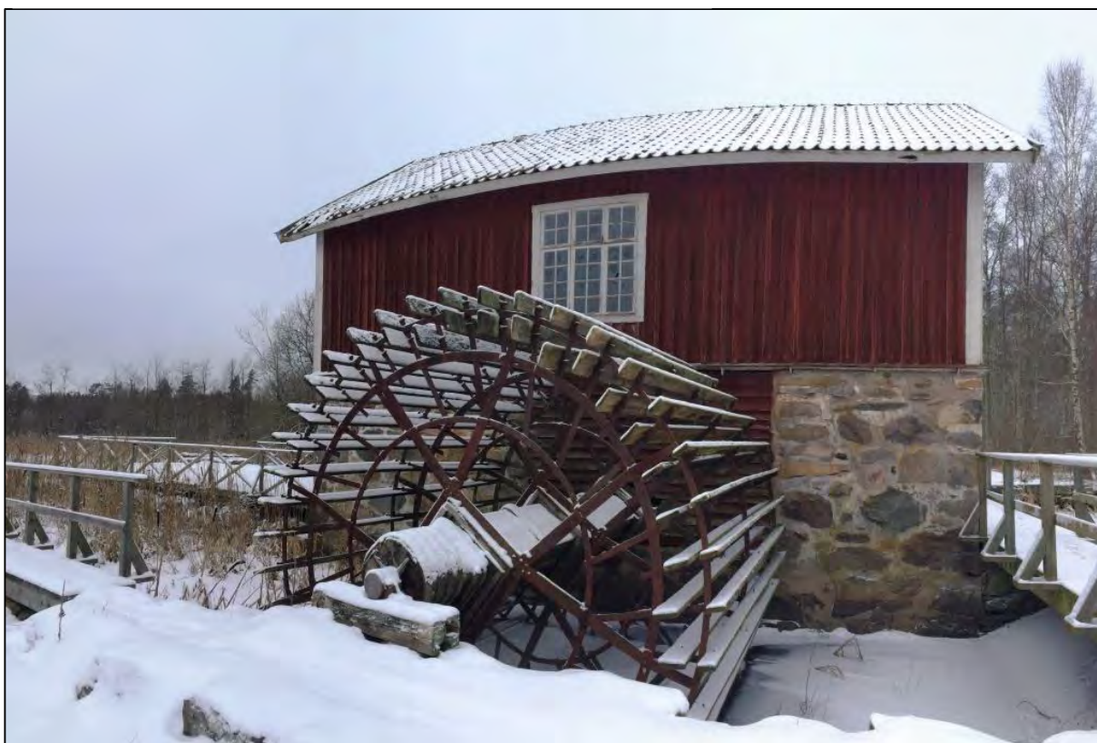
Bild 2. Den södra fasaden där vattenhjulet sitter.
