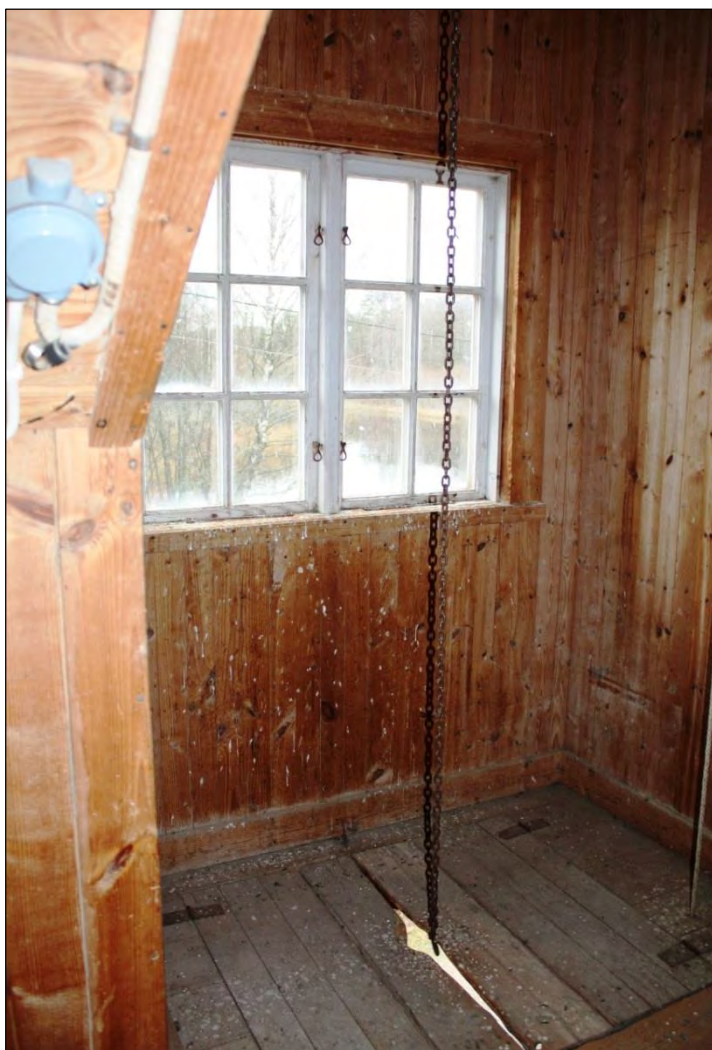
Bild 6. En kedja för att hissa upp och ner säckar.
