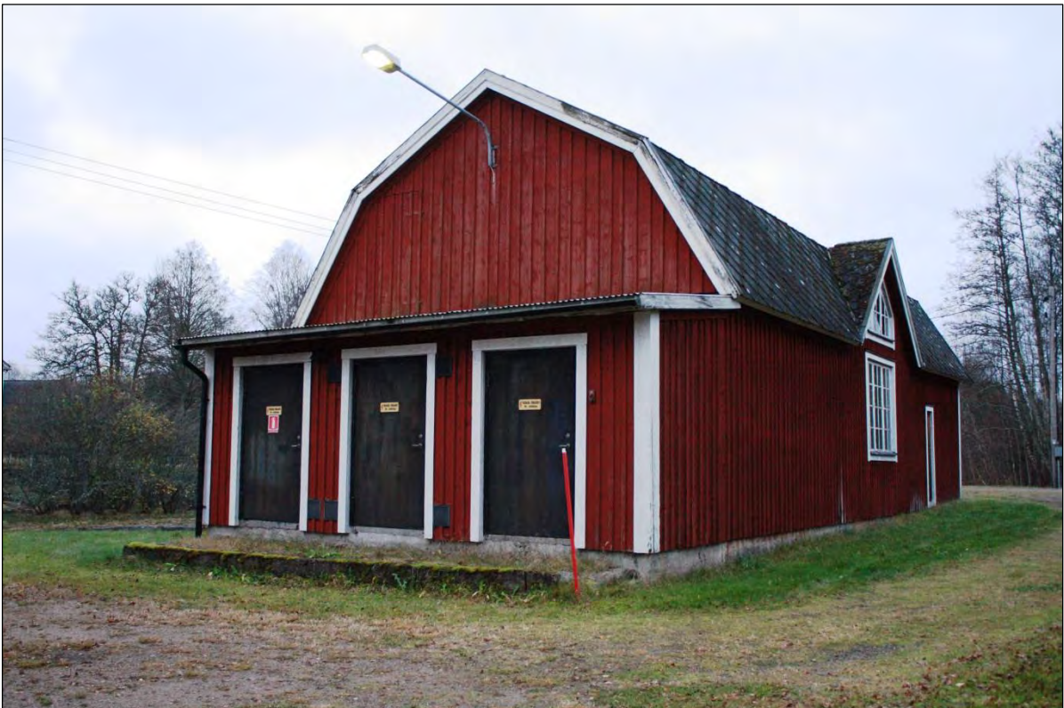
Bild 10. Tillbyggd del som gränsar mot den nya kraftstationen.
