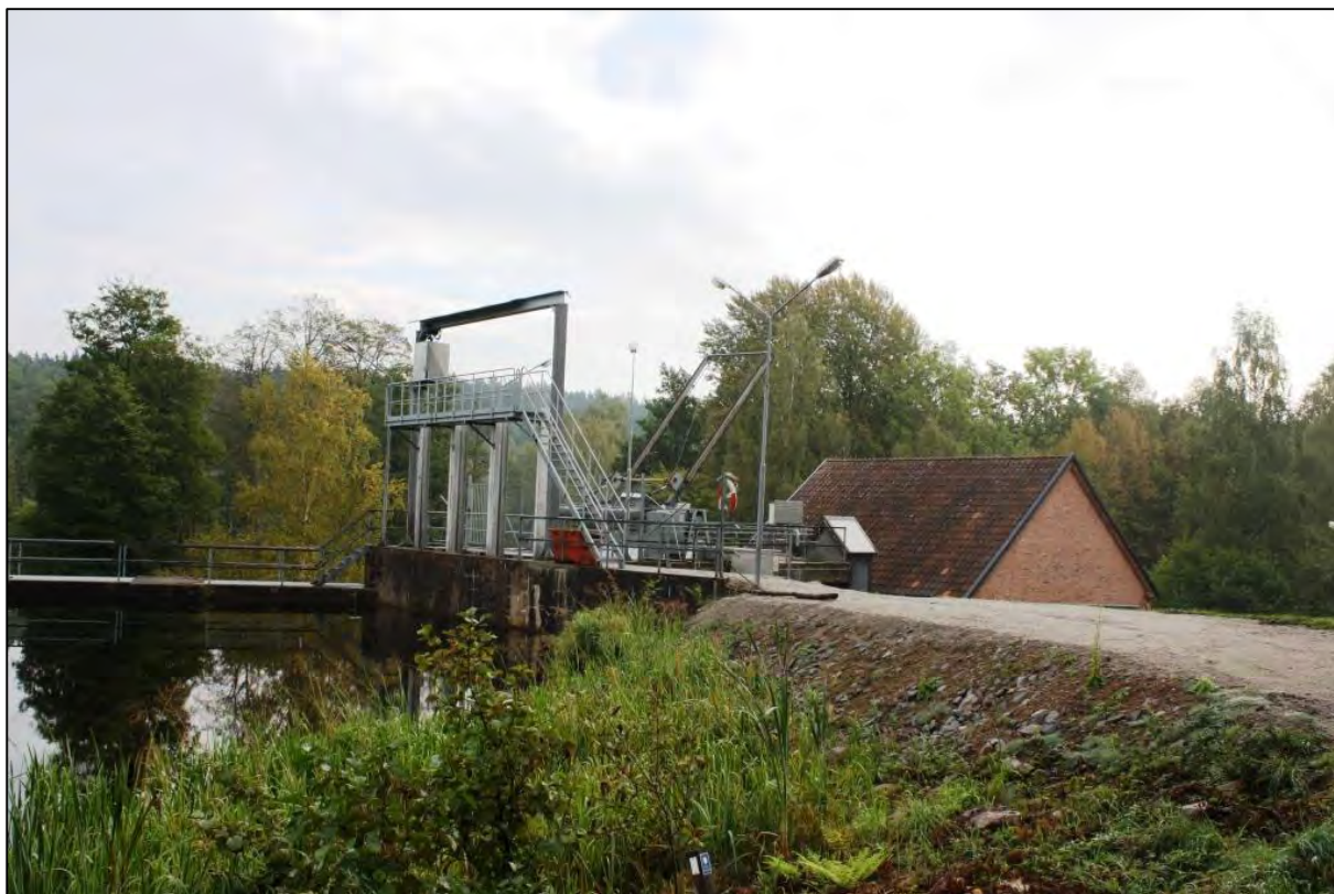
Bild 2. Skalmursdamm där kraftverksintaget regleras med tre automatiserade luckor.
