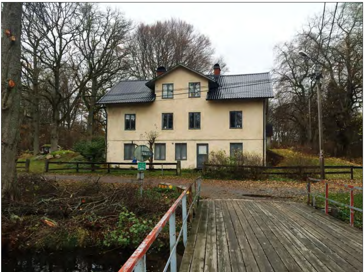
Bild 7 & 8. Angränsande byggnader till slussen, sekelskiftesvilla och en yngre villa från 1930-40-talet, möjligen har den använts som kontor.
