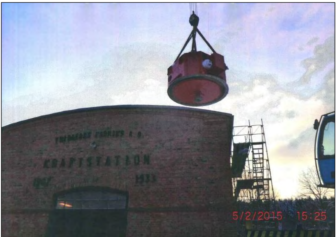
Bild 6. Generator lyfts på plats. Bilden tillhör Frank Gunnarsson.
