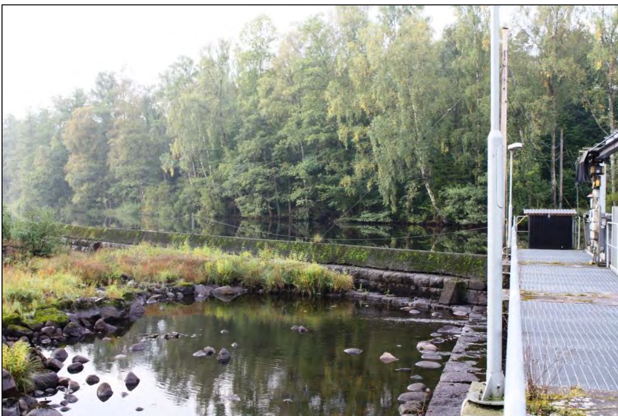
Bild 2. Dambyggnadens västra arm i tuktad sten och betong leder vatten till kraftverksintaget.
