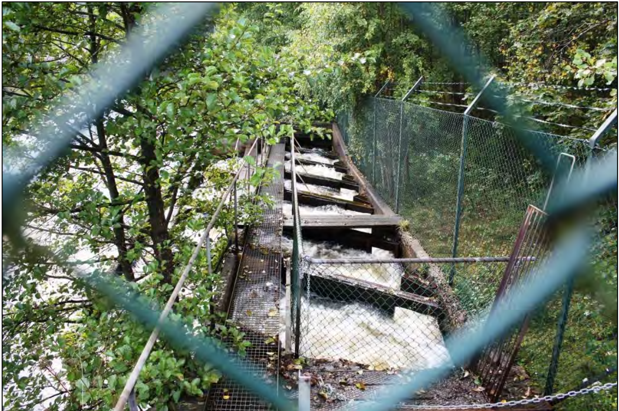
Bild 8. Kammartrappan vid Mariebergs kraftverk.
