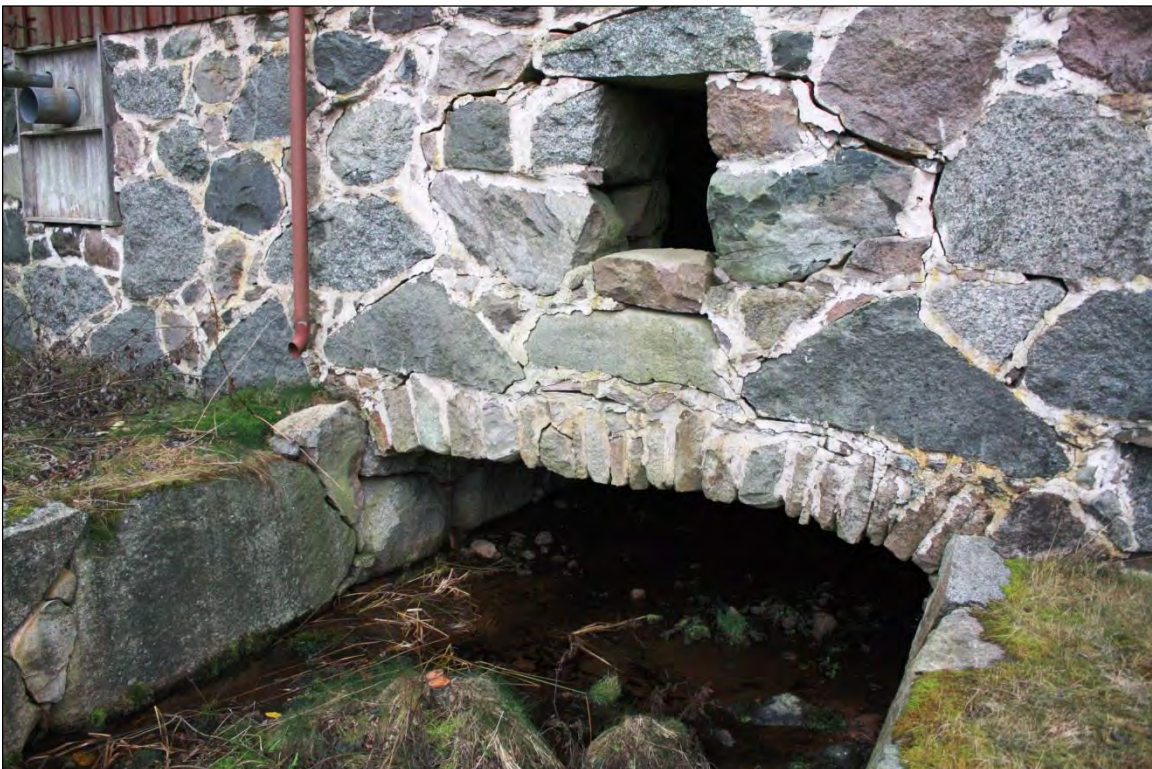
Bild 14. Uttaget från kvarnhuset, en kanal med vattenhjul finns under huset.
