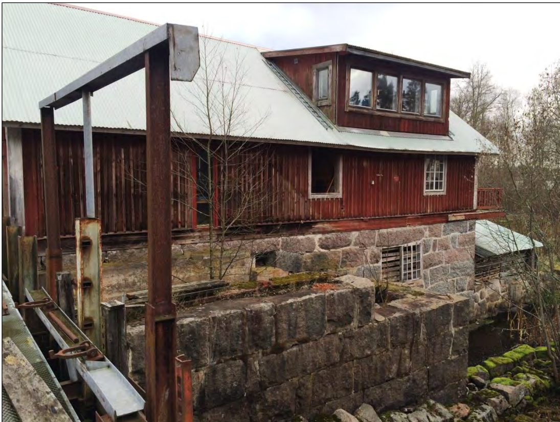
Bild 6. Turbinsumpen som är uppbyggd intill kvarnhuset.
