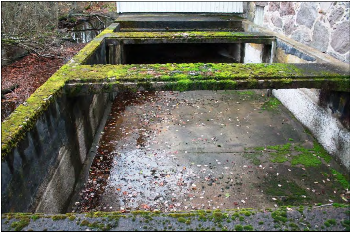
Bild 5. Betongsumpen till turbinhuset.
