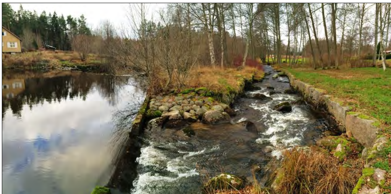
Bild 1 & 2. Dammspegeln med överfall och den angränsande norra fåran som numera fungerar som fiskväg.
