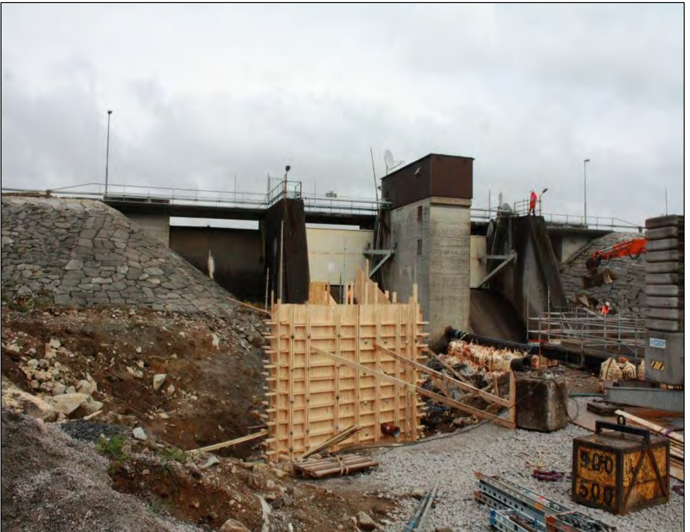
Bild 12. Dambyggnaden vid Granö kraftstation under ombyggnad.
