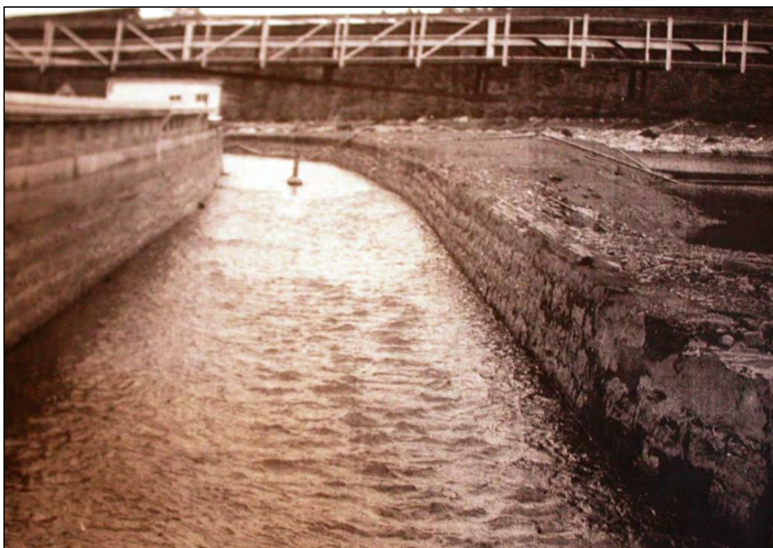
Historisk bild 5. Tömning av den övre dammen år 1960. I fotografiet syns intagskanalen till vänster som troligen försvann i en kort tid därefter. Bilden tillhör Fridafors fritidscenter.
