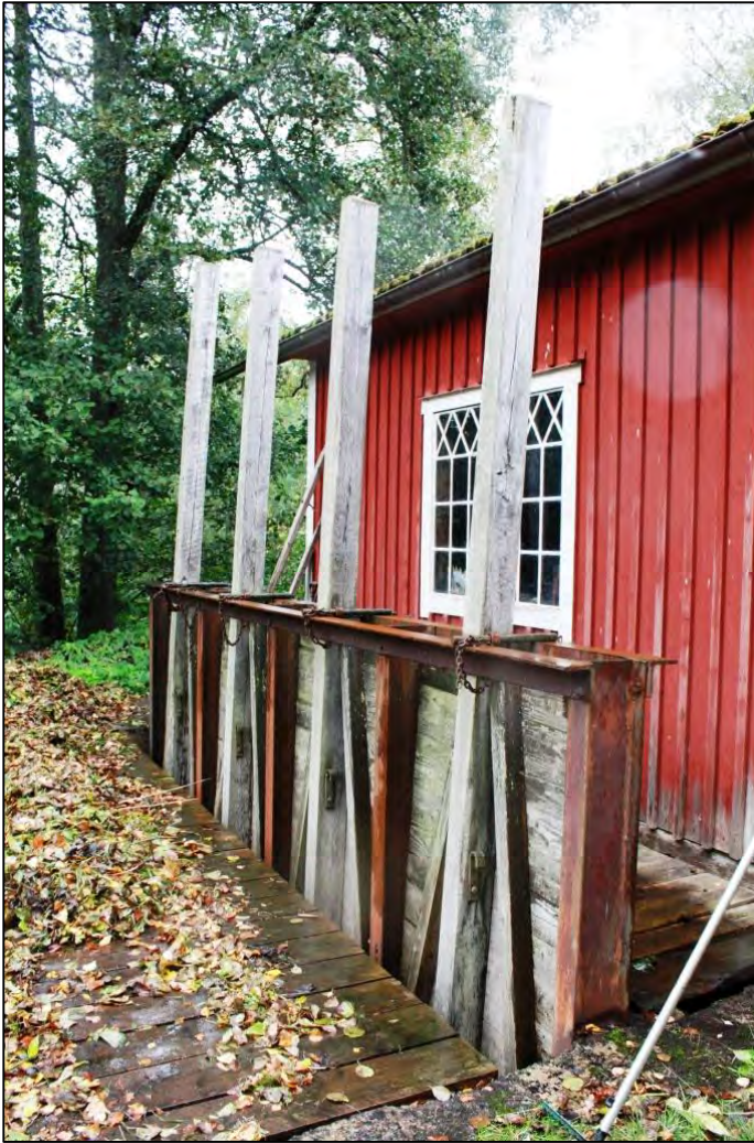
Bild 9. Fyra spettluckor i trä med gåtar i järn reglerar turbinintaget.
