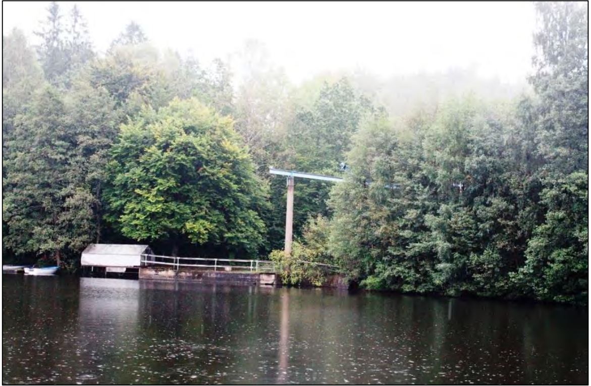
Bild 5. Del av den travers som har gått över intagskanalen, en barkanläggning angränsade tidigare till denna.
