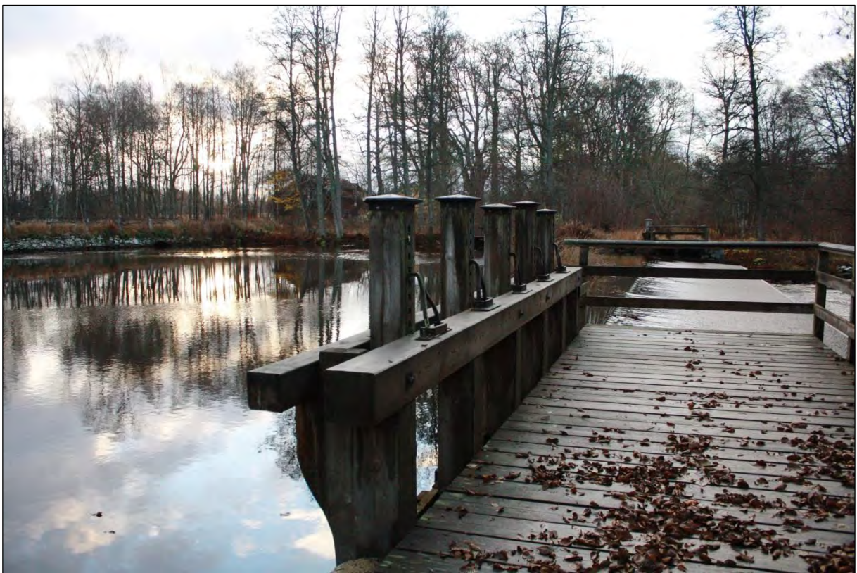
Bild 6. Regleringsluckor och skibordet.
