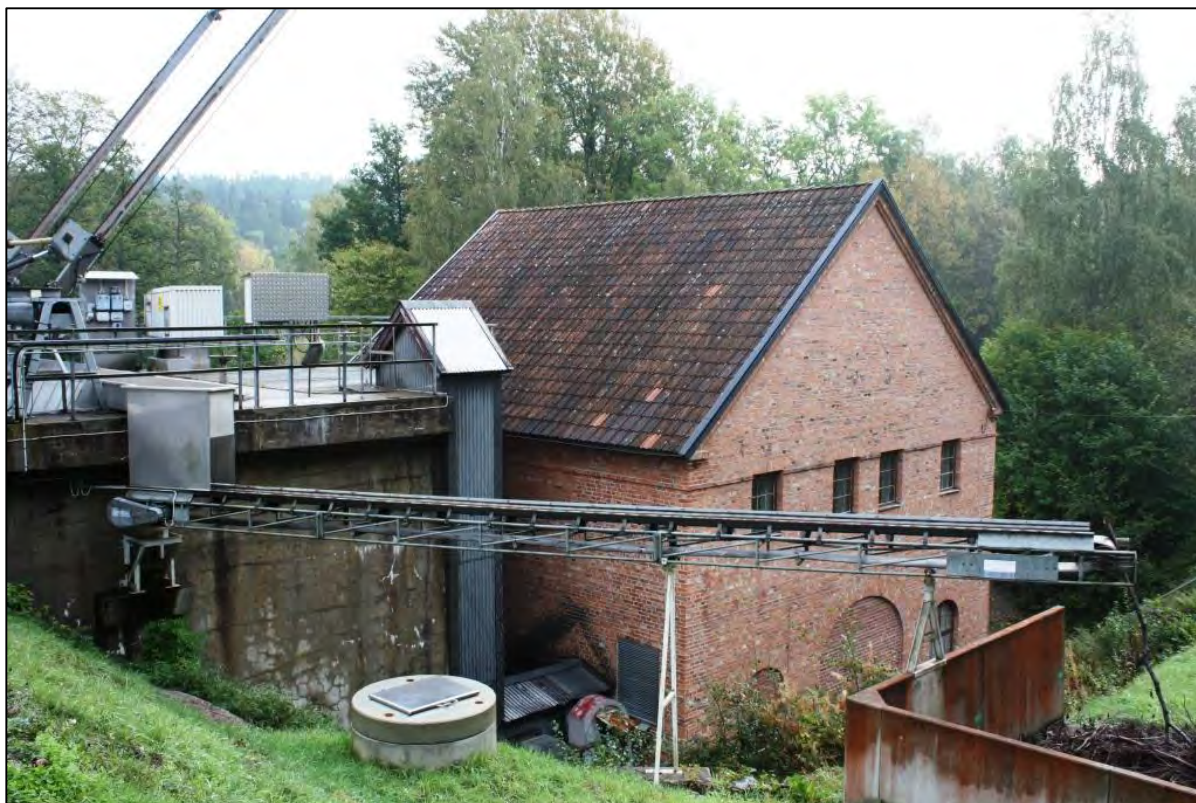
Bild 3. Den höga turbinumpen vid Hemsjö nedre kraftverk. Takfoten är av mönstermurad takgesims.
