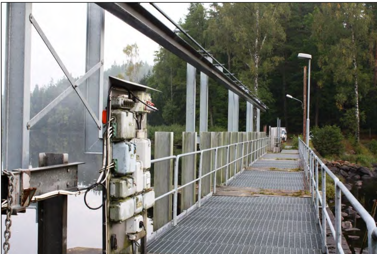
Bild 1. Luckor som reglerar vatten till åfåran och till intagskanalen vid Hemsjö övre.
