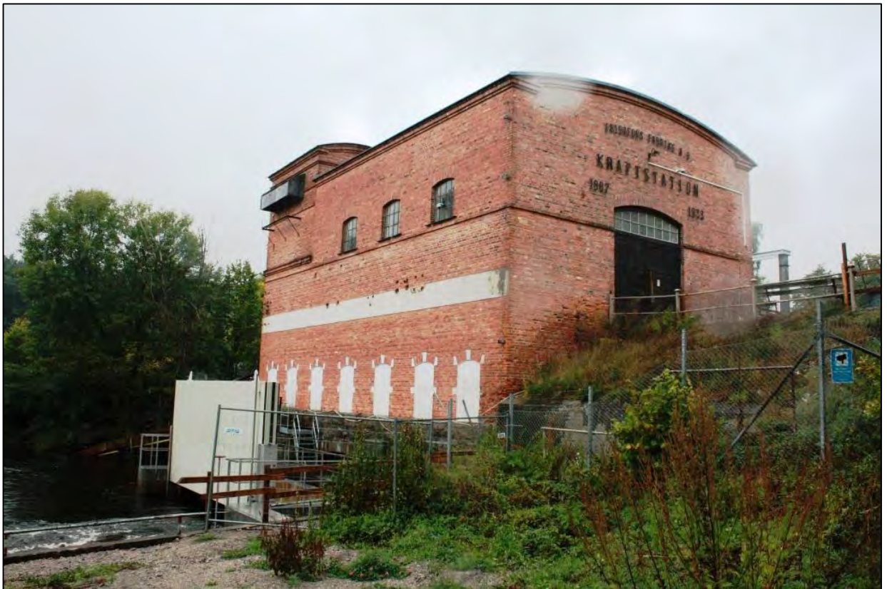
Bild 4. Kraftstationen sedd nerifrån utloppskanalen med nykonstruerade sugrör.
