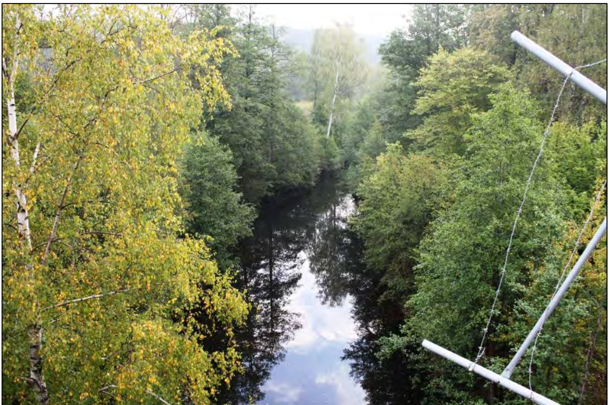
Bild 10. Utloppskanalen som leder bort bakvattnet från kraftstationen.
