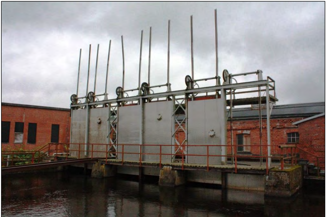
Bild 8. Intaget till turbinerna.
