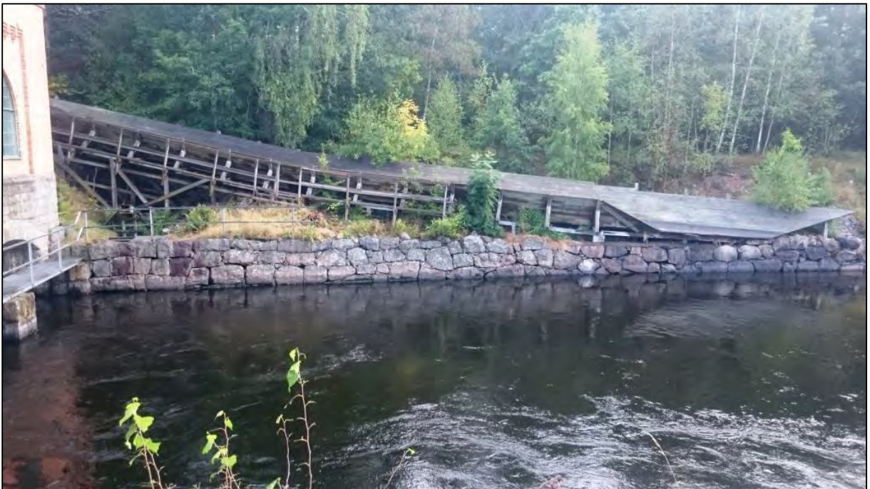
Bild 6. Trärännan som används för att leda bort is.
