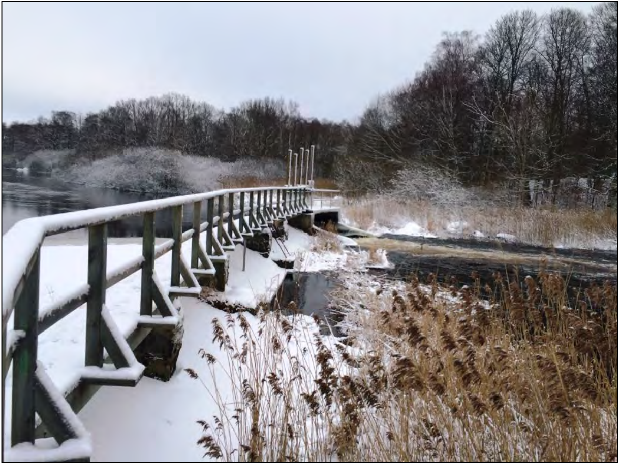
Bild 7 & 8. Utskovet med fem spettluckor som reglerar dammen.
