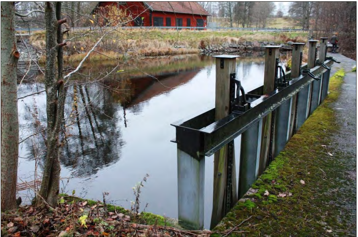
Bild 6. Spettluckor vid betongsumpen.
