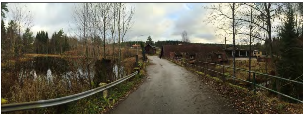
Bild 8. Den nedre dammen, nedanför den syns den tidigare spiksmedjan.
