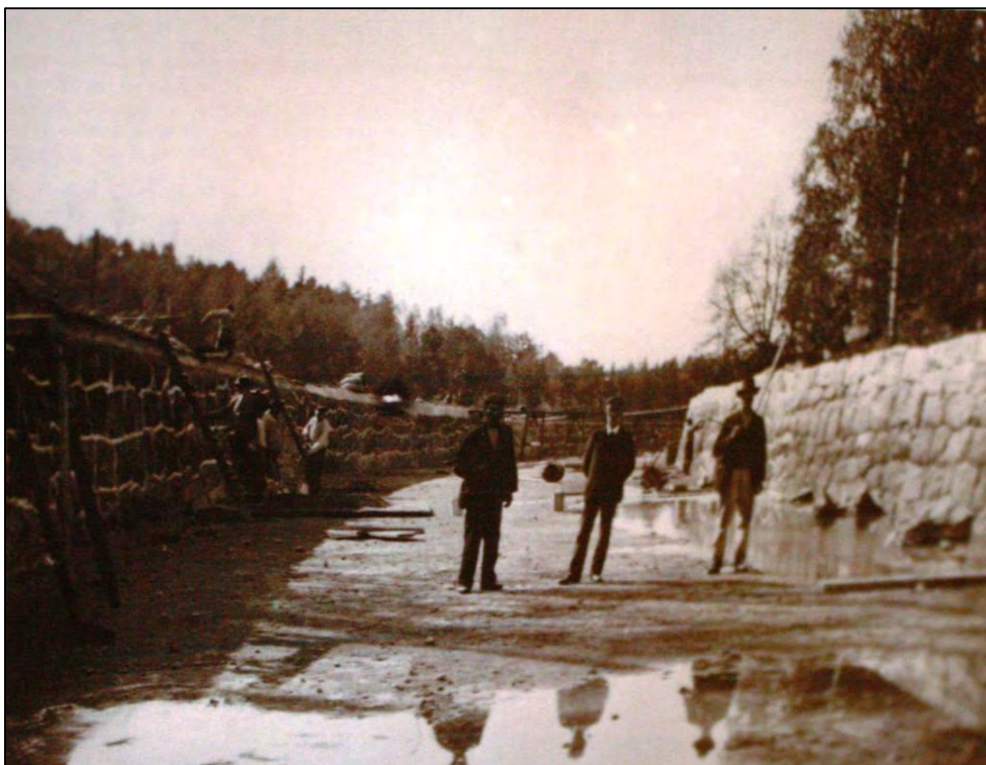
Historisk bild 3. Arbete med intagskanalen till kraftstationen, årtal okänt men troligen omkring år 1893 då kanalerna byggdes om. Bilden tillhör Fridafors fritidscenter.
