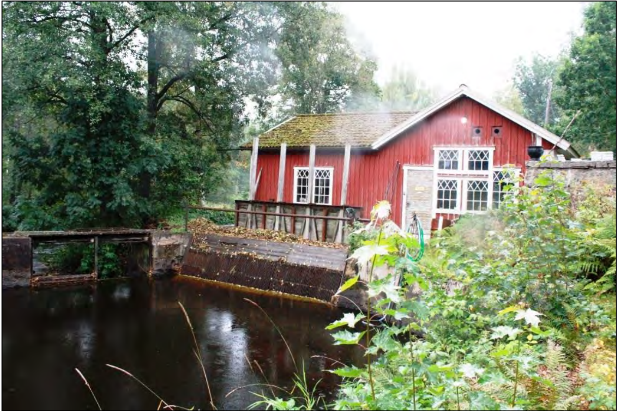
Bild 7. Intaget till kraftstationen vid Ebbamåla bruk. Vid sidan av kraftverksintaget finns ett intag till en eventuell tidigare ålkista.
