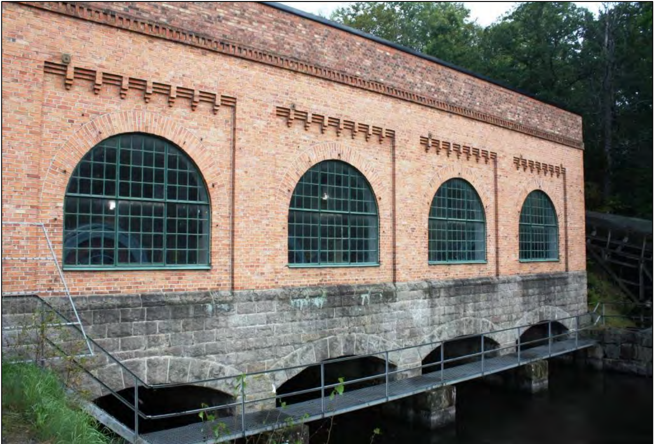
Bild 9. Baksidan av kraftverksbyggnaden med utskovsvalv i murad tuktad sten.
