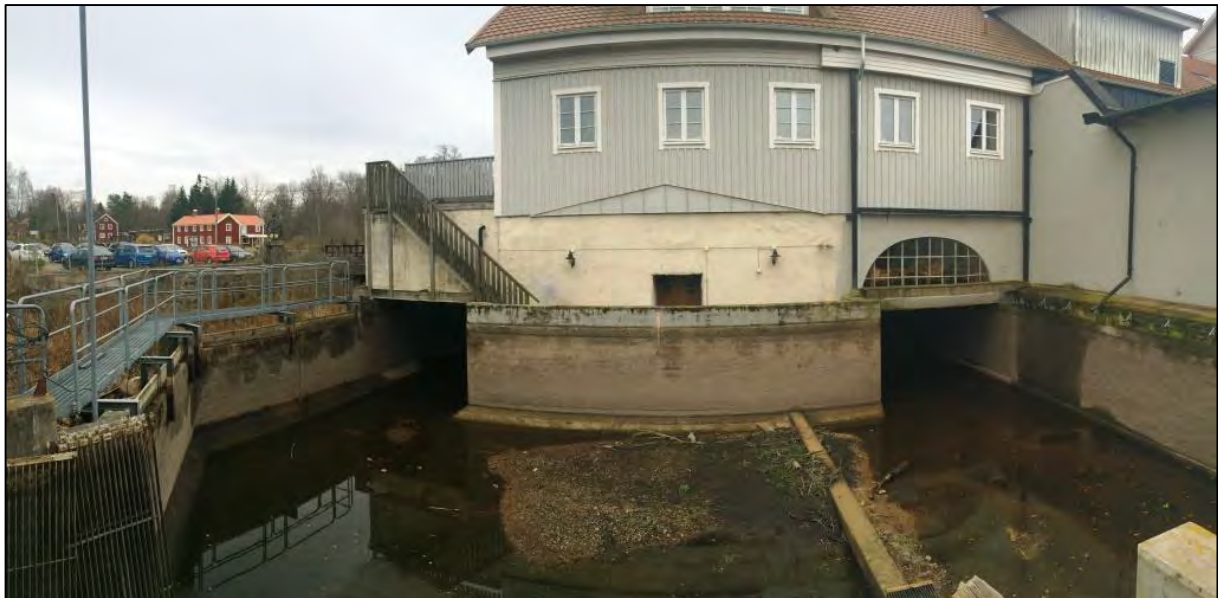
Bild 9. Betongsumpen med intag på två håll.
