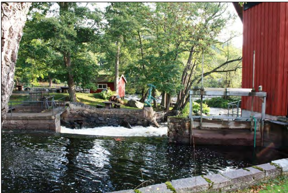
Bild 4. Intaget till den äldre kvarnen med överfallsskibord.
