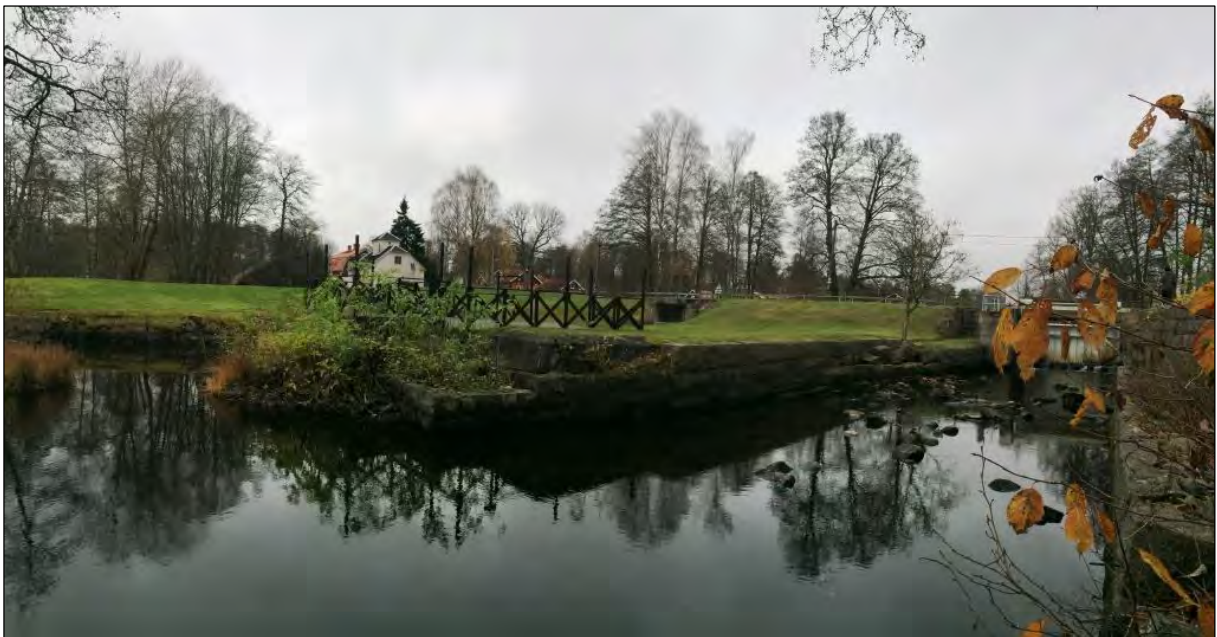
Bild 6. Vy över uttagskanalen och ytterligare en fåra för reglering av dammen.
