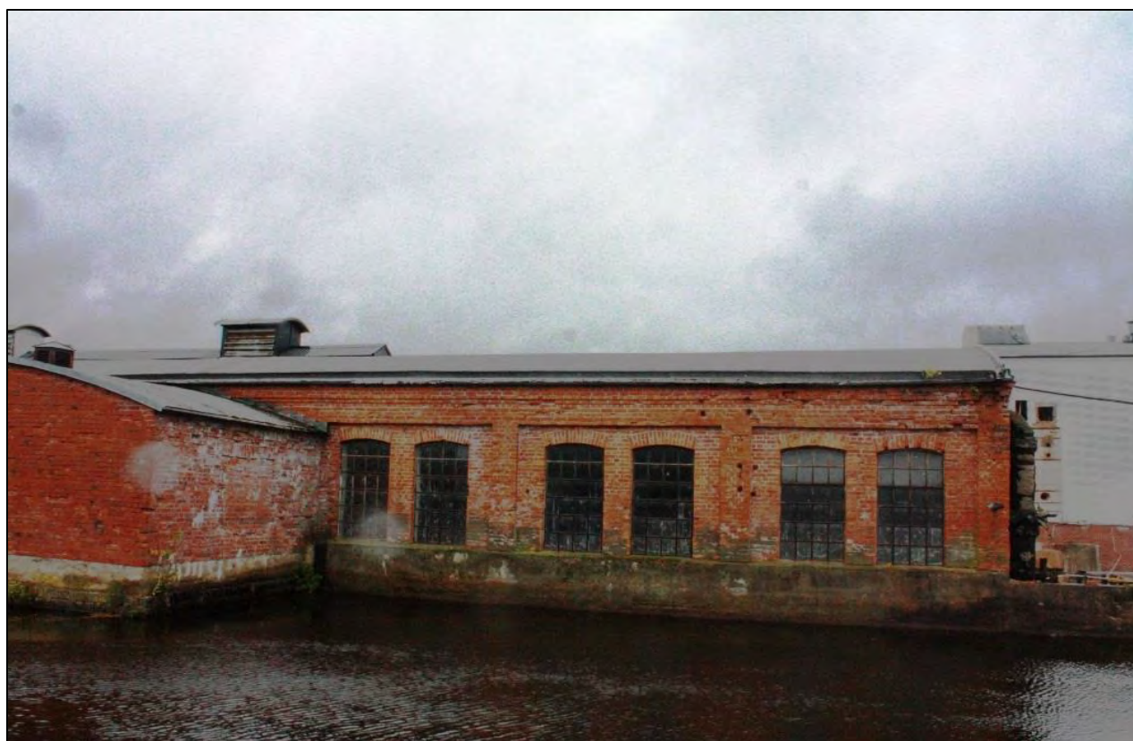
Bild 1 & 2. Fabriksbyggnaden för pappersbruket som byggdes 1894.
