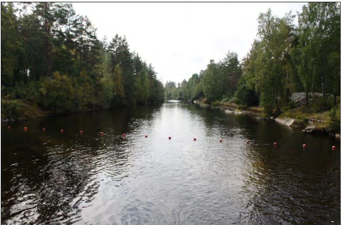
Bild 10. Intagskanalen som leder vatten till kraftstationen från Granödammen.
