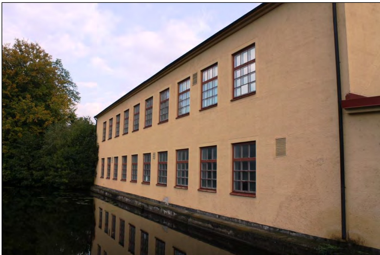
Bild 5. Äldre industribyggnad med slätputsad gul fasad.
