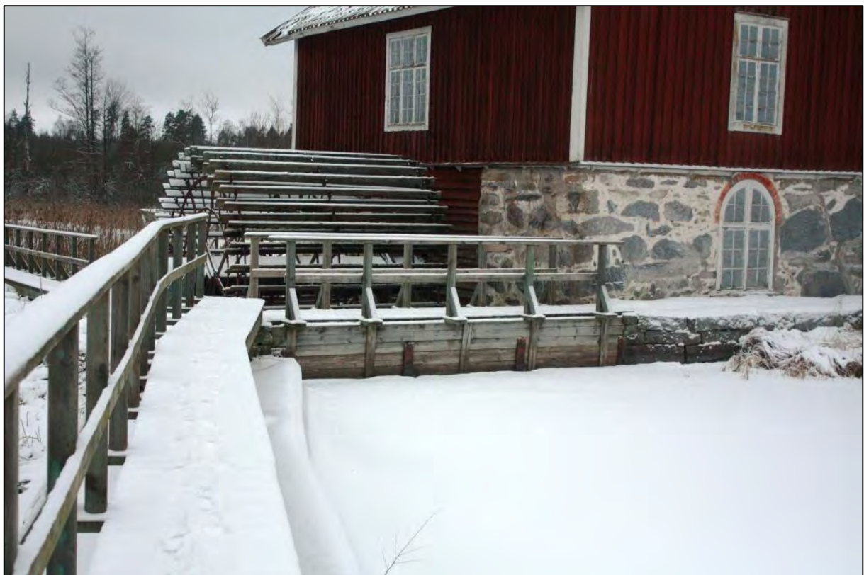
Bild 6. Intaget till kvarnens vattenhjul.
