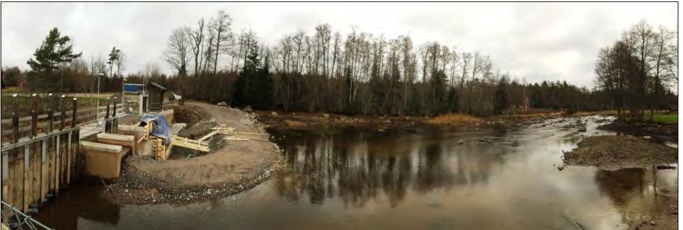
Bild 3. Vy över den övre dammen där vattenspegeln var avsänkt då vi var där.
