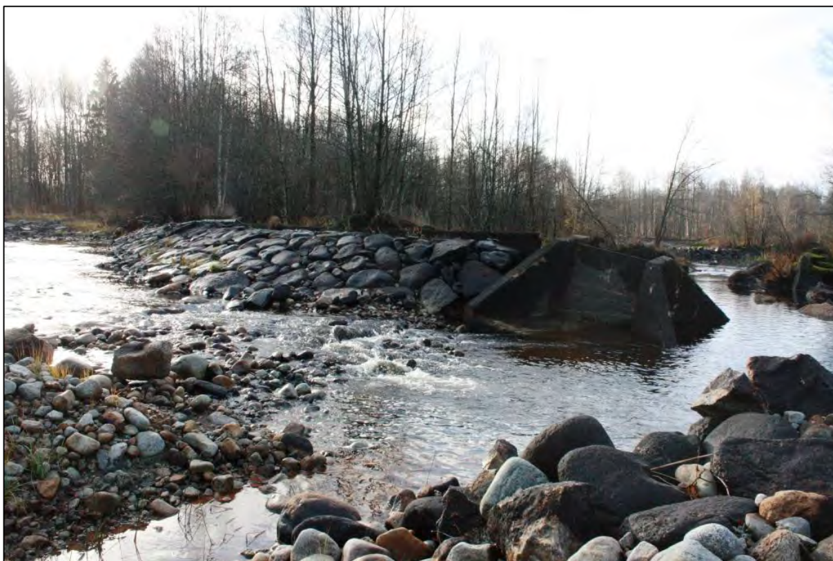
Bild 1 & 2. Dammen är avsänkt och i bilderna syns dammvallens ytterliv belagd med borrade stensblock.
