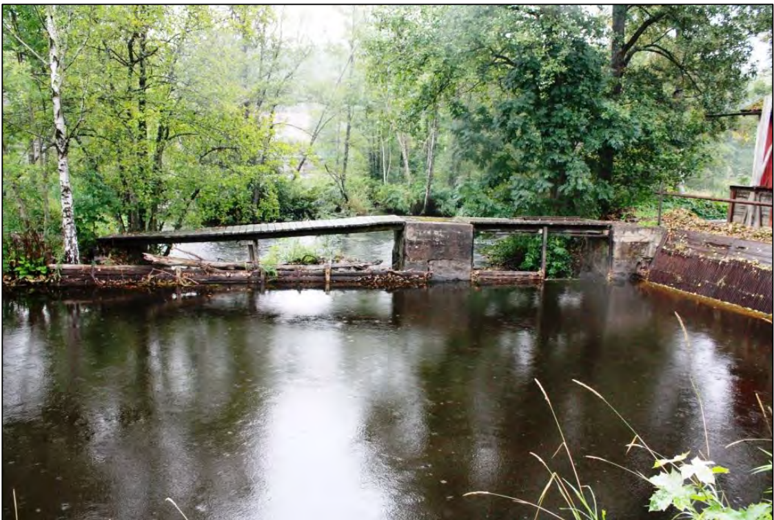
Bild 10. Vid sidan om turbinintaget finns sättreglerade reservutskov samt intag till en eventuell tidigare ålkista
