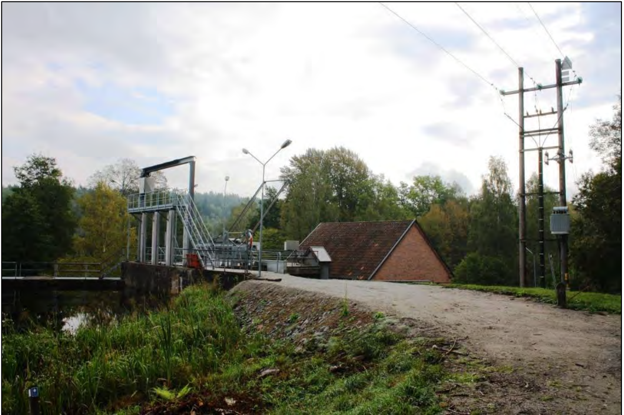
Bild 7. Höjdskillnaden syns här mellan intag och betongsump och kraftstationen.
