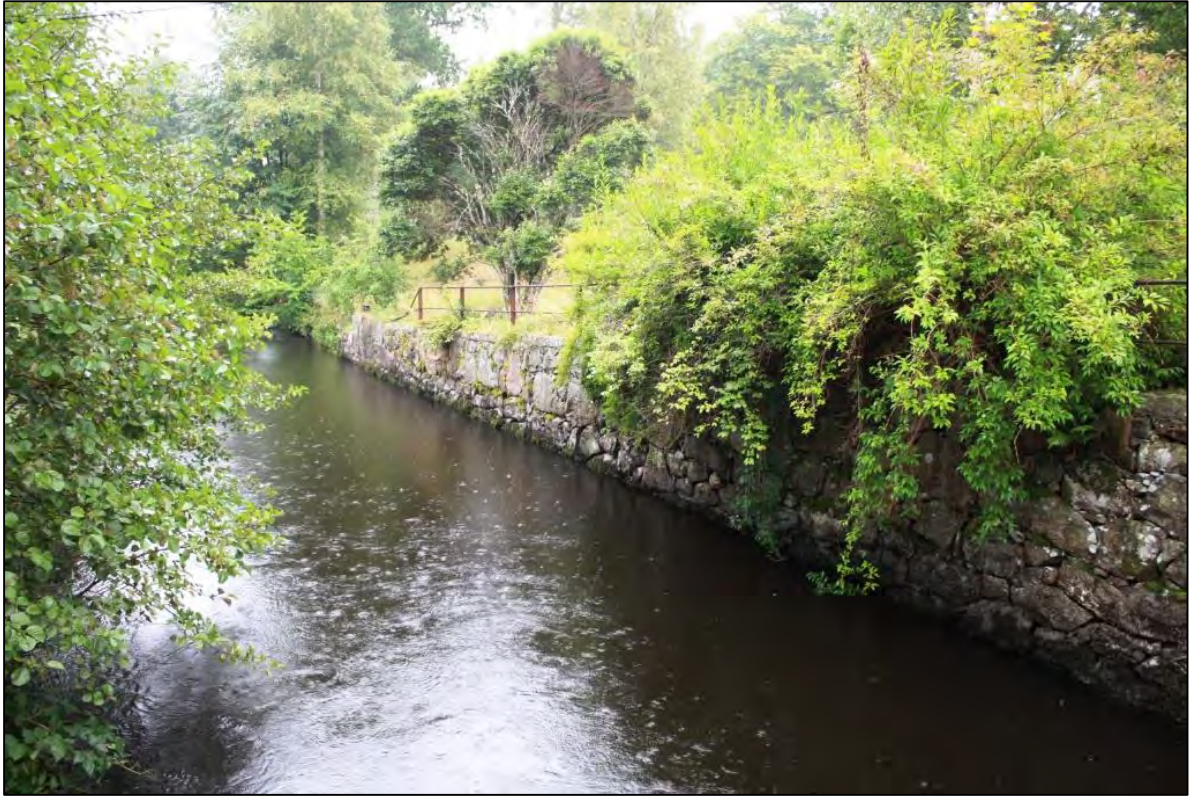
Bild 11. Den vällagda utloppskanalen i tuktad sten.
