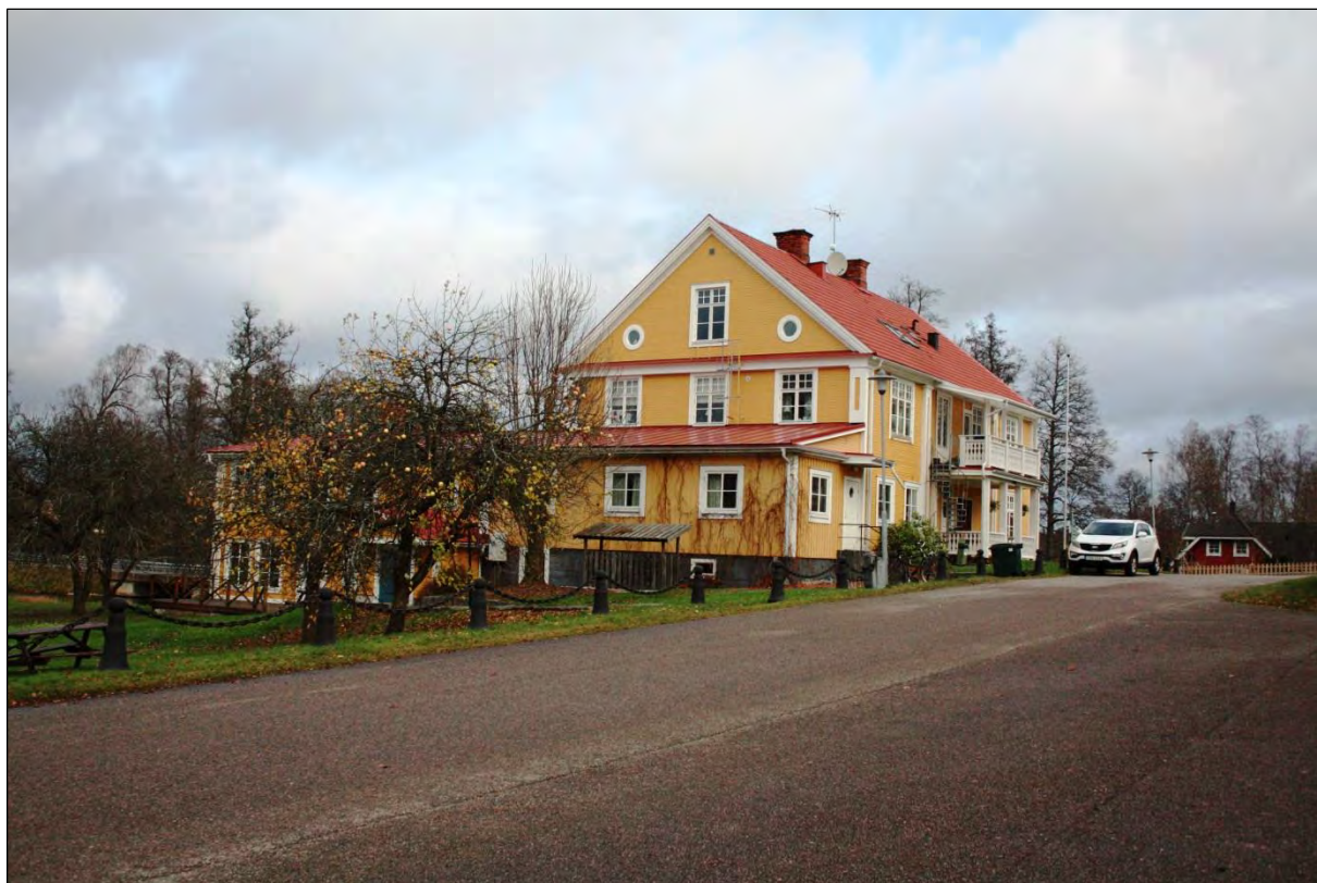
Bild 1. F.d. brukskontoret, nuvarande vandrarhem.
