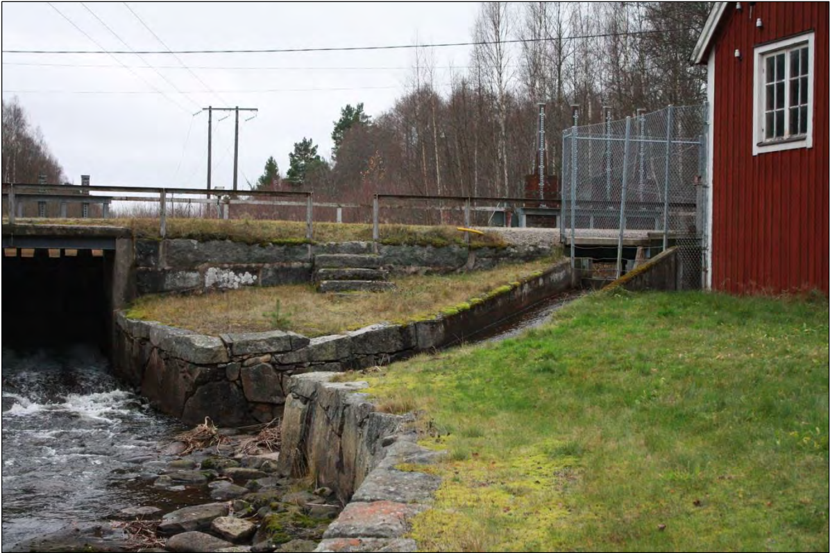
Bild 9. En betonggjuten ränna för att leda bort vatten.
