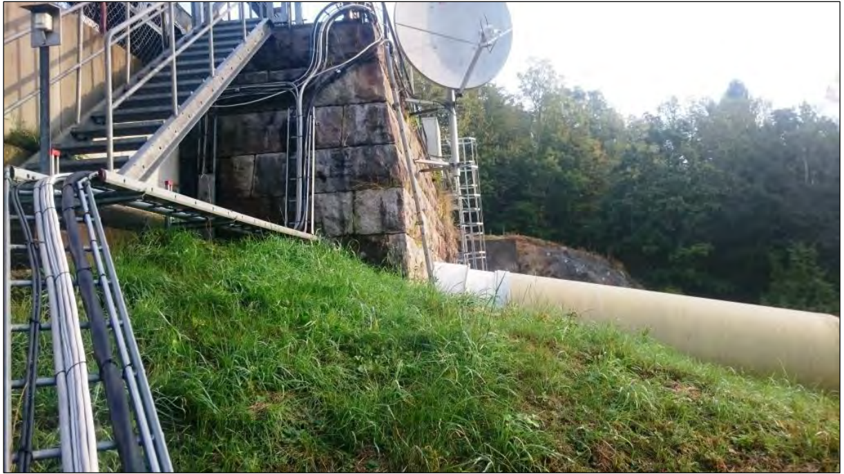
Bild 3. Här syns skalmursdammen delvis uppbyggd av huggen sten.
