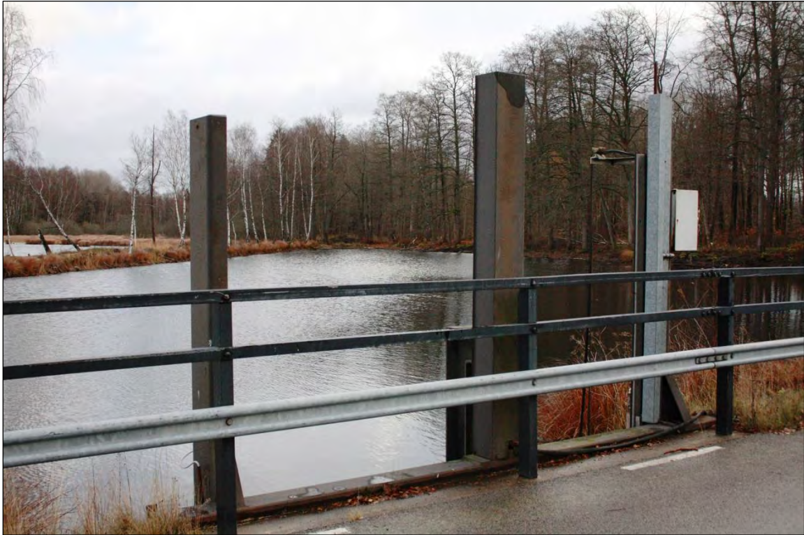
Bild 3. Intagsluckan till kraftstationen.
