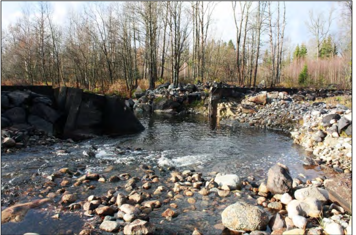
Bild 3. Delar av tidigare fundament i betong finns kvar.
