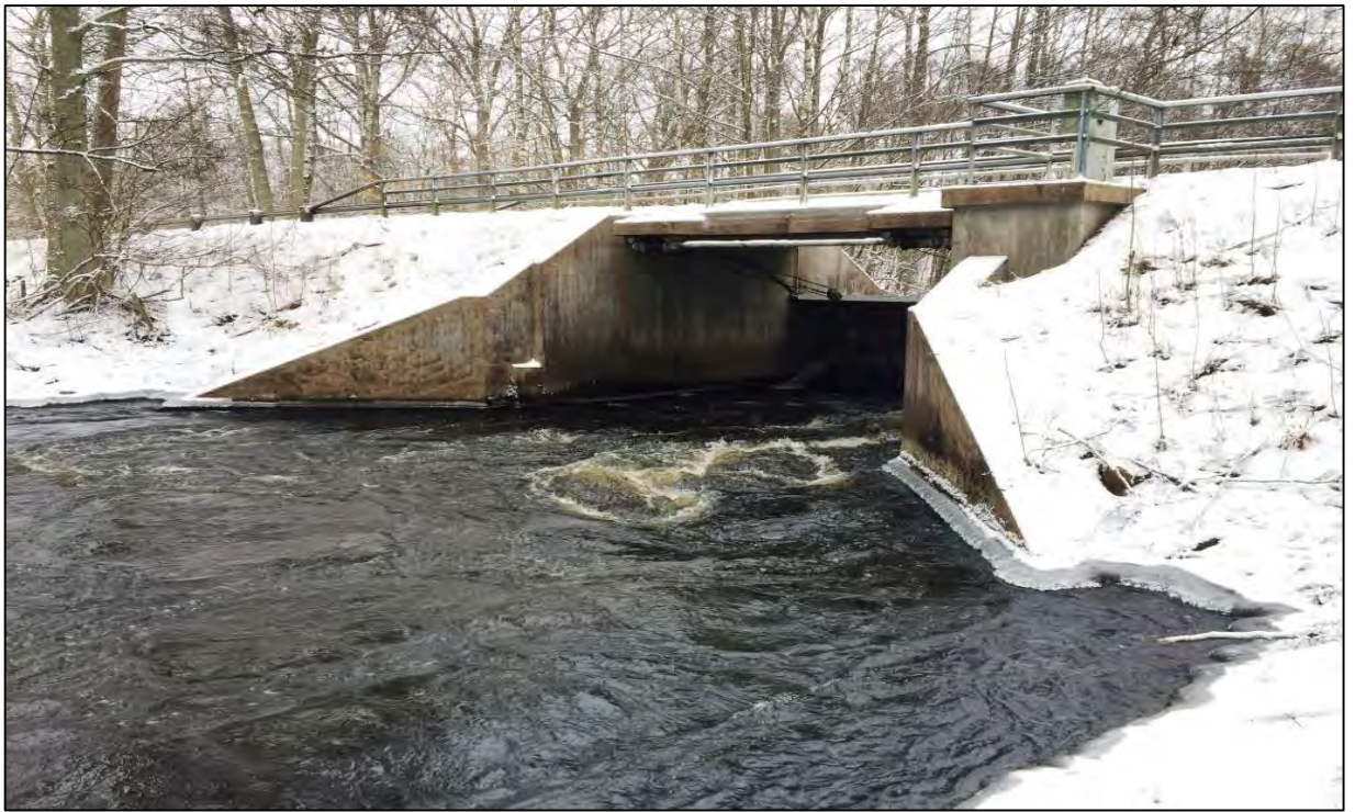
Bild 3. Utloppet efter utskovsluckan mot nordväst.
