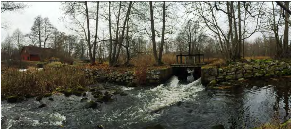
Bild 10. Bakom smedjan finns ytterligare en större damm och en stenvall med ett flertal utskovsluckor.
