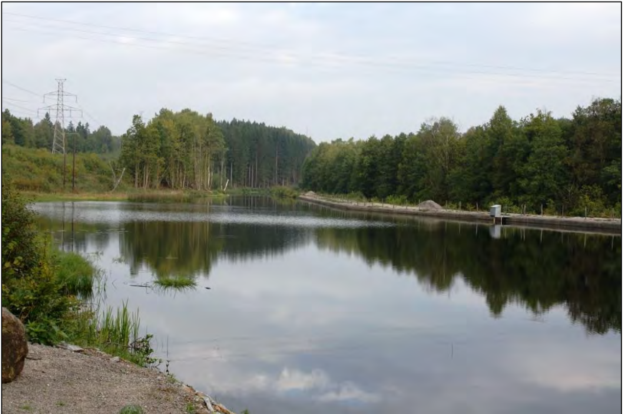
Bild 8. Intagskanalen med betongskodda kanter.
