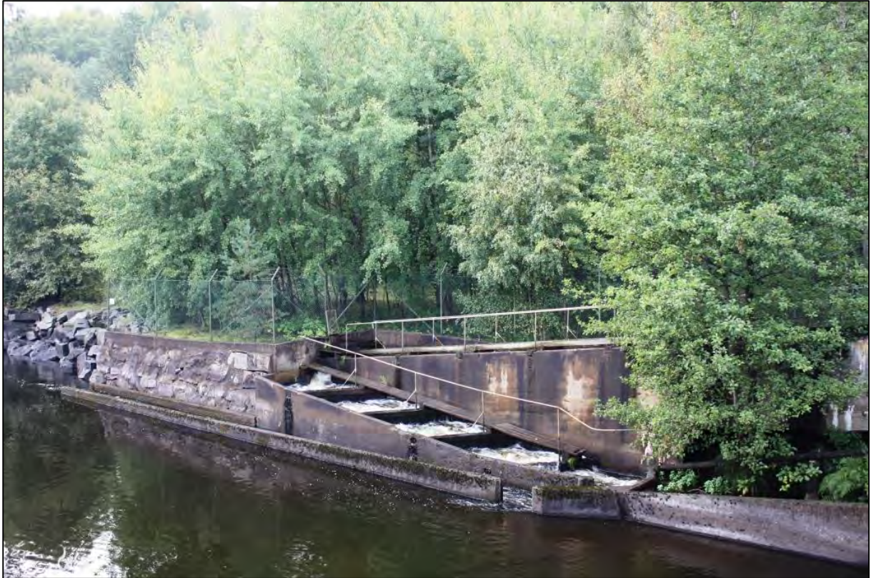
Bild 7. Kammartrappan vid Mariebergs kraftverk.
