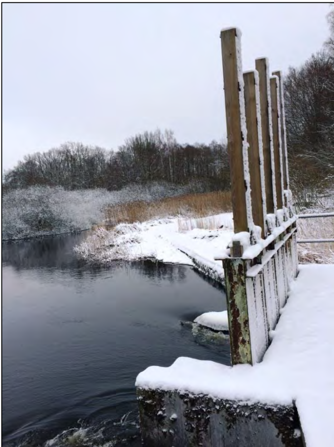
Bild 7 & 8. Utskovet med fem spettluckor som reglerar dammen.
