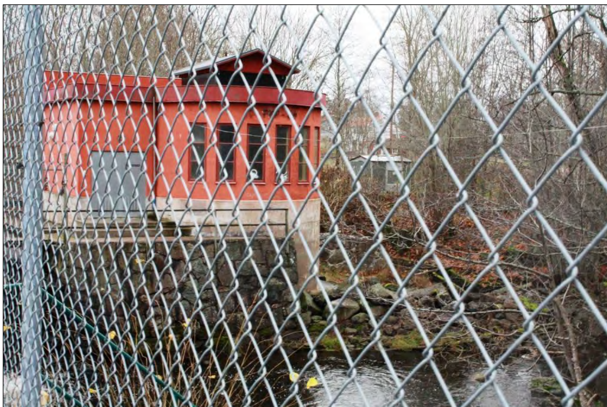
Bild 1&2. Kraftstationen vid Räfte, uppförd 1936.
