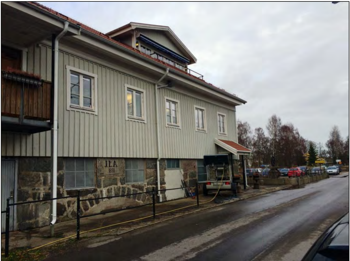
Bild 11. Kontorsbyggnaden sedd från östlig riktning.
