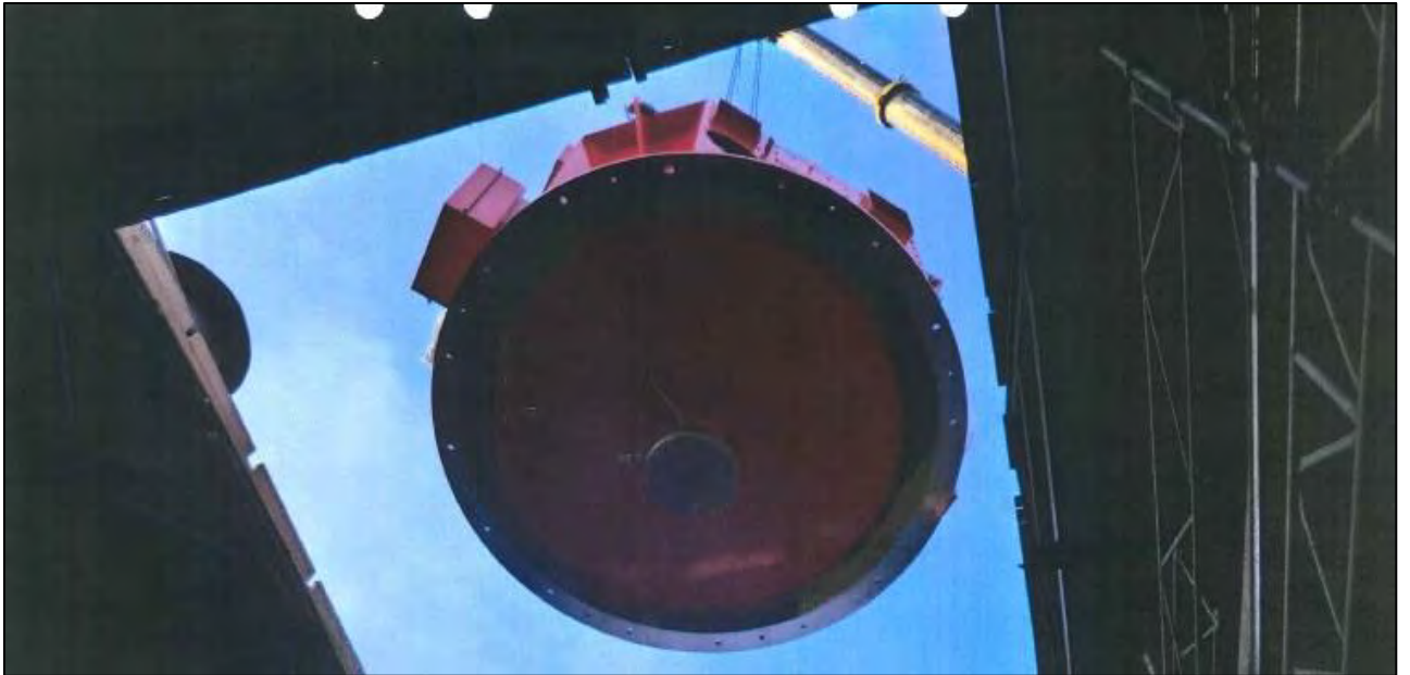
Bild 7. Ett hål togs tillfälligt upp i taket. Bilden tillhör Frank Gunnarsson.
