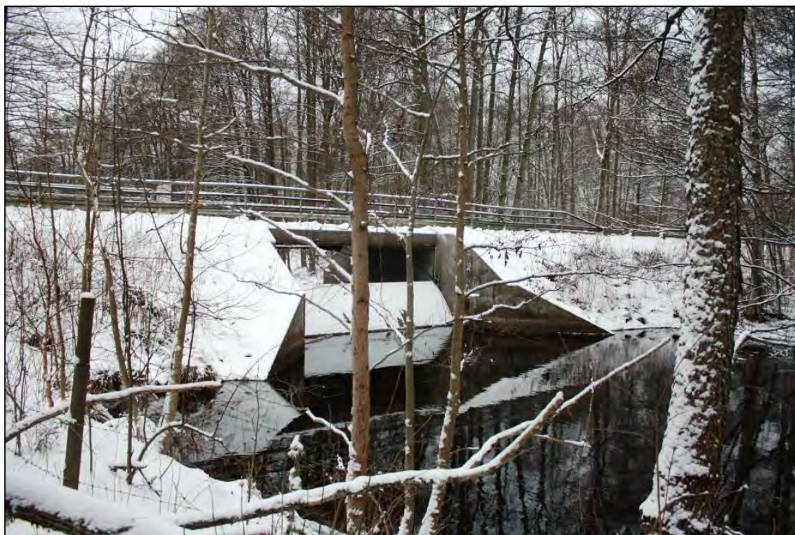
Bild 1 & 2. Vägbron över Mörrumsån. Centralt i åfåran finns en segmentlucka under bron, här mot sydväst.
