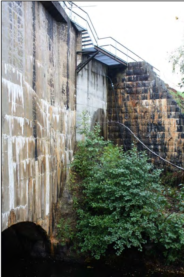
Bild 9. Utloppskanalen som leder ner under sumpen och ut i fåran.
