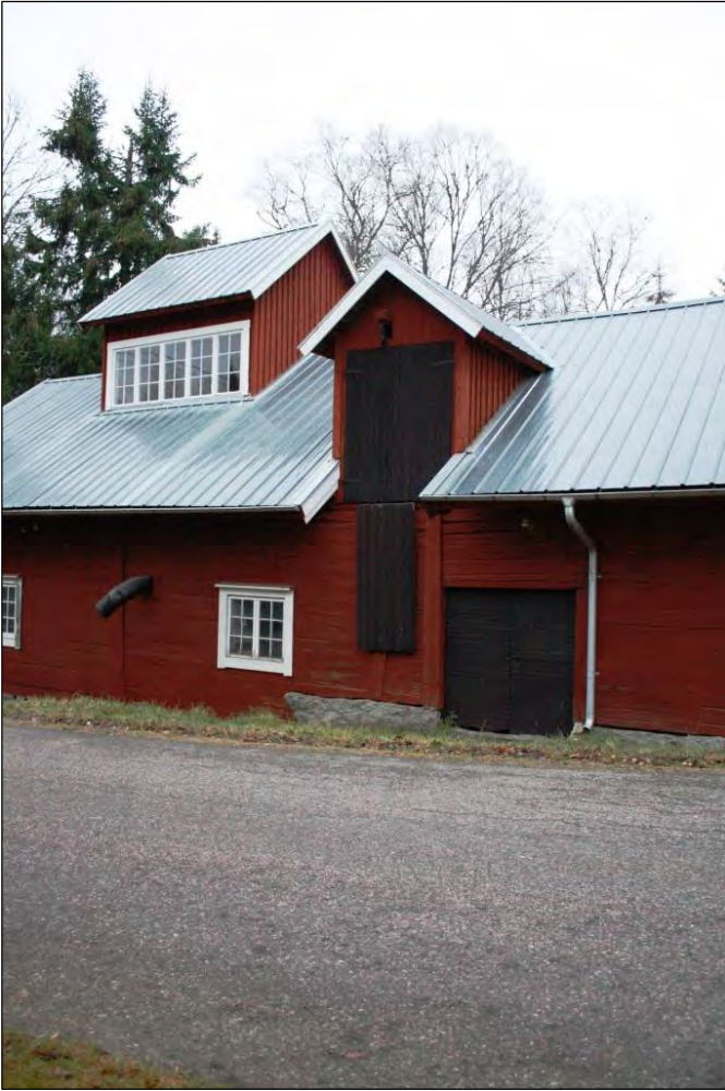
Bild 3. Den uppbyggda takkupan.
