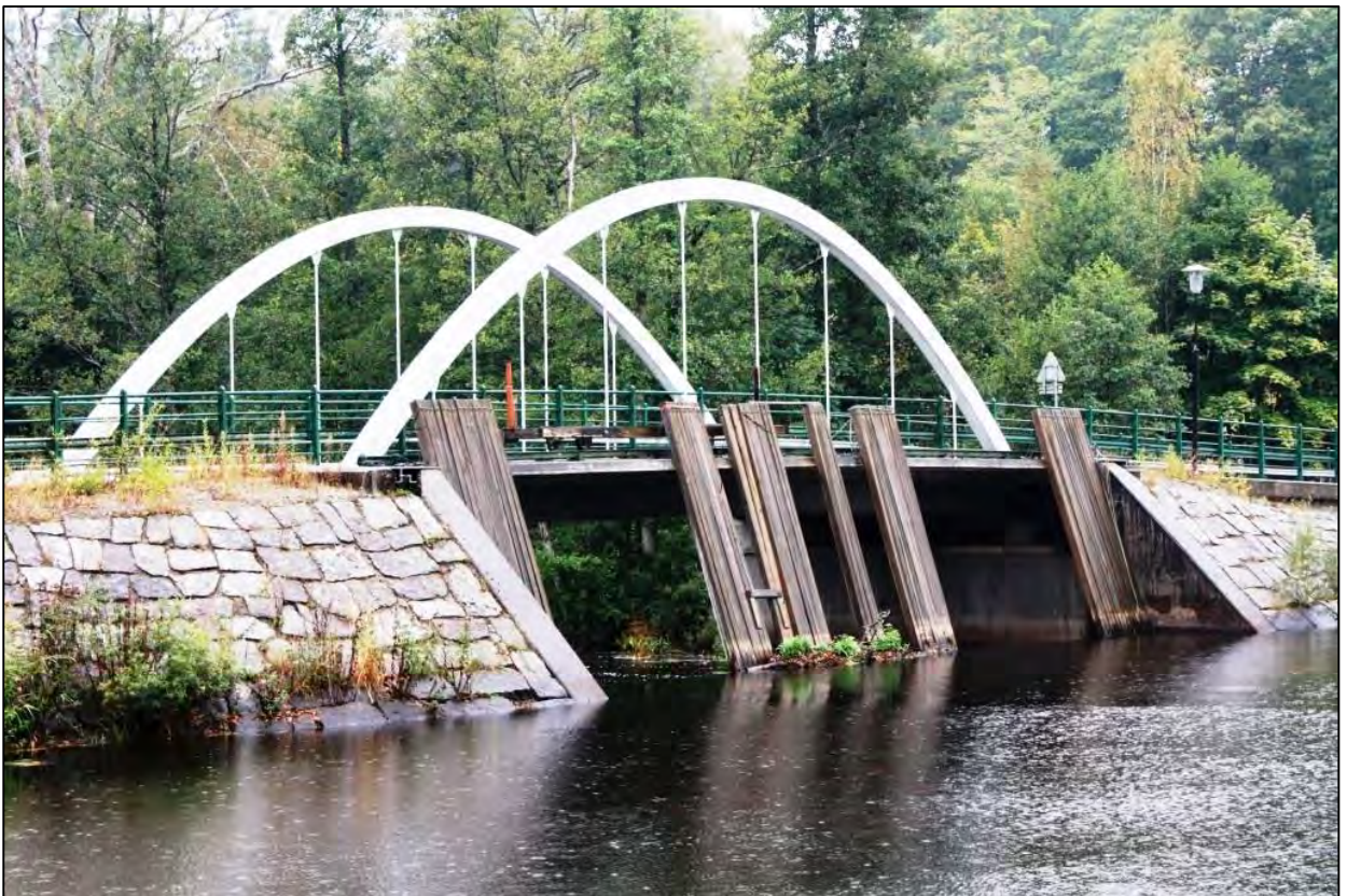
Bild 16. Dambyggnaden vid Ebbamåla och Hovmansbygd är en s.k. nåldamm vars träbjälkar står öppna och släpper igenom vattnet.
