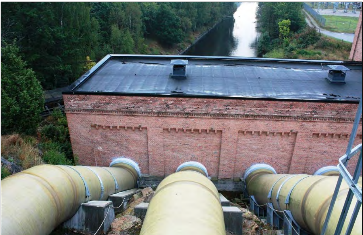
Bild 8. Vid kraftstationen finns fyra intagstuber vilka förser turbinerna med vatten.
