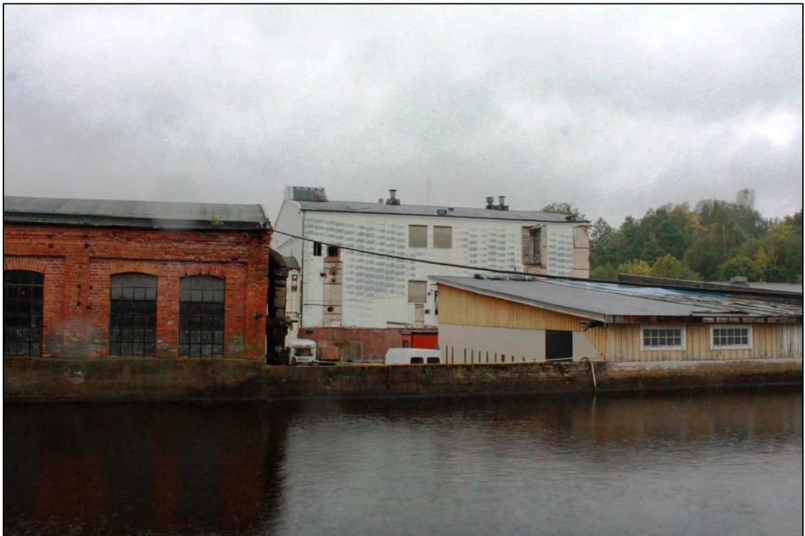
Bild 3 & 4. Ytterligare fabriksbyggnader som angränsar till den äldre fabriksdelen.
