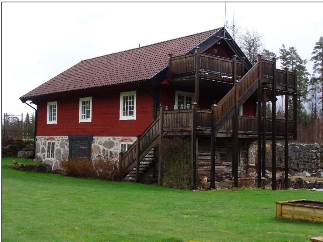
Bild 4. En tillbyggd trappa på byggnadens norra gavel.
