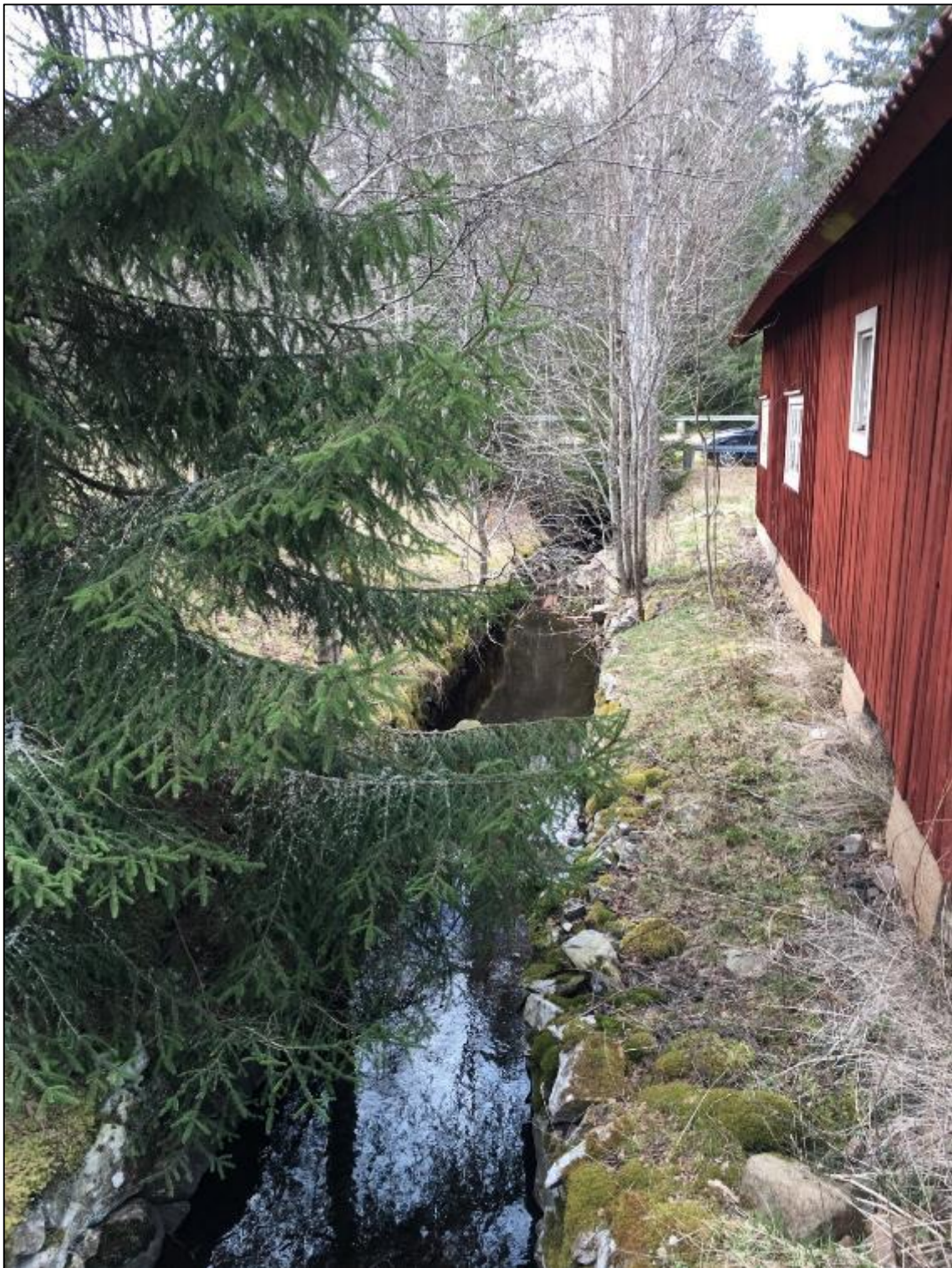
Bild 11. Utloppskanalen med stenskodda kanter.
