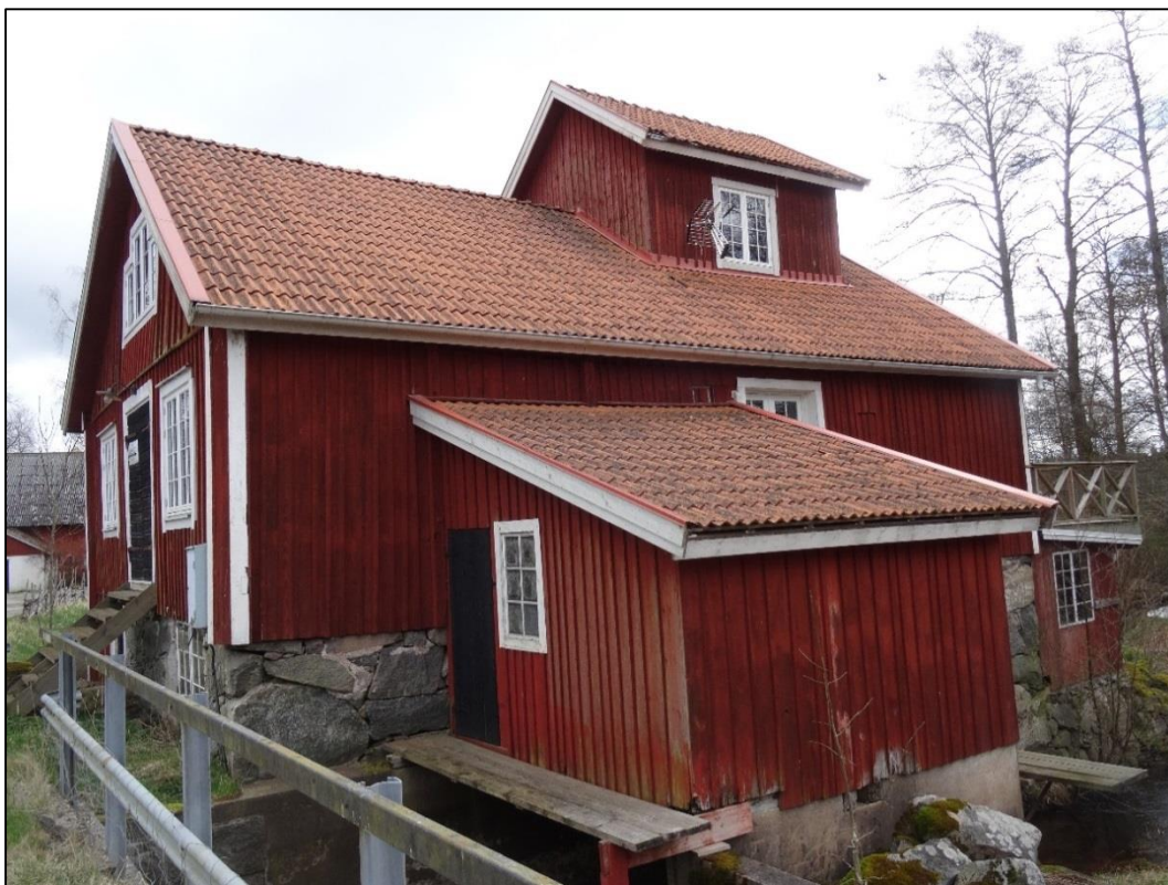
Bild 1. Det före detta kvarnhuset uppbyggt i två och ett halvt våningsplan med ytterligare en uppbyggd del på det övre takfallet för plansikt.
