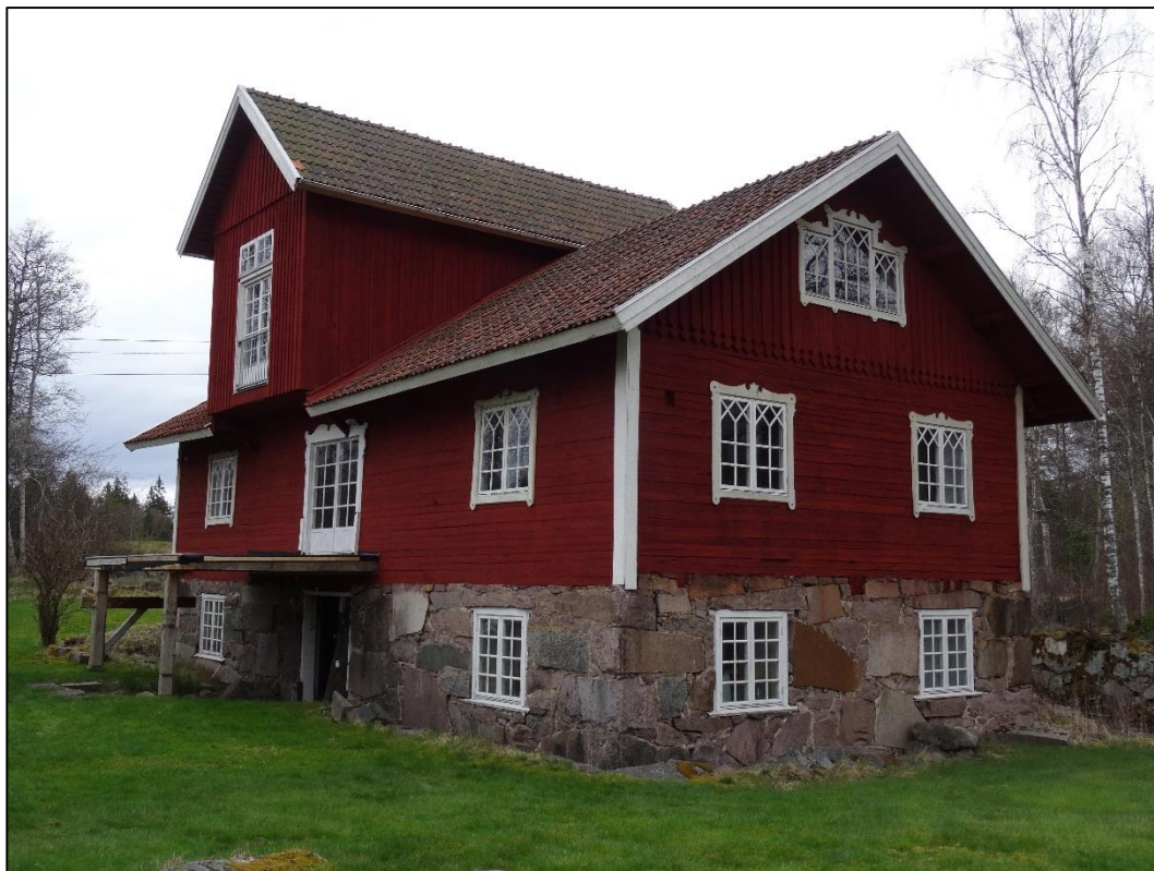
Bild 1. Kvarnhuset sedd ifrån nordväst.
