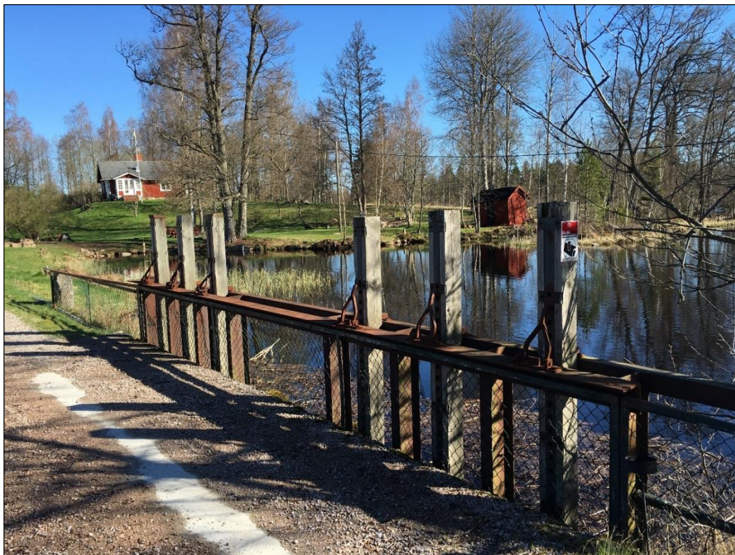
Bild 5. Utskovet som är uppdelat i två med tre luckor vid var intag.
