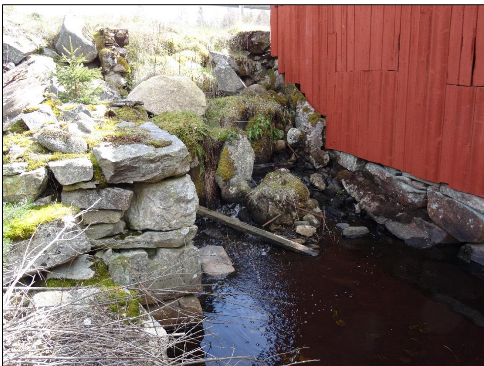
Bild 2. En intagskanal har tidigare lett förbi sågbyggnaden, men är numera igenfylld.
