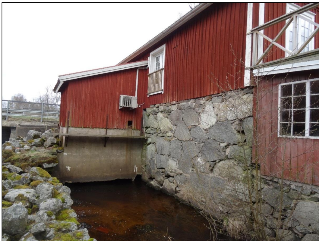
Bild 3. Det före detta kvarnhuset uppbyggt i två och ett halvt våningsplan med ytterligare en uppbyggd del på det övre takfallet för plansikt.
