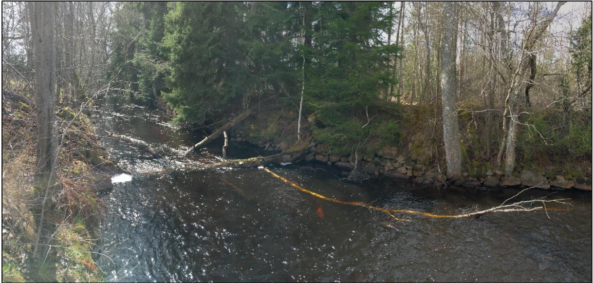
Bild 7. Den östra fåran av två parallella fåror, denna är tydligt rätad och rensad på sten, delar av sidorna är belagd med sten.
