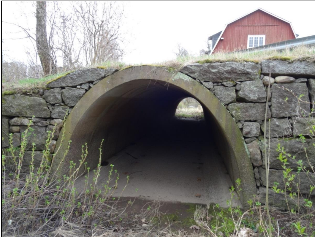
Bild 10. Den äldre stenvalsbron har förstärkts av en sentida betongkonstruktion.
