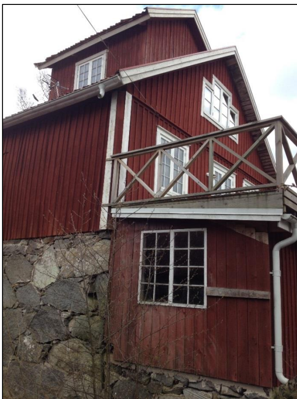
Bild 2. De flesta av fönstren på kvarnhuset är bytta mot en sentida modell med småspröjsade rutor.
