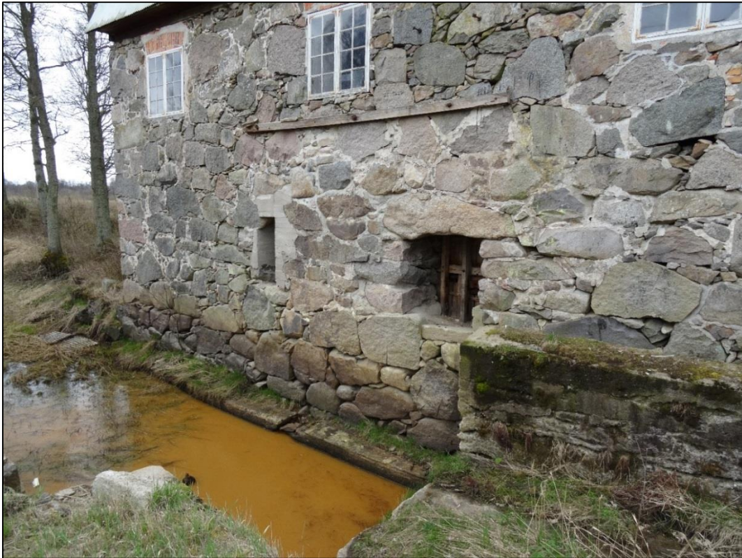
Bild 5. I fasaden syns spår av tidigare vattenhjul och senare turbiner.
