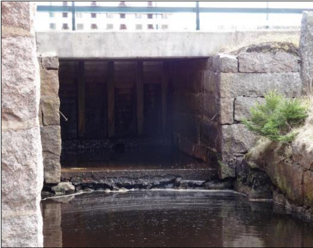
Bild 3. Utskovet till intaget som leder förbi kvarnen regleras med 4 spettluckor.
