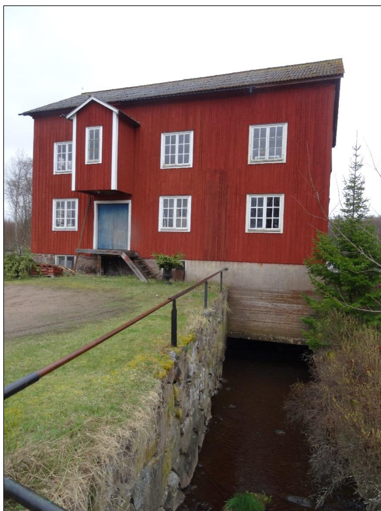
Bild 10. Betongsumpen och utloppskanalen som följer därefter. Det här in-och uttaget ligger mellan det två andra intagen.
