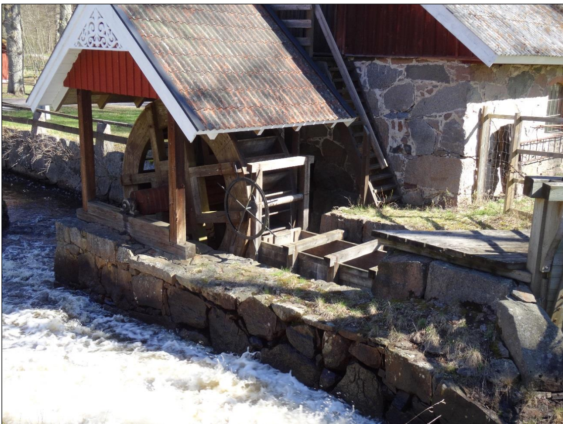
Bild 4. Inloppskanalen avgränsas med ett stenfundament och en träsump som leder vattnet till vattenhjulet.
