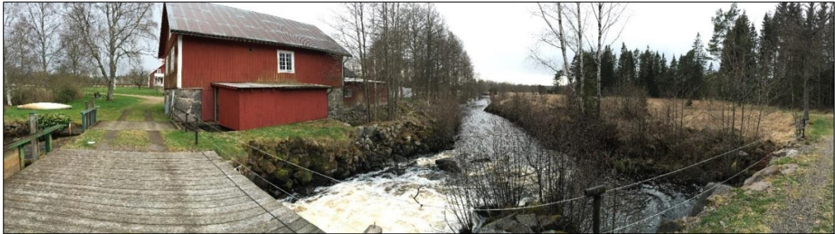
Bild 5. Vy över kvarnhuset och åfåran. Till vänster i bild syns utskoven.
