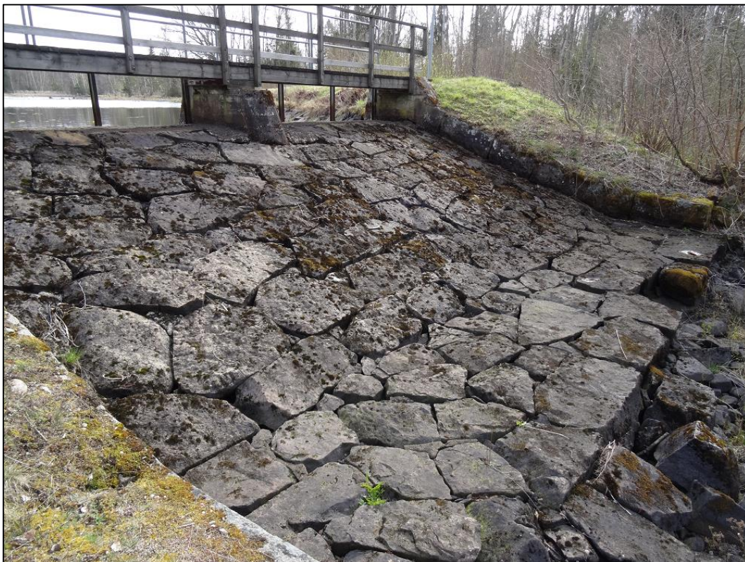
Bild 8. Det stensködda skibordet.
