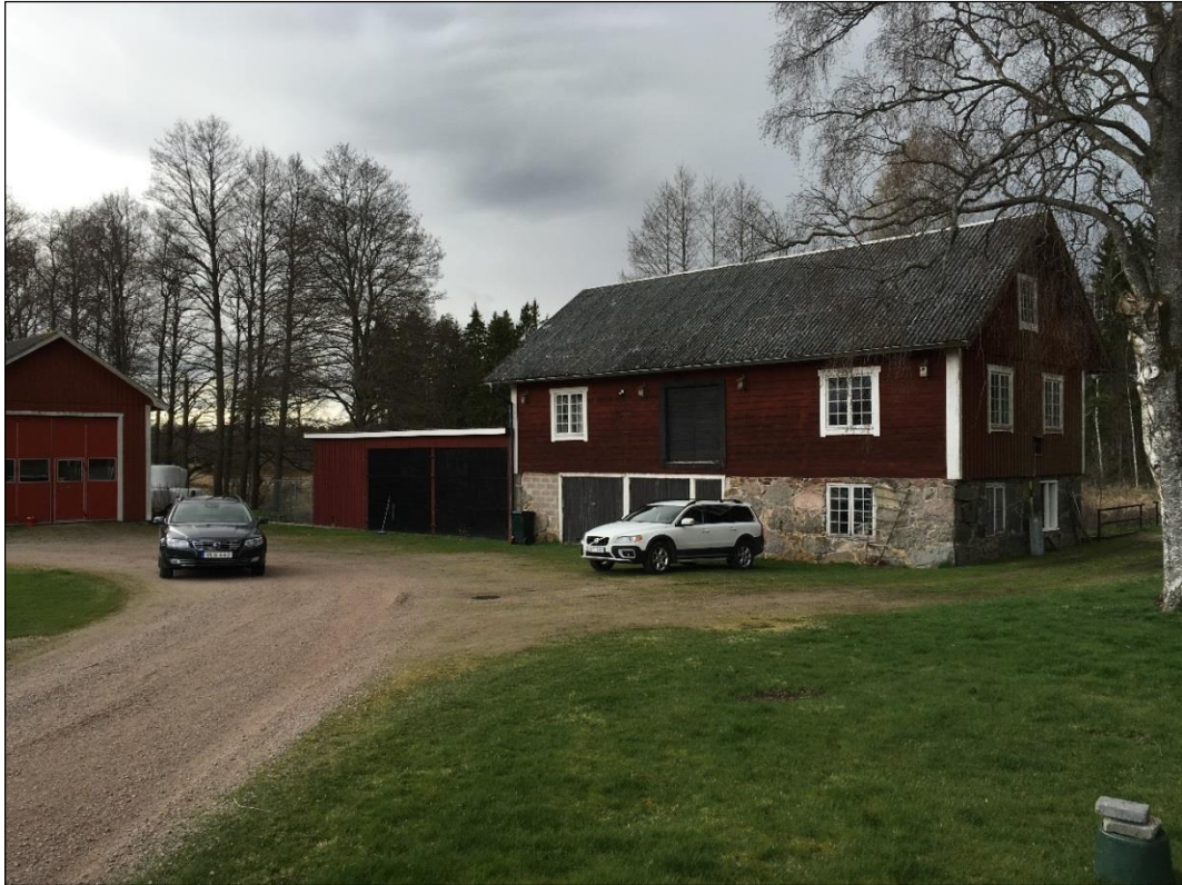
Bild 3. Kvarnhuset sett ifrån sydväst, här syns de upptagna garageportarna i det nedre våningsplanet samt den tillbyggda garagelängan.
