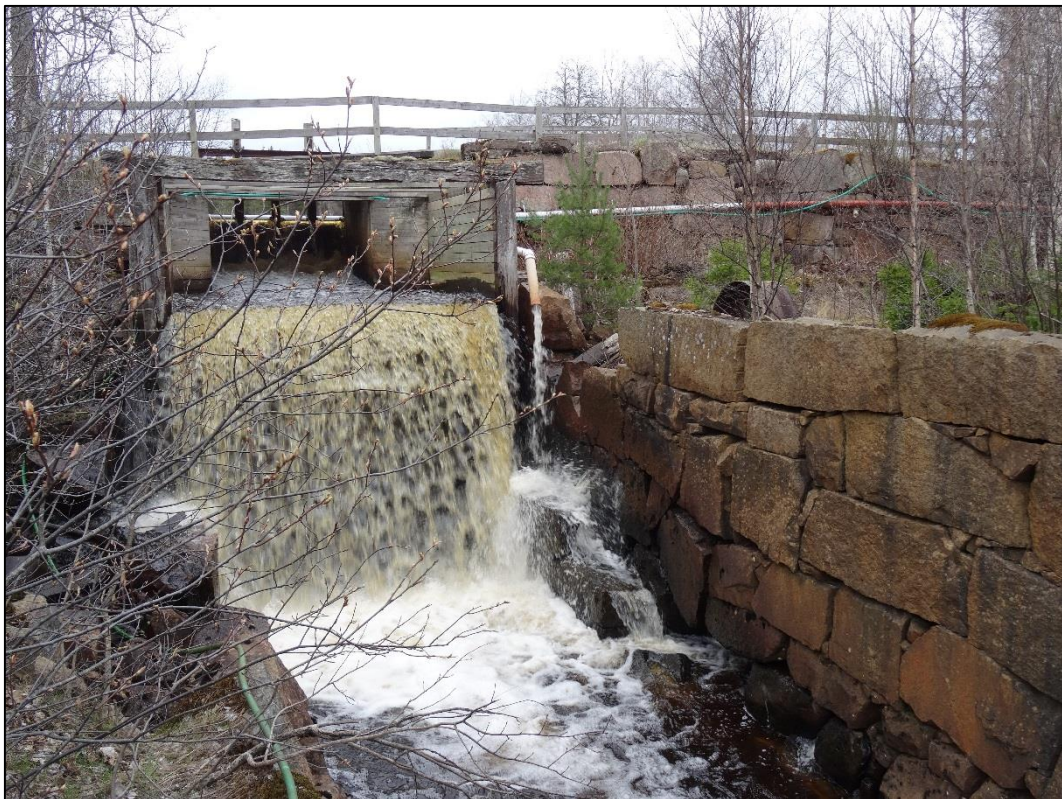
Bild 4. Det västra utskovet med skibord och överfall.
