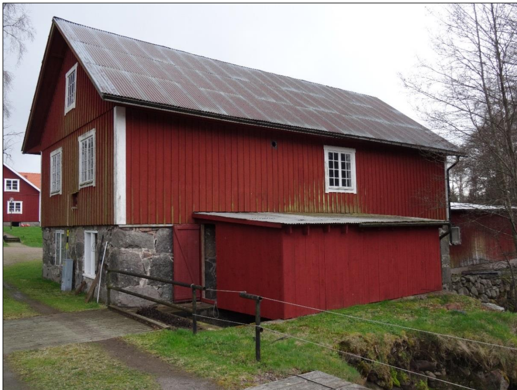
Bild 1. Kvarnhuset sett ifrån öst, med det tillbyggda turbinhuset.
