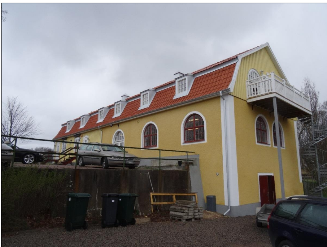
Bild 4. Längs den här långsidan fanns intagskanalen till turbinen, idag är det igenfyllt och används som parkeringsplats.
