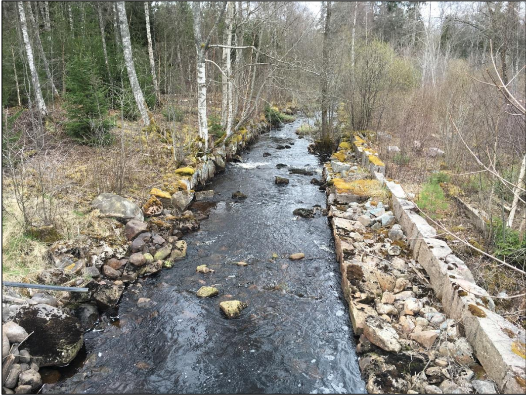
Bild 7. Den östra utloppskanalen med stenskodda kanter.
