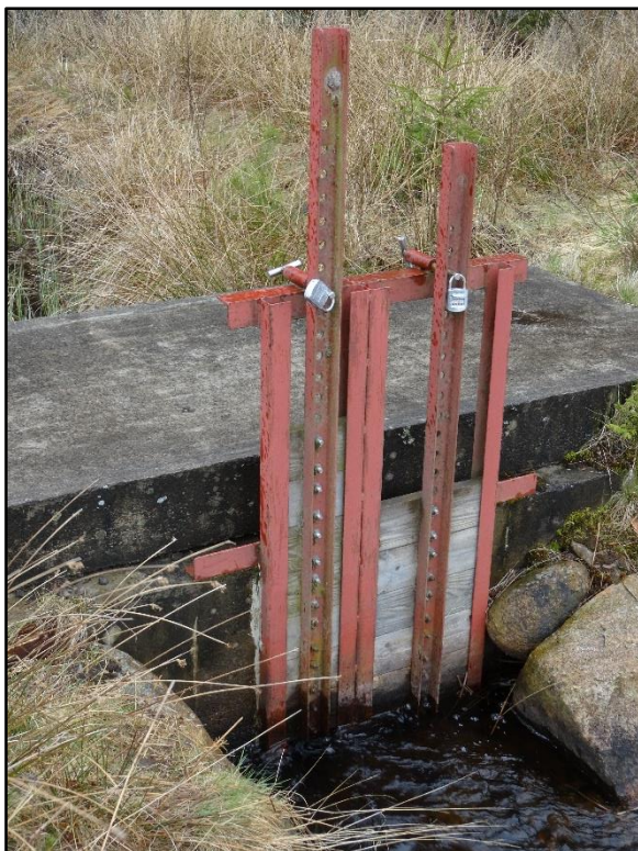
Bild 2. Detaljbild över spetluckan.
