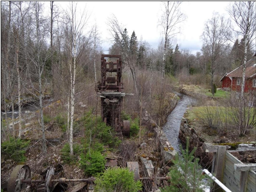
Bild 8. Efter sågen kvarstår husgrunden och maskindelar av den tidigare maskinparken.
