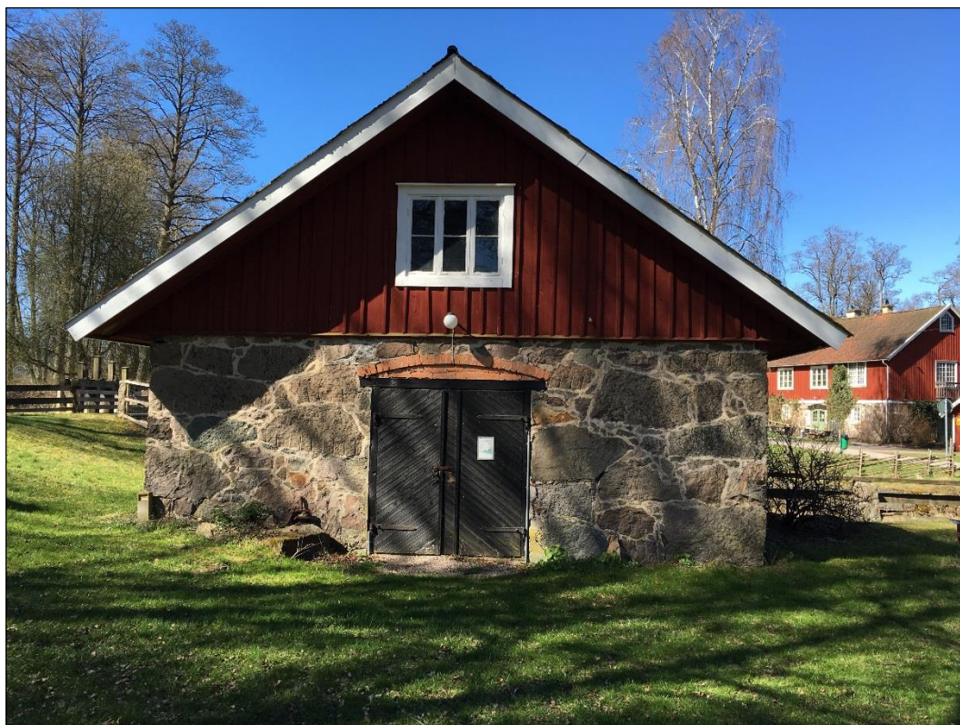
Bild 2. Blåsmaskinhuset sett ifrån entrésidan.
