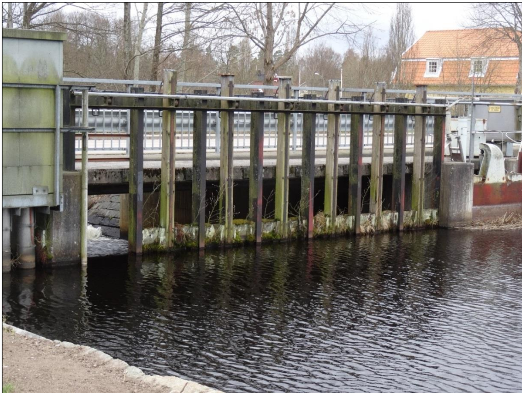
Bild 5. Automatiserade spettluckor reglerar dammen.
