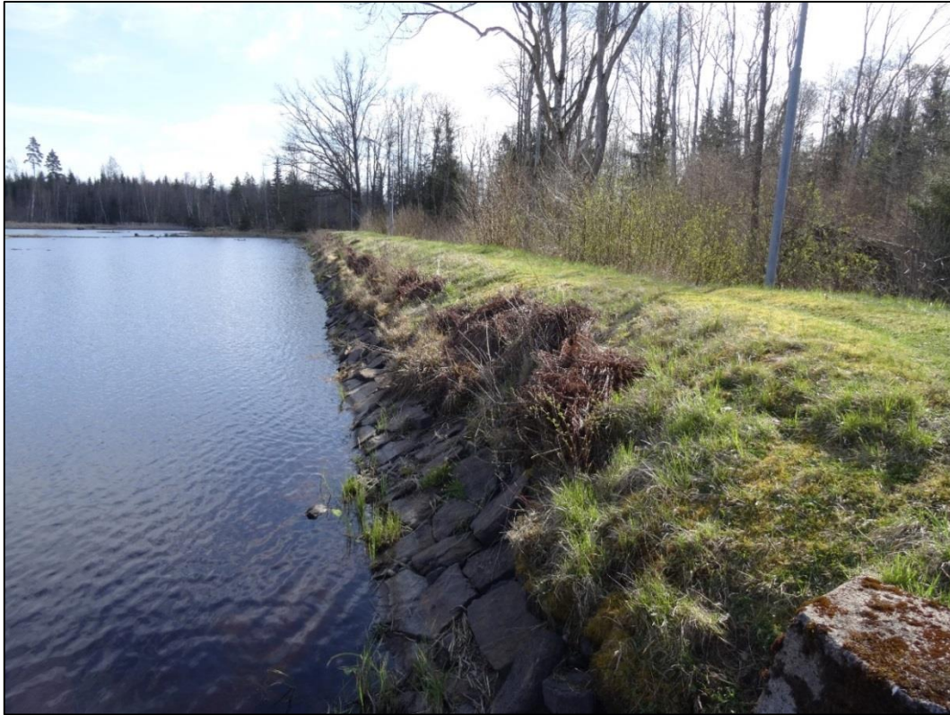
Bild 7. Dammvallen med stensködd kant.
