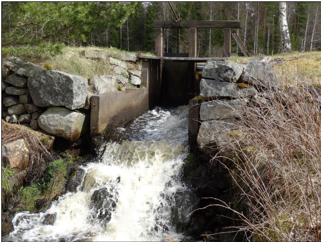
Bild 6. Utskovet som reglerar dammen, endast en spettlucka kvarstår.
