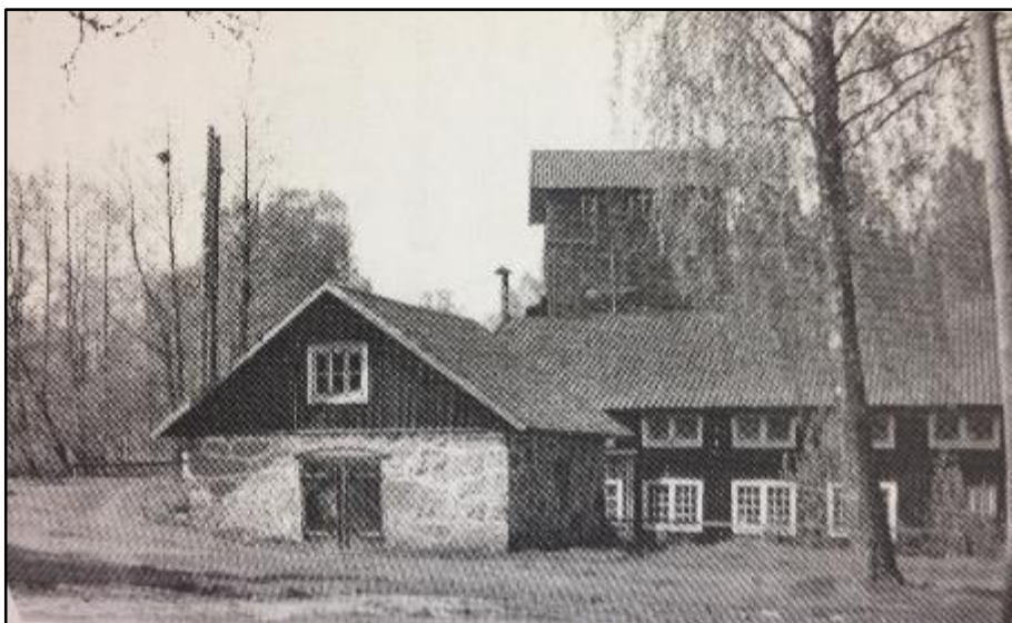
Historisk bild 2. I förgrunden är det blåsmaskinhus som syns på bild 2. I bakgrunden skymtar masugnen7 (Skogen, vårt levebröd i hundra år. 2001).
