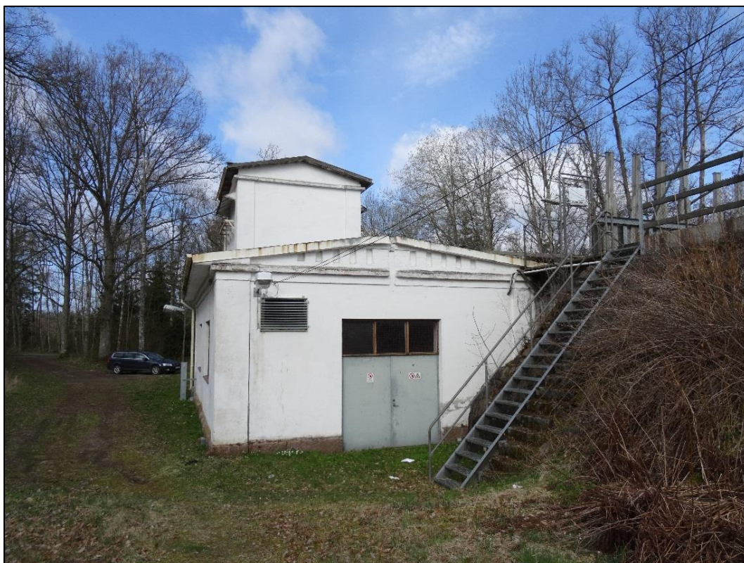
Bild 2. Kraftstationen sedd ifrån östlig riktning.
