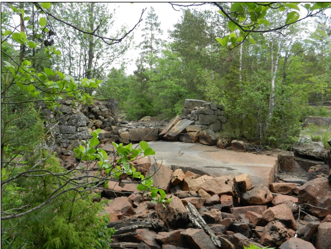
Bild 8. Ett av två utskov som har lett vatten förbi den tidigare kvarnbyggnaden, här med ett skibord av sten.
