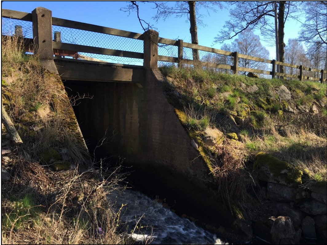
Bild 5. Fördämningsvallen som även fungerar som körväg.
