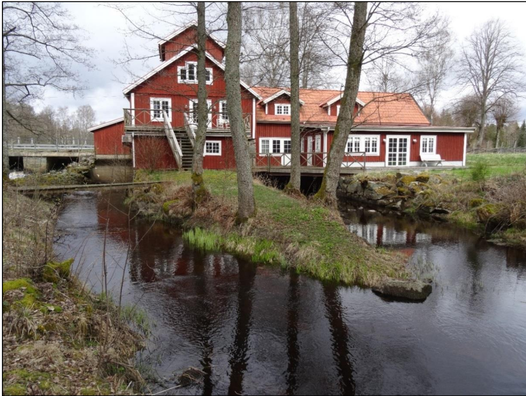
Bild 8. De båda utloppskanalerna flyter samman och förbinder en bit nedströms med åfåran.
