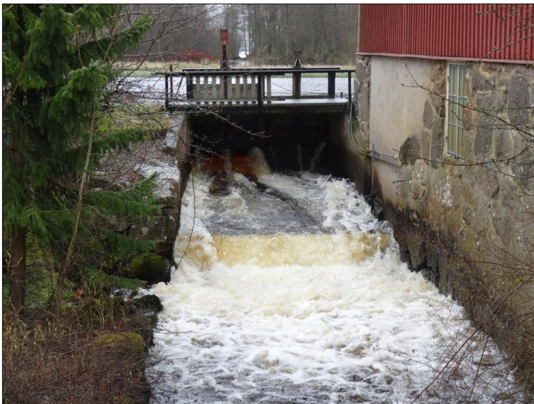
Bild 3. I sockeln syns spår efter tidigare vattenhjul/turbin.
