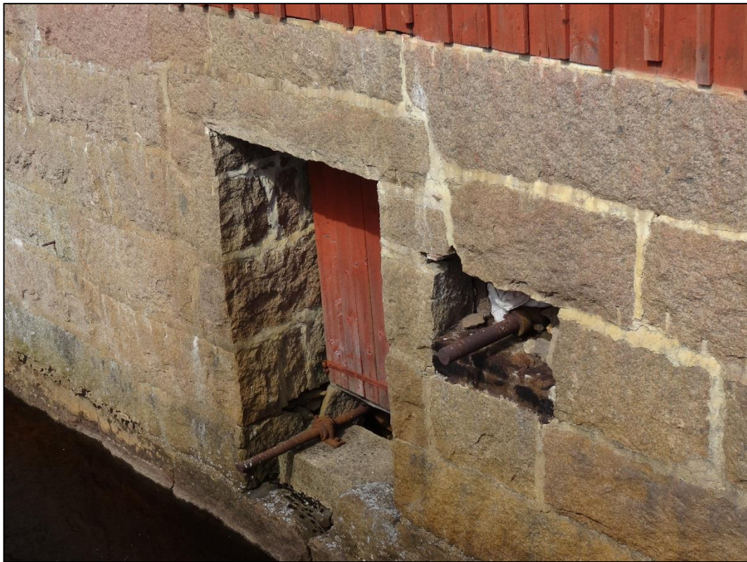
Bild 7. I sockeln syns spår efter den tidigare turbinen.
