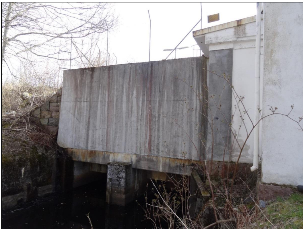
Bild 5. Turbinsumpen som är byggd ovan åfåran.
