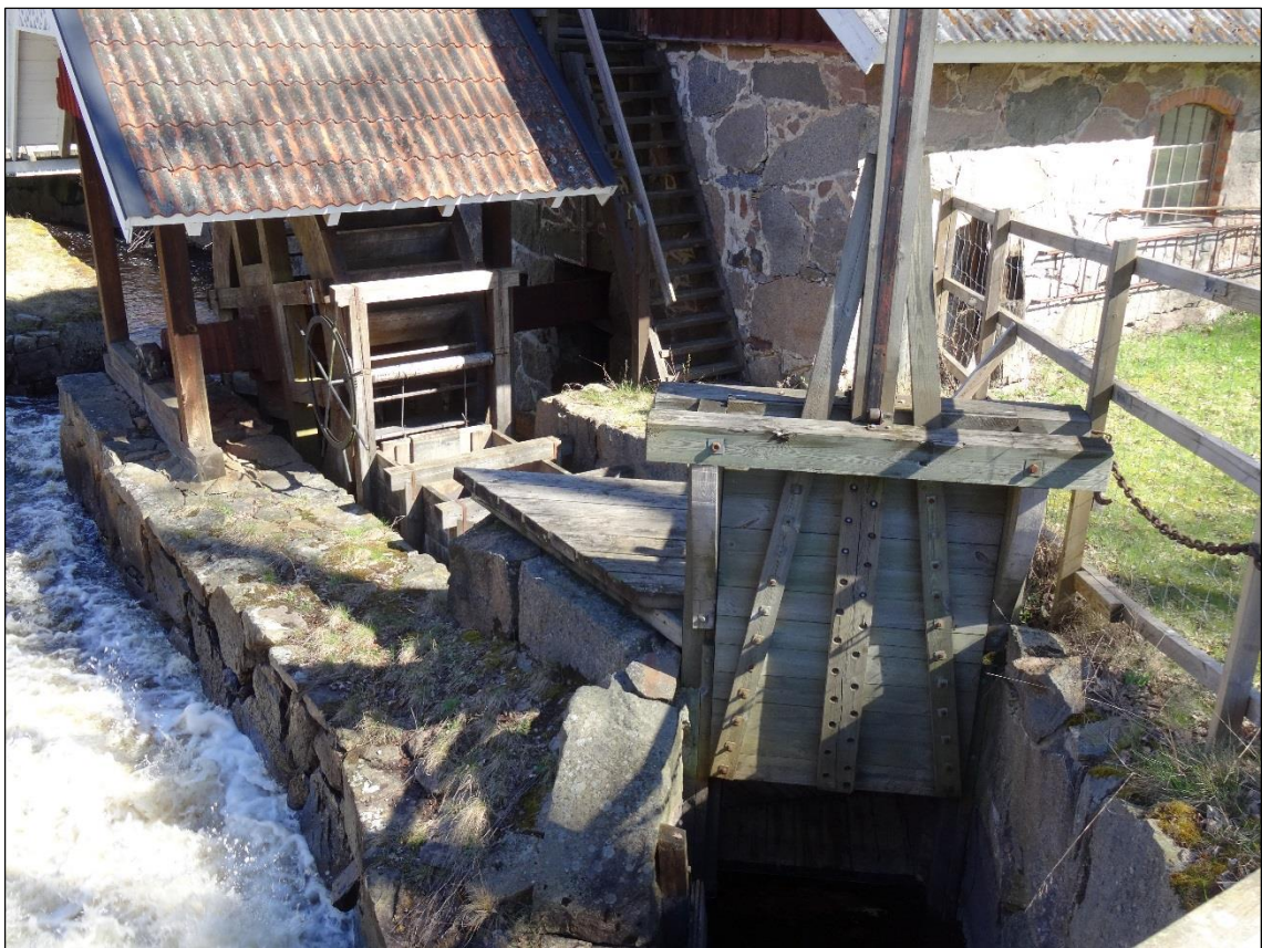
Bild 6. Utskovsluckan som reglerar intaget till vattenhjulet.
