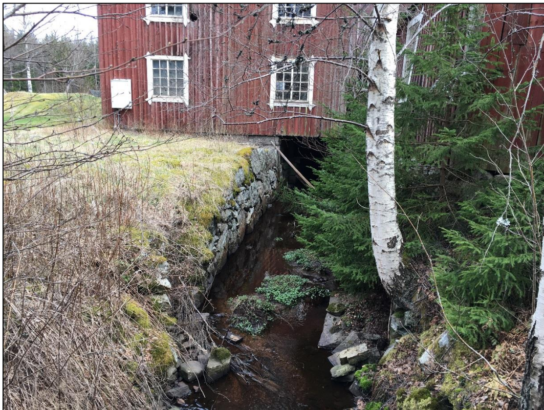
Bild 9. Utloppskanalen som kommer fram under huset.
