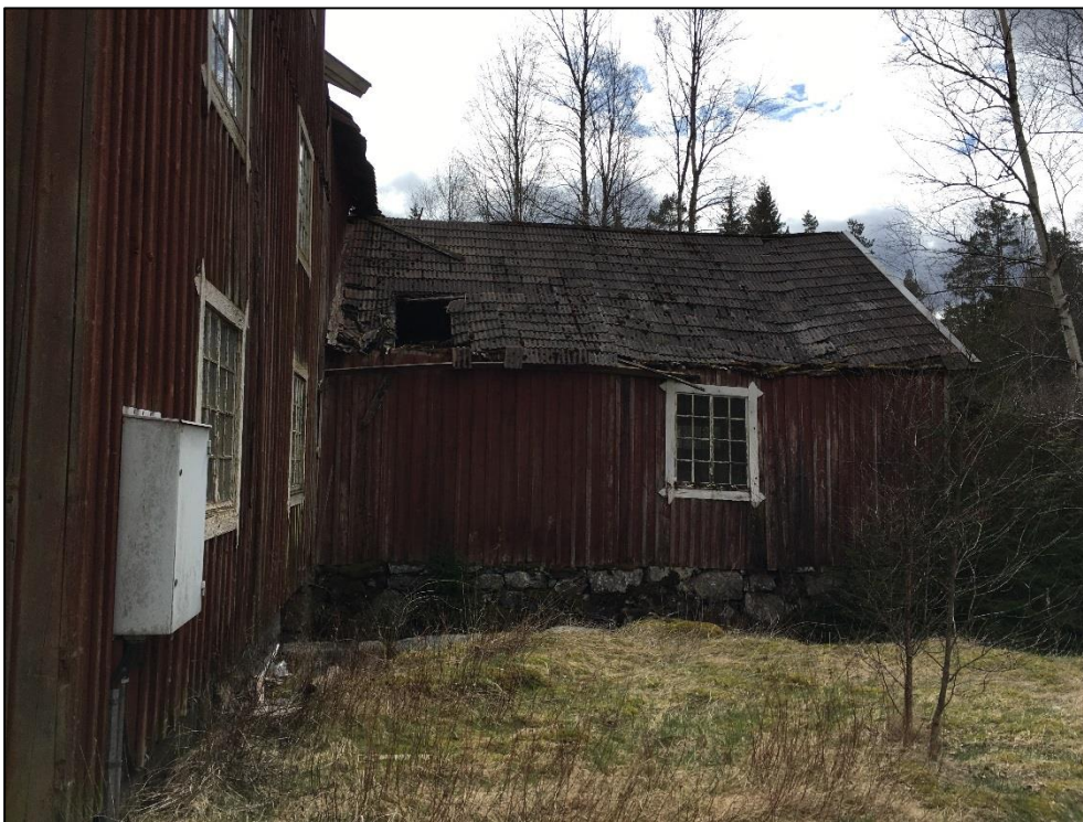
Bild 2. Delen för sågen är utbyggd och vinkelställd mot kvarnhuset.
