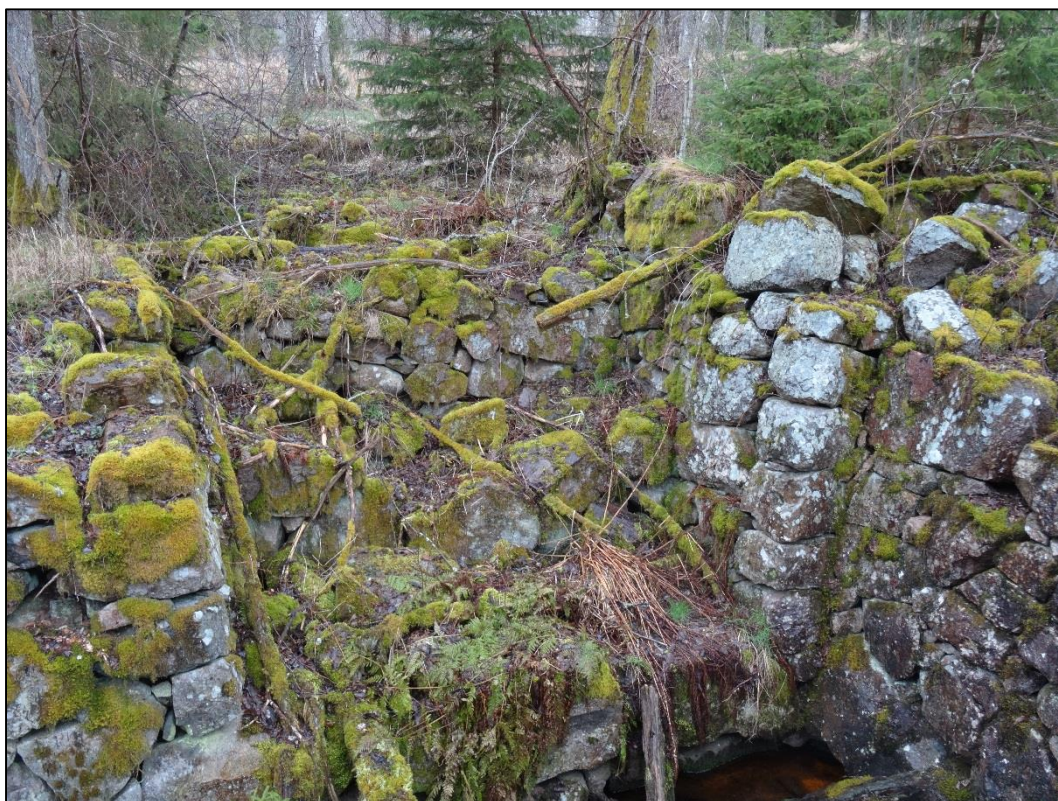
Bild 2. En del av grunden till kvarnbyggnaden.
