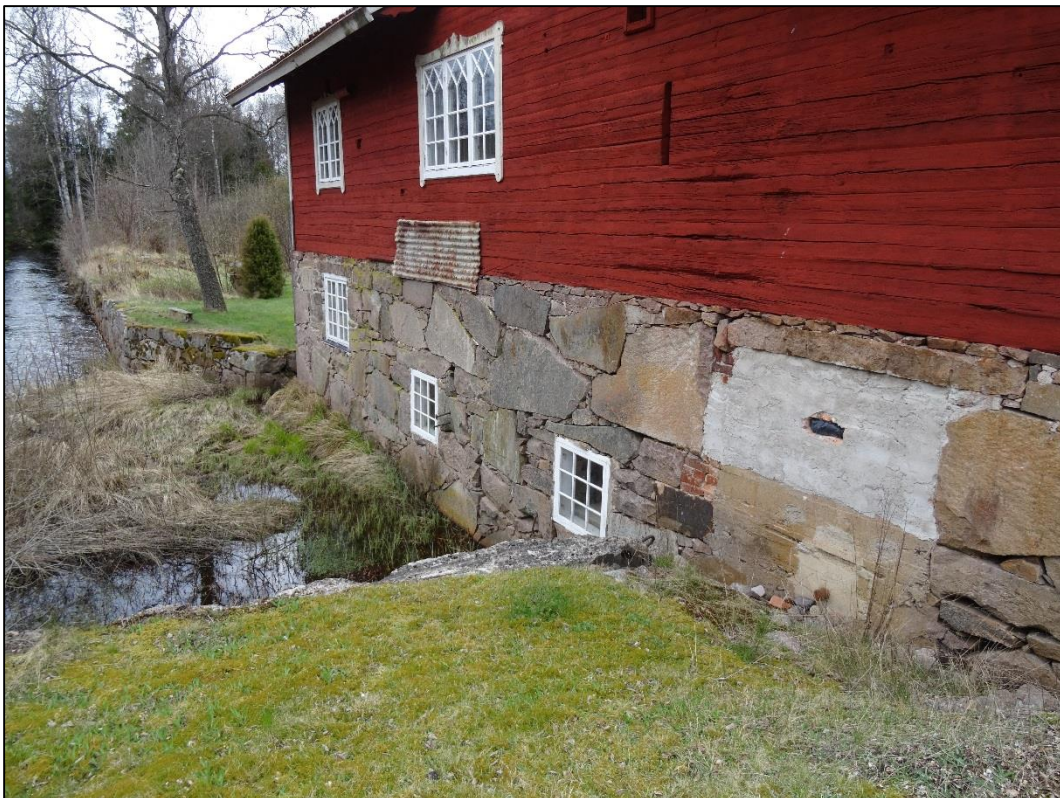
Bild 10. I sockeln finns spår av en tidigare öppning för vattenhjul/turbin.
