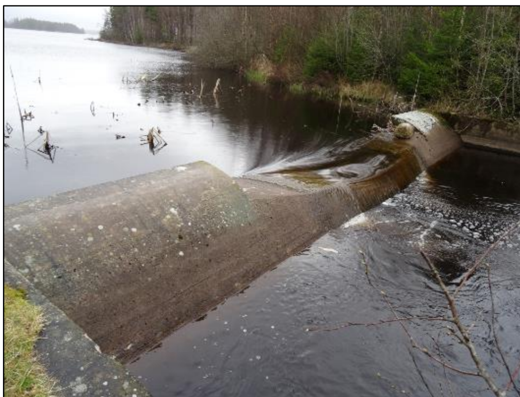
Bild 4. Skibordet i betong som reglerar vattennivån i Linnebjörkesjön.
