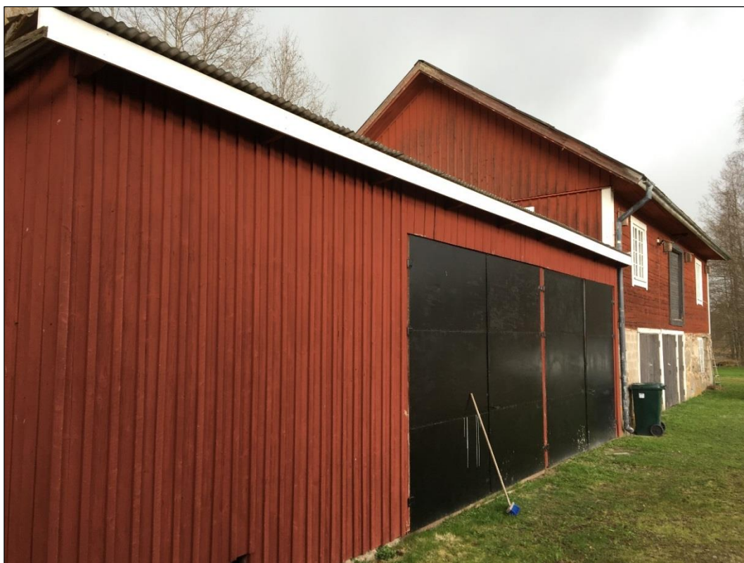
Bild 2. Kvarnhuset sett ifrån nordväst.
