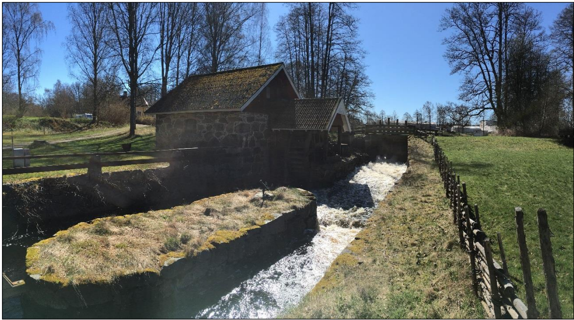
Bild 5. Ytterligare ett stenfundament som delar upp strömfåran i två fåror.
