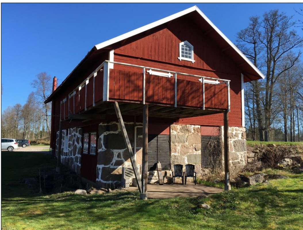
Bild 2. Den tillbyggda balkongen.
