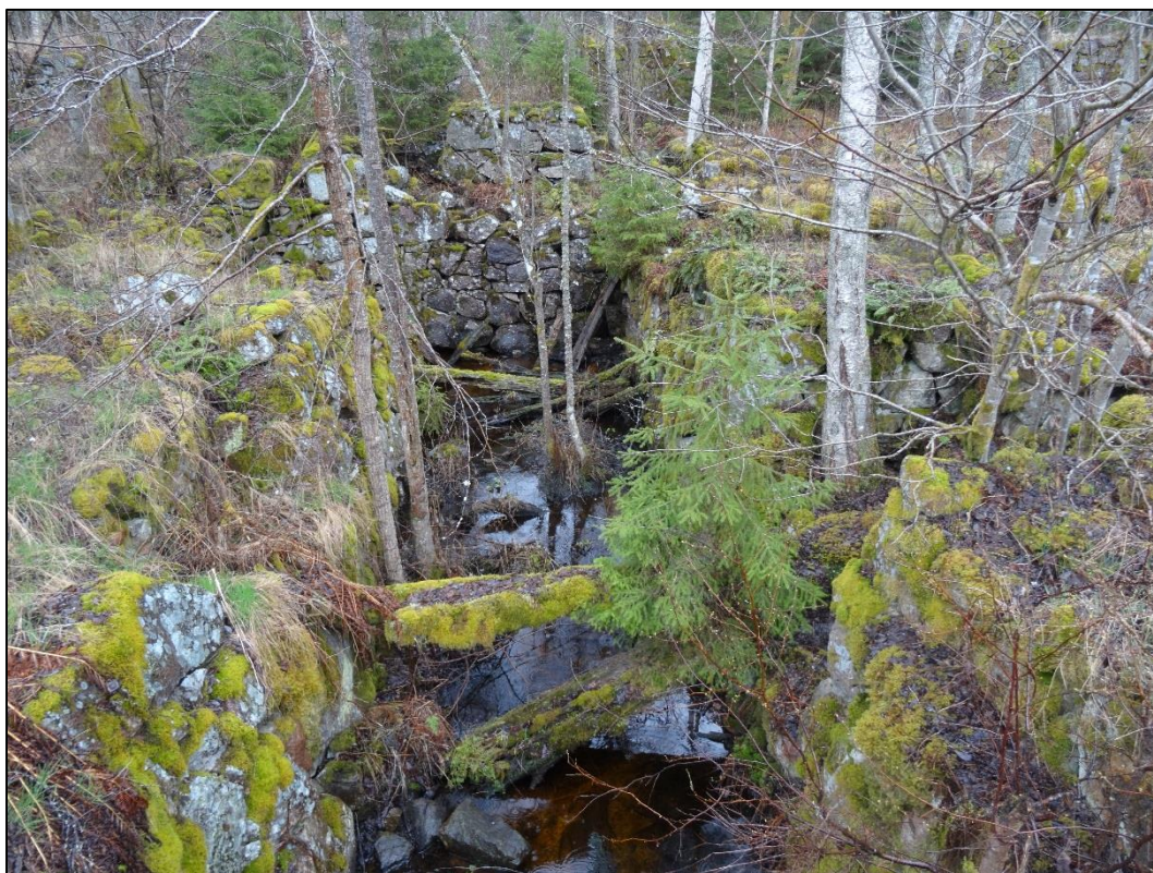
Bild 3. Kvarnkanal med stenskodda kanter.
