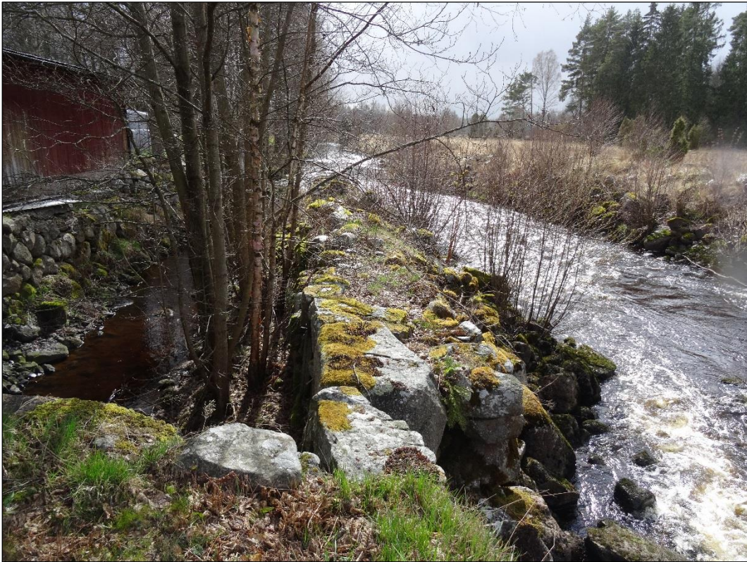
Bild 8. Här syns uppdelningen av åfåran i utloppskanal och en sidofåra eller strömfåra.
