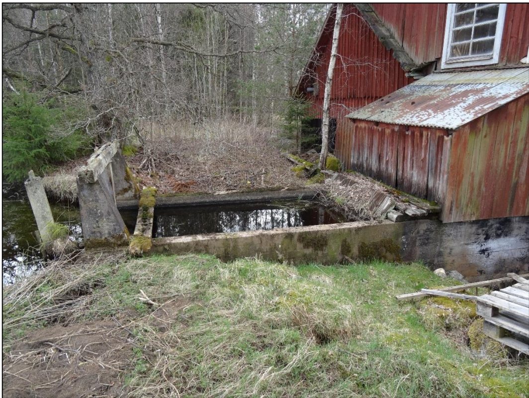
Bild 8. Utskovet som reglerar intaget till betongsumpen och turbinhuset.
