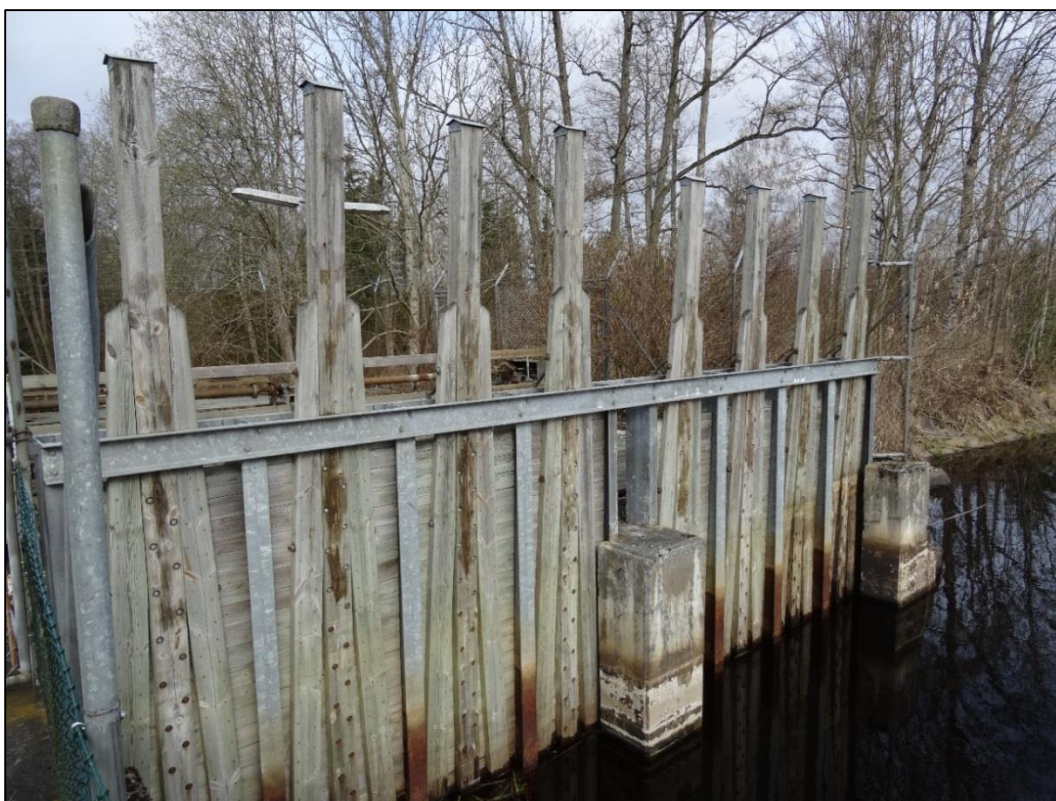
Bild 6. Spettluckor vid intaget till turbinsumpen.
