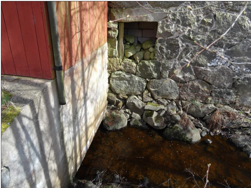
Bild 4. Den igensatta öppningen där det troligen tidigare har suttit en mittstock till ett vattenhjul. Lägg märket till den murade stensockeln liksom den gjutna betongumpen.
