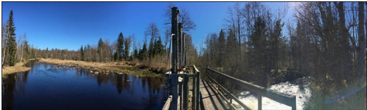
Bild 10. Den andra dammen som regleras av ett utskov med spettluckor.
