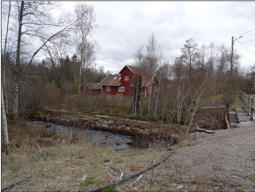
Bild 5. Trärännan som vattnet leds över ett skibord.
