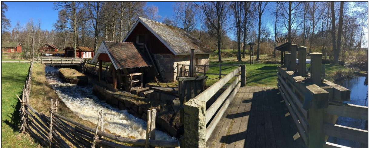
Bild 3. Det rekonstruerade vattenhjulet har skydd av ett mindre tak.
