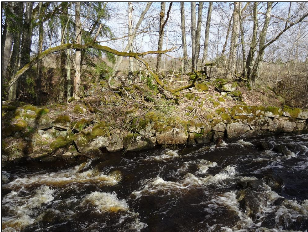
Bild 12. I bakgrunden synd den dammvall som åt väster leder till kraftverksbyggnaden.
