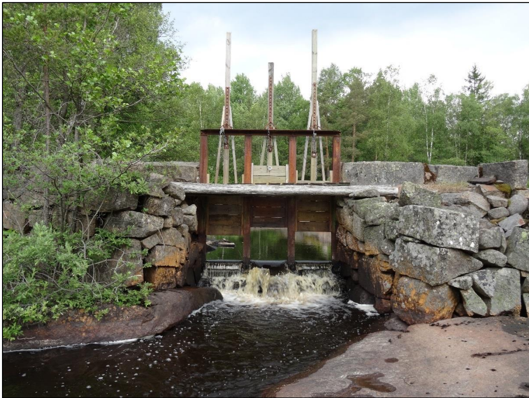
Bild 5. Utskovet med spettluckor för reglering av dammen.
