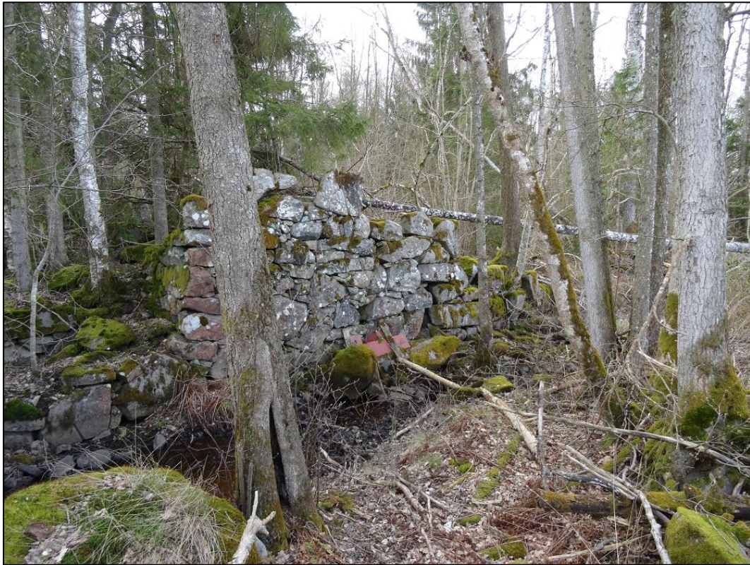
Bild 11. Grunderna 150 meter öster om kraftverksbyggnaden. Bilden visar grunden på den södra sidan av vattendraget. Lägg märke till den torrlagda vattenkanalen omedelbart intill den kallmurade delen.
