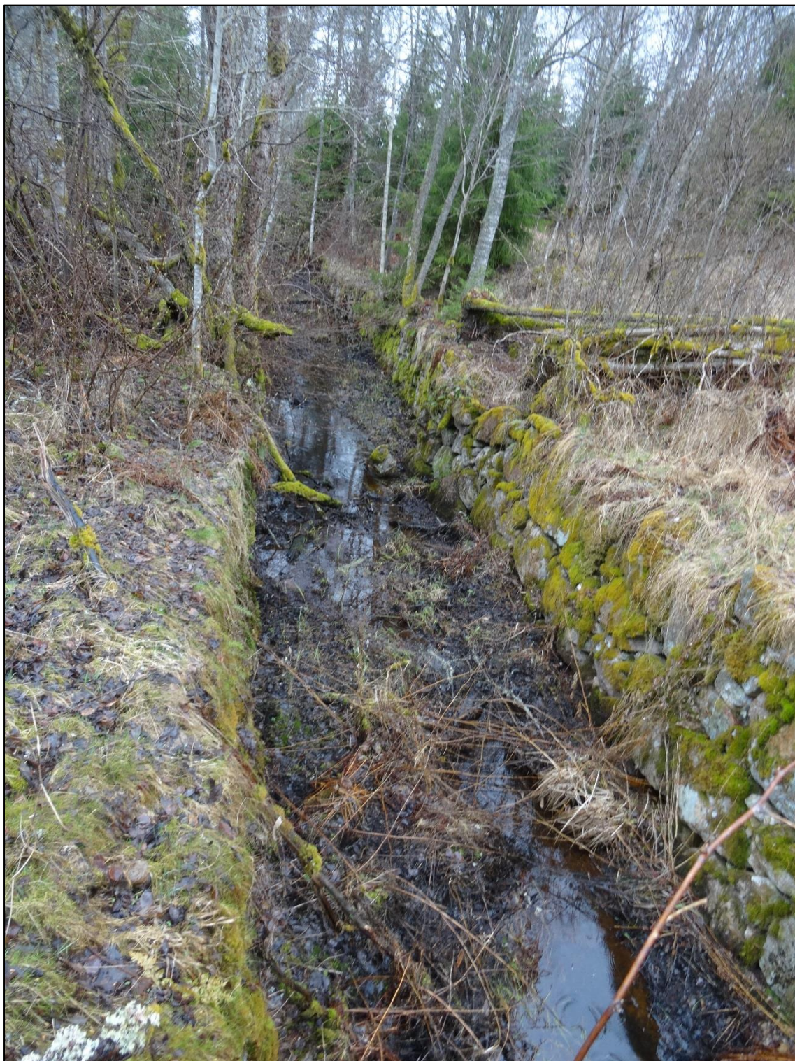
Bild 4. Utloppskanalen som tidigare har lett bort vatten, numera med stillastående vatten börjar den att växa igen.
