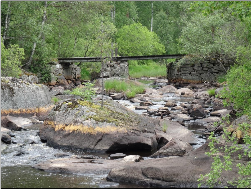
Bild 11. Brofundamenten från den tidigare stenvalsbron finns kvar i åfåran, vägen över fåran fungerar fortfarande som en övergång men med en sentida bro av brädor.
