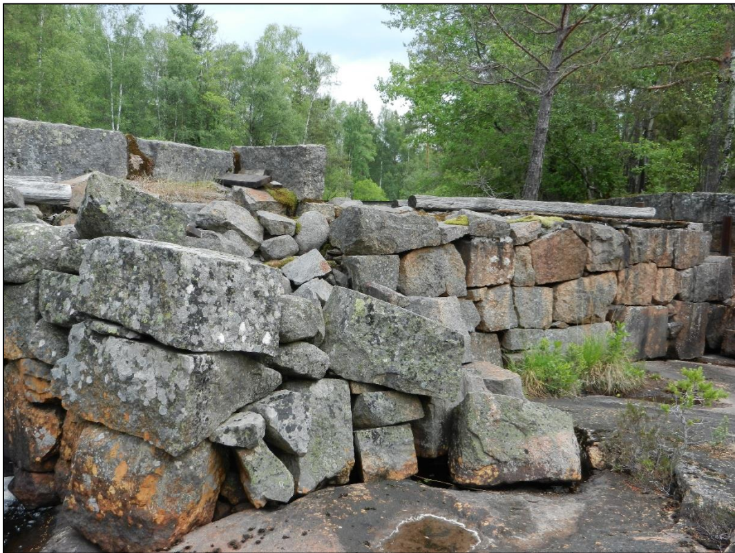
Bild 6. Dammvallen av huggna stenblock.
