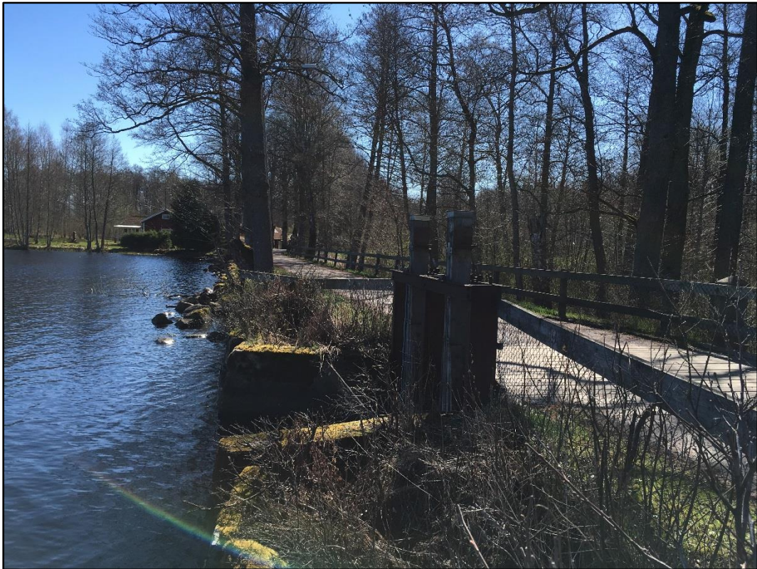
Bild 3. Utskovet som regleras med två spettluckor.
