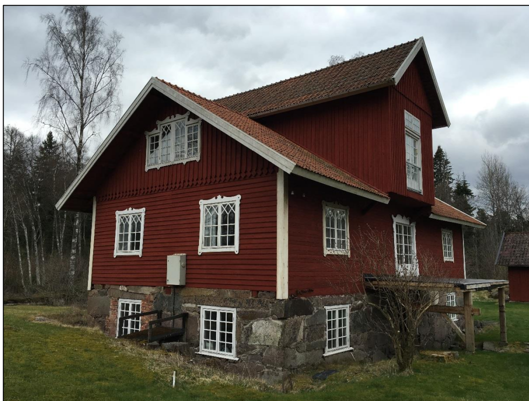
Bild 2. Kvarnhuset sett ifrån nordväst.
