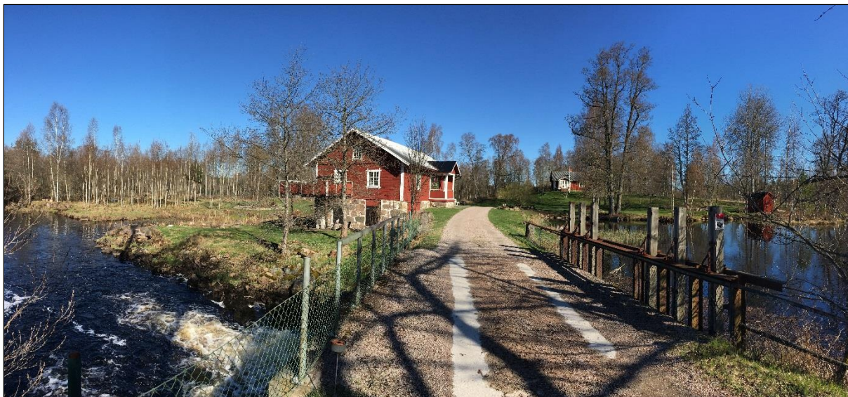
Bild 7. Broöverfarten samt utskov som regleras med spettluckor.
