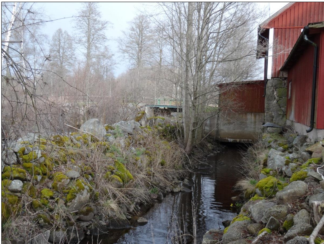
Bild 9. Stenfundamentet i mitten av åfåran och utloppskanalen som tar vid efter turbinsumpen.
