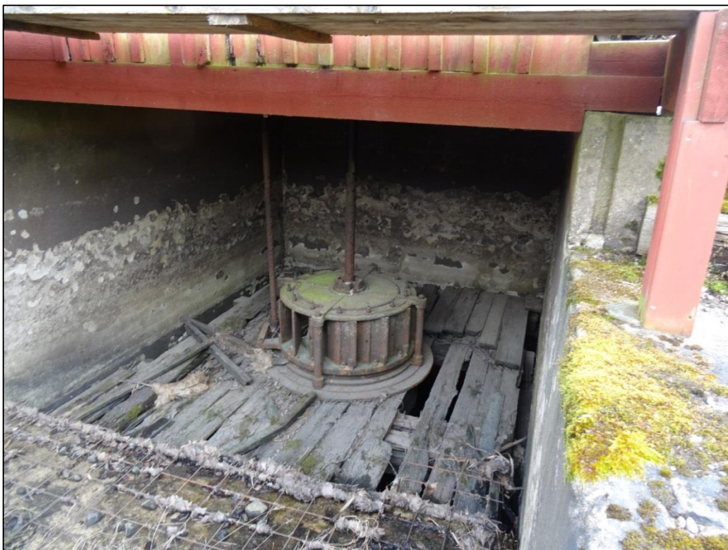
Bild 4. Turbinsumpen av betong där sumpbotten av trä och turbinen fortfarande finns kvar.
