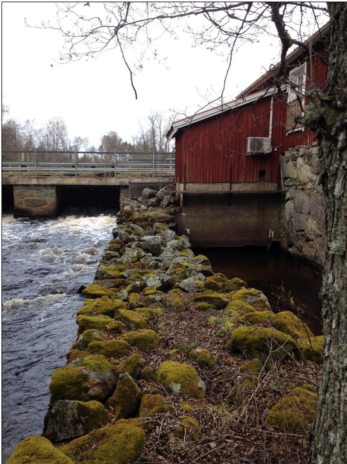
Bild 5. Den uppbyggda stenmuren som delar av strömfåran och skapar en in-och utloppskanal.
