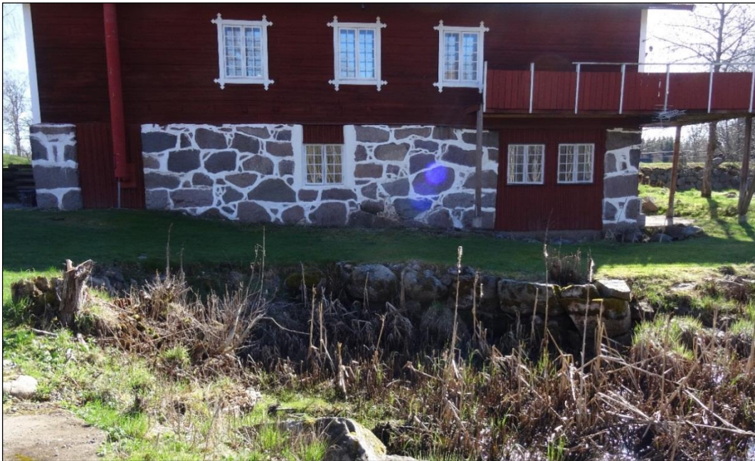
Bild 4. På baksidan av huset syns ytterligare spår av den tidigare öppningen. Utloppskanalen är igenfylld här.
