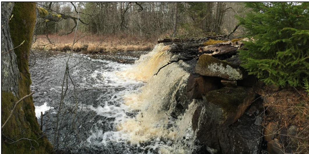
Bild 4. Överfallet med en fallhöjd på 1 till 1,5 meter, med skibordet direkt till höger om fallet.
