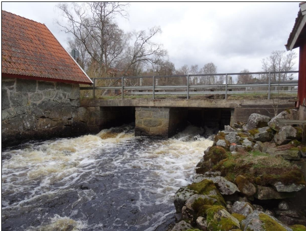
Bild 6. Strömfåran som löper intill stenvuren, de två utskoven och dess spettluckor skymtar uppe vid bron.
