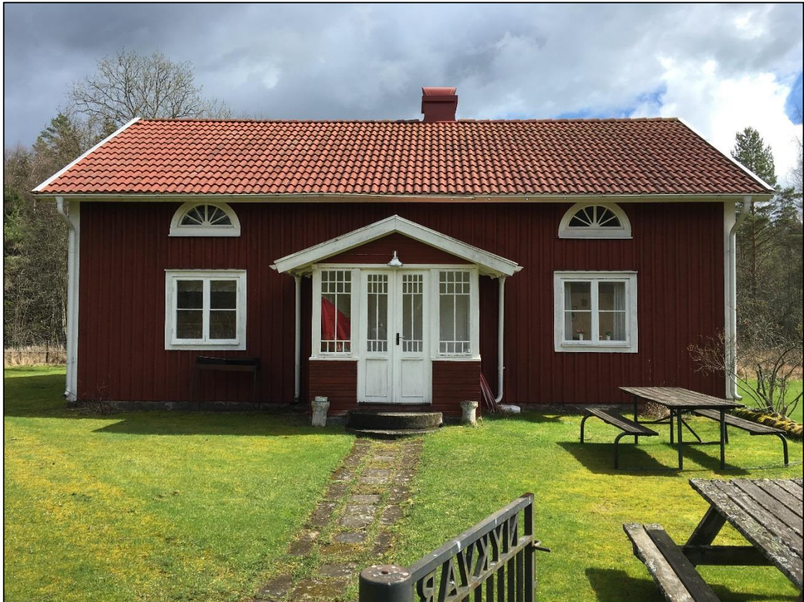
Bild 9. Den före detta mjölnarbostaden till Nykvarn.
