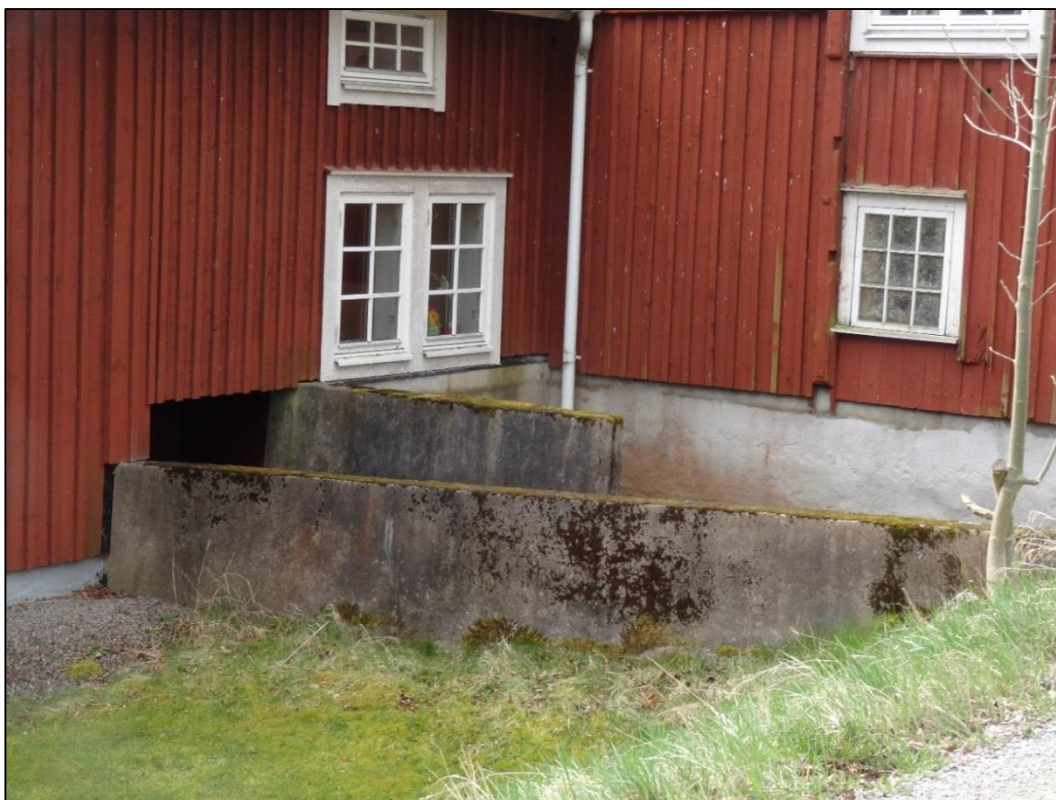
Bild 7. Den andra betongsumpen som troligen hörde till sågen och har haft ett turbinhus ovan en del av sumpen.
