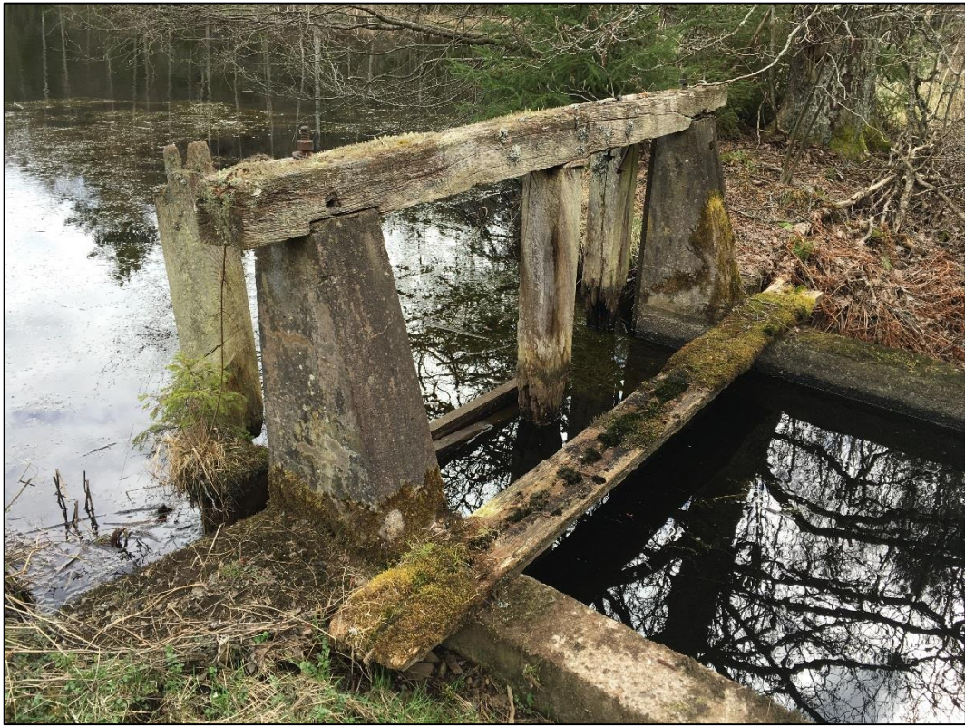
Bild 7. Intaget till betongsumpen.
