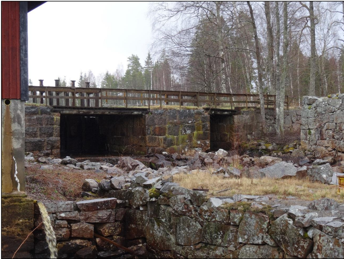
Bild 9. Dammvallen uppförd av huggna stenblock.
