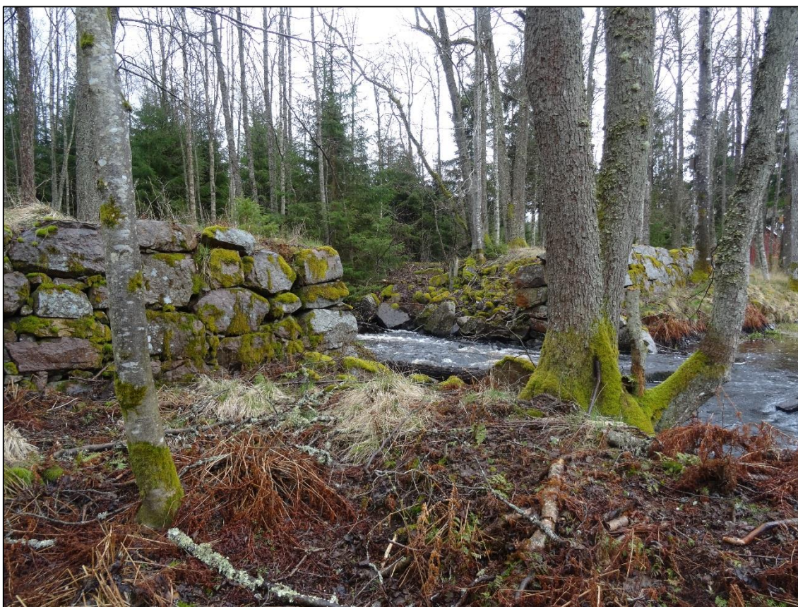
Bild 1. Här syns dammvallen på båda sidor av åfåran tydligt, uppbyggd av mindre stenar och större stenblock.
