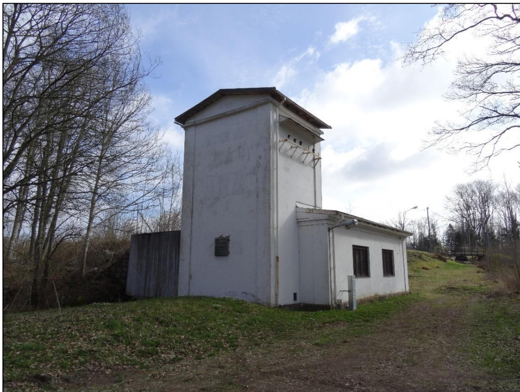
Bild 1. Kraftstationen sedd ifrån västlig riktning.
