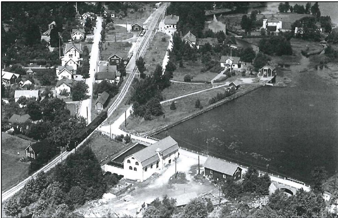
Historisk bild 3. Ingelstads kraftstation och fördämning. Foto taget mot norr/nordväst. Fotografiet är taget under 1930-talet. I bilden syns tydligt den in-och utloppskanal som ledde vattnet förbi turbinen. (Kronobergsboken 2009).
