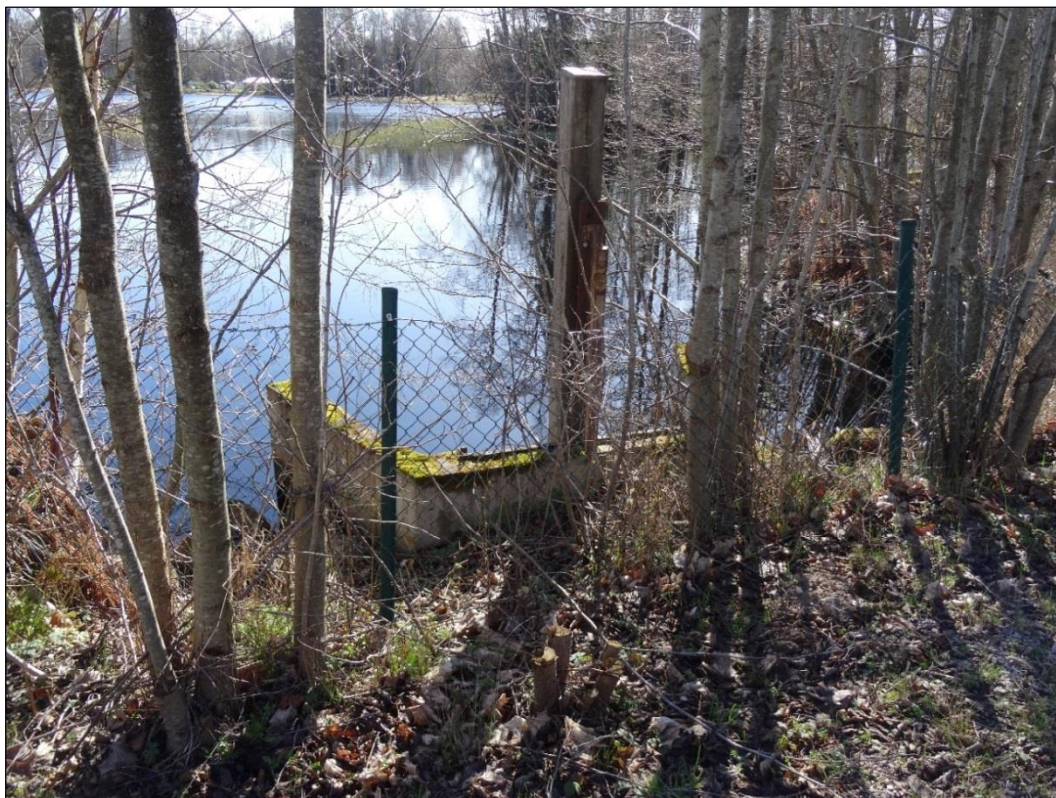
Bild 6. Det mindre utskovet som regleras med en spettlucka.
