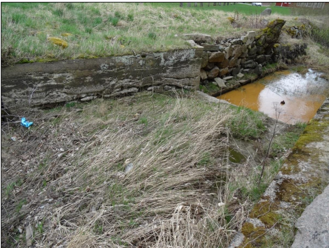
Bild 6. Turbinsumpen i betong som är delvis övervuxen, här syns också stenskodda kanter som sedan tar vid en bit längs kanalen.
