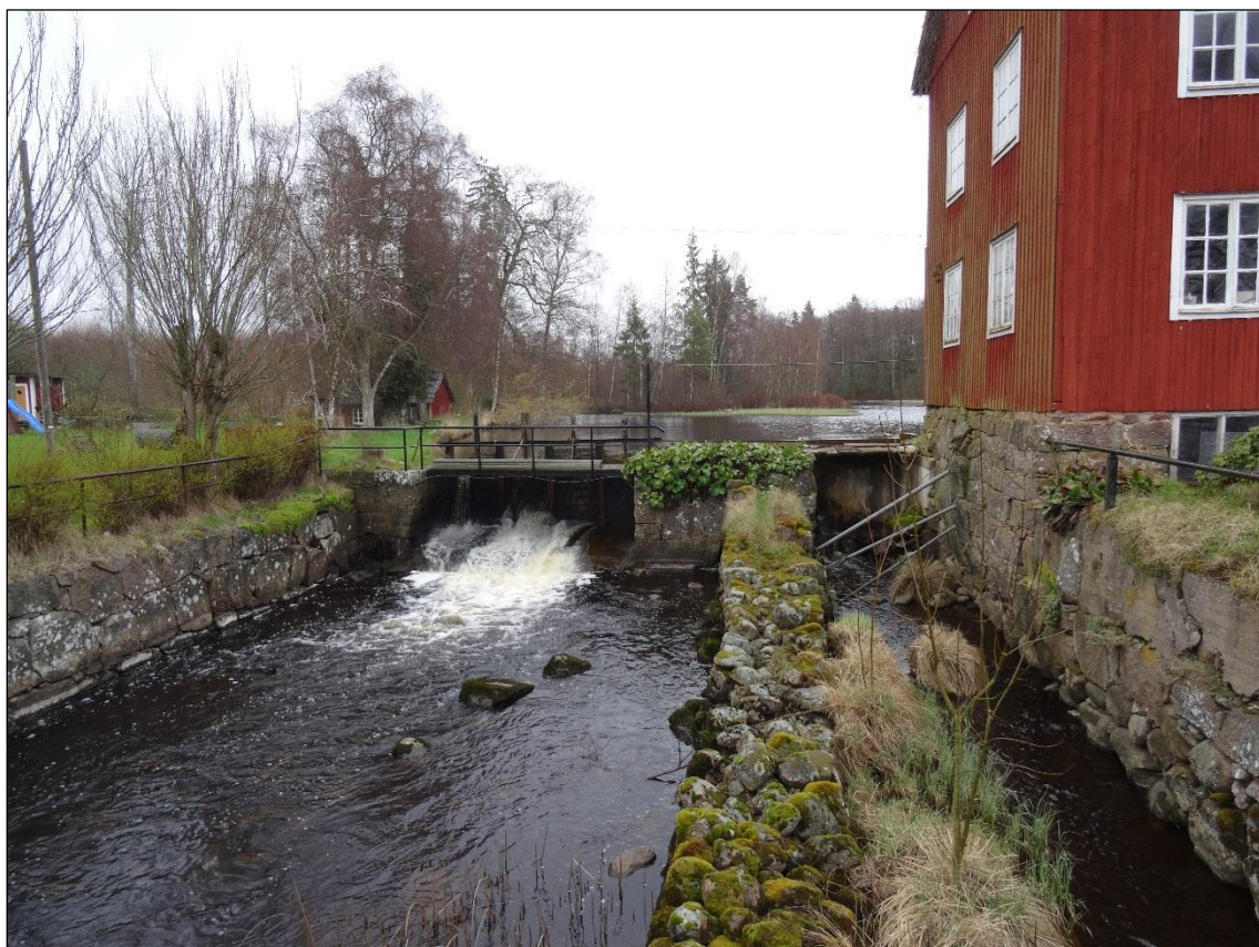
Bild 9. Det norra utskovet och en avgränsad in-och utloppskanal.
