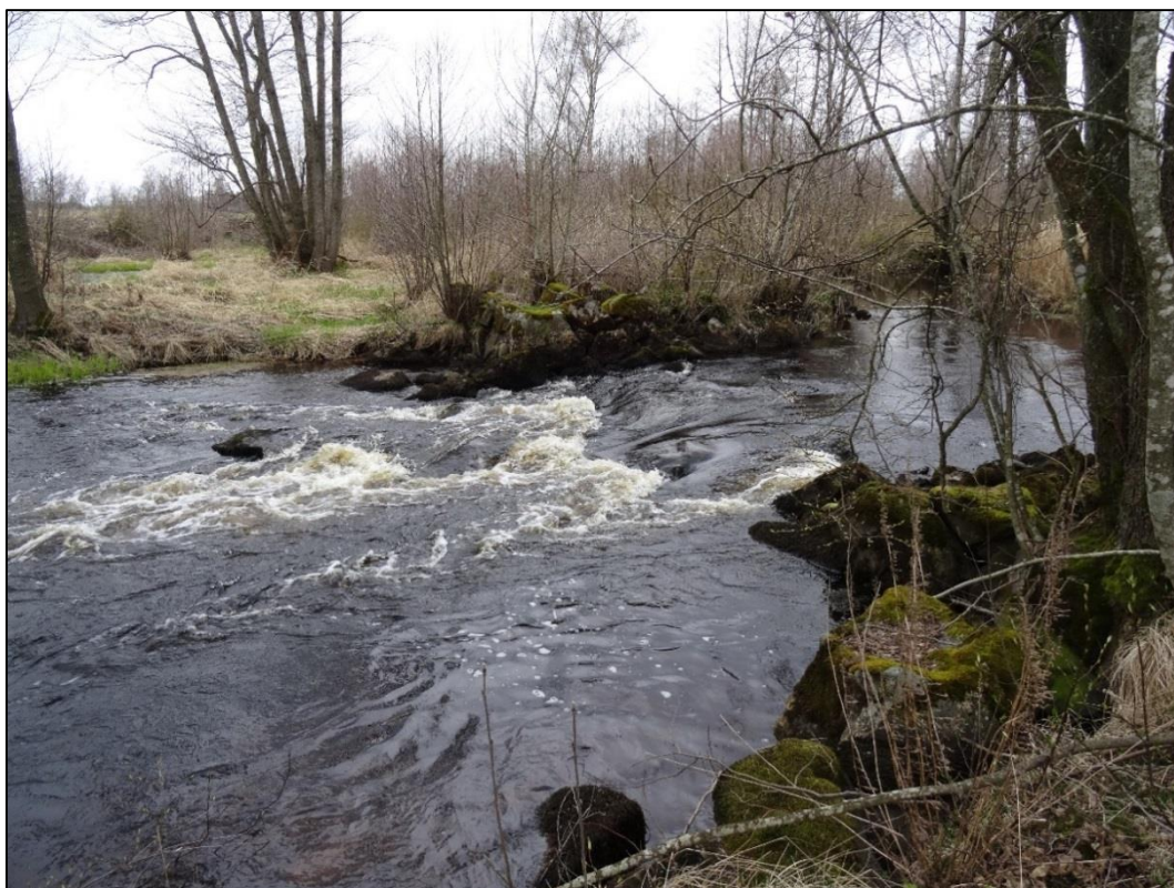
Bild 2. Dämnet och delar av dammvallen som syns på sidorna av dämnet.
