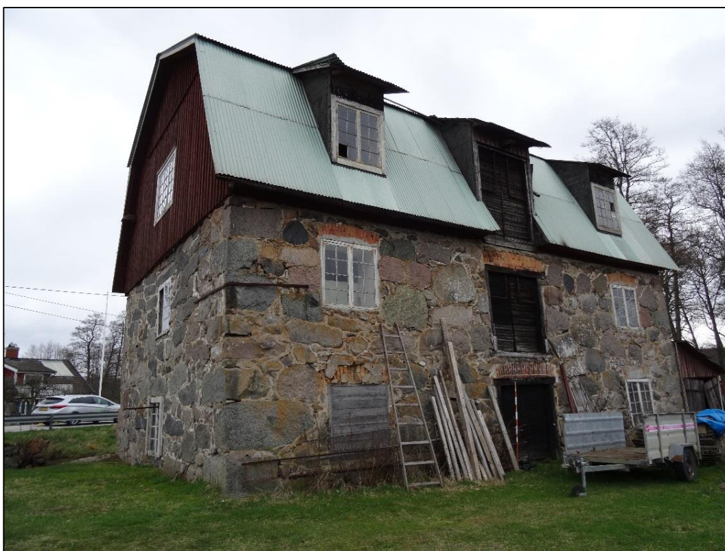
Bild 2. Kvarnbyggnaden sedd ifrån öst.
