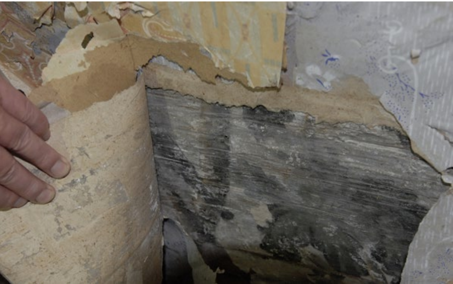
På andra våningens bjälklag hittar man måleri från 1700-talet under alla lager av tapeter. Foto: Thomas Lissing.
