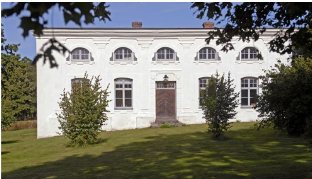
Mejeribyggnaden på Jätsberg. Foto: Thomas Lissing.
