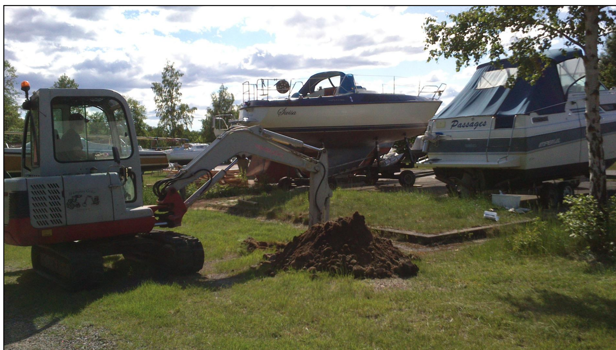
Figur 10. Provgropsgrävning. Bolmens f.d. sågverk.
