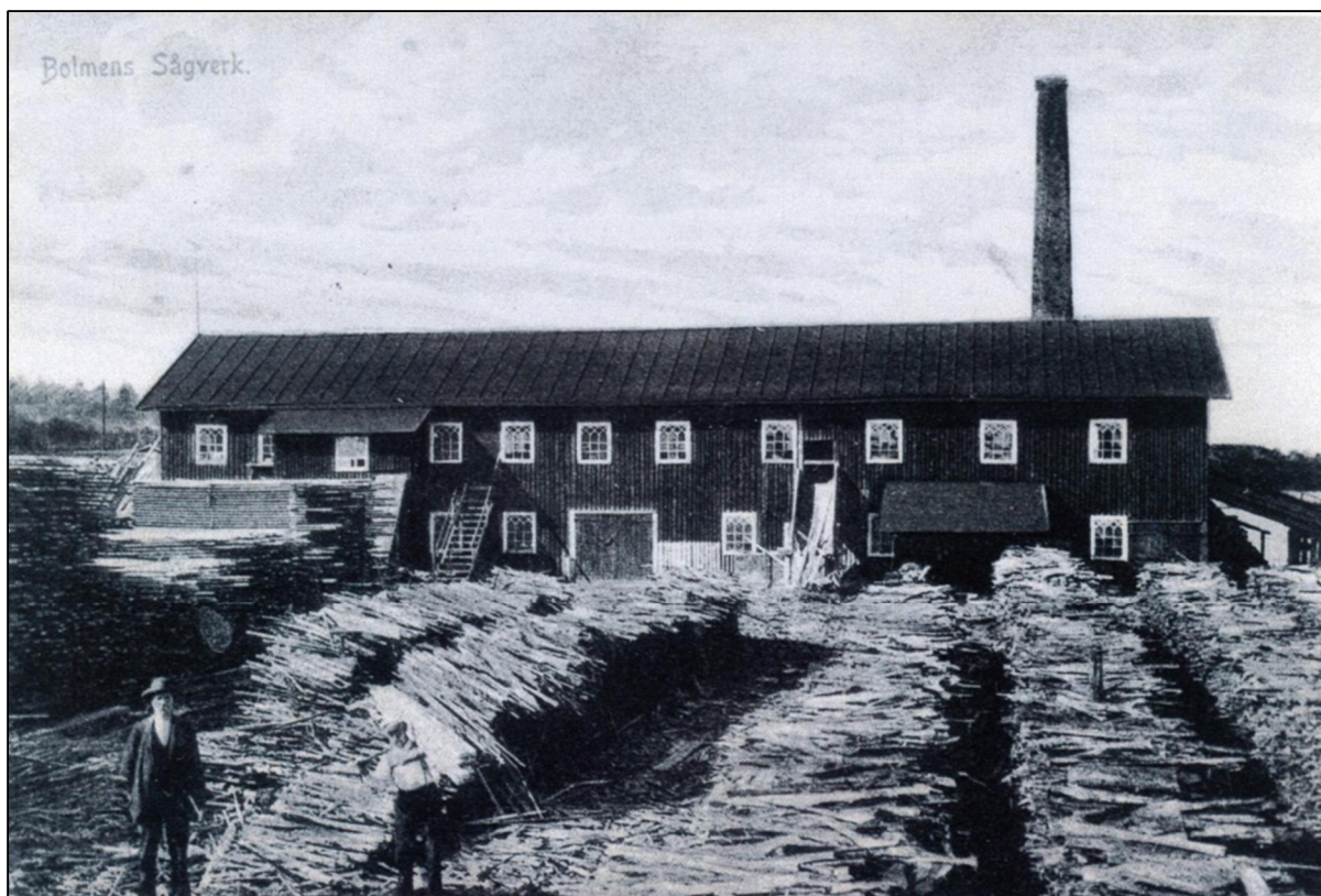
Figur 1 Fotografi av den andra sågverksbyggnaden (1895 – 1916). Fotografiet är taget från norr mot söder. I förgrunden ses överskottsved, s.k. ytved, som användes för eldning i ångpannan.
