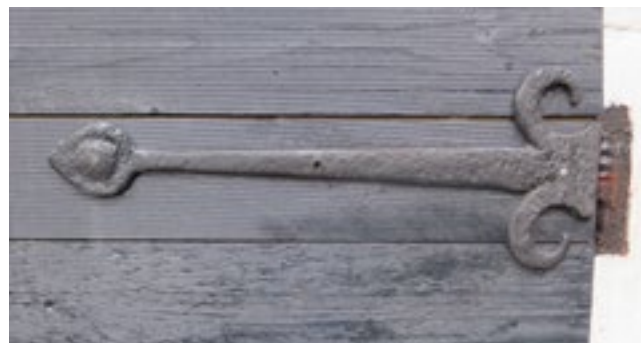
Ett av källardörrarnas smidda gångjärn.
