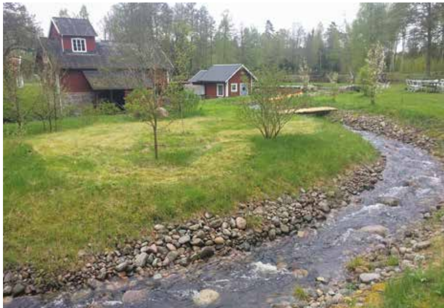
Omlöpet vid Stocke kvarn i Rottneån.
