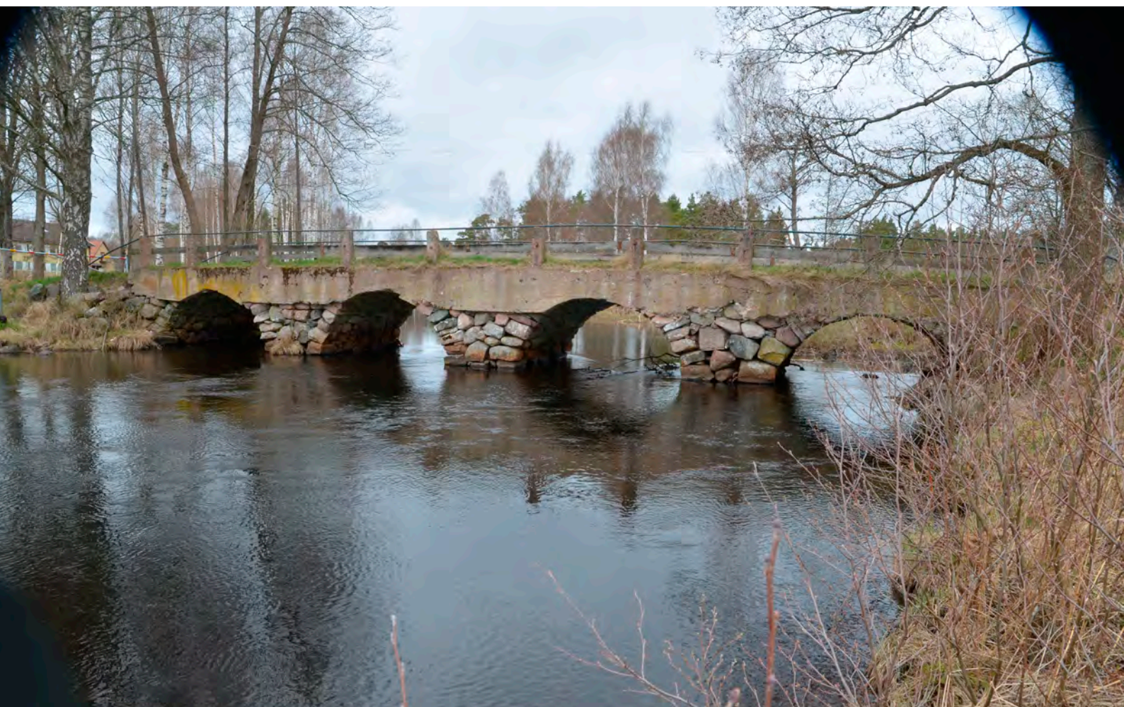
Den enda kvarvarande stenvalvbron i Hohult ligger norr om byn över Alsterån.
