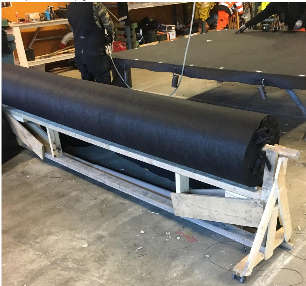
Fig 7: Fiberduken är enkel att flytta och dra ut i den hjulförsedda vaggan.
