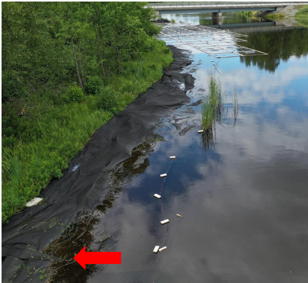
Fig 18: Strandduk och överlappande ramar skapar en ljustät övergång mellan vatten och land. I nederkant på bilden vid pilen syns hur två stranddukar överlappar varandra med minst 1,5 meter.
