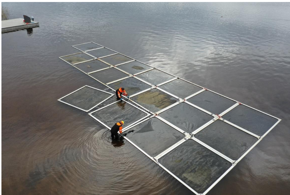
Fig 26: Att bygga ihop ett ramflak vid en strandkant förenklar och effektiviserar arbetet. När det är klart bogseras det till den plats där det ska ligga.
