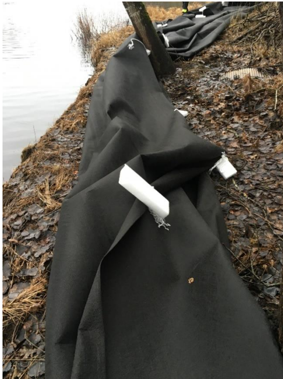
Fig 15: Dragspelsvikningen gör att strandduken går lätt att lägga putta ut när den ligger på plats längs stranden.
