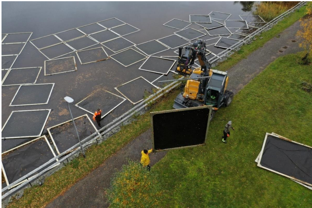
Fig 30: Ett ok kopplat på grävaggregatet på en grävmaskin underlättar arbetet med att ta upp ramar.
