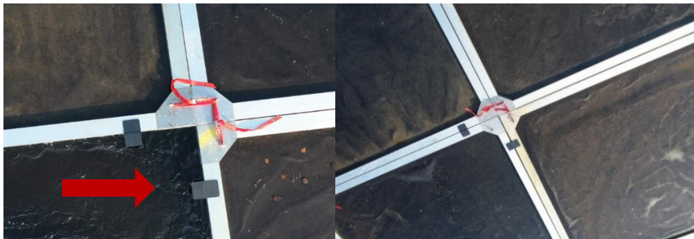
Fig 22: Plastprofilen i form av ett H (se röd pil) sätts på plats innan det fjärde hörnet på nästa ram skjuts in.
