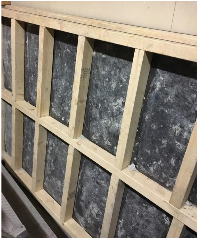
Fig 12: En enkel gjutform för ankarsten byggd av reglar och en plyfaskiva. Formen rymmer 16 ankarstenar.
