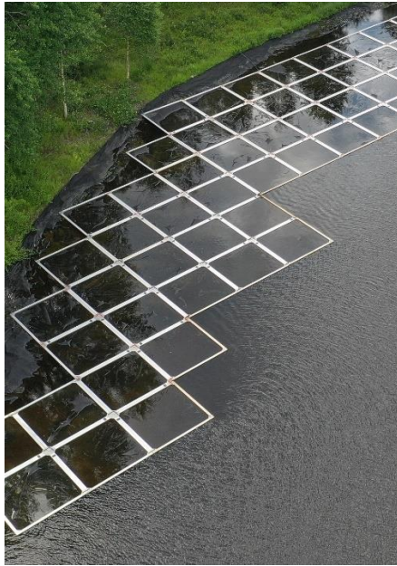
Fig 28: I kanterna av både land och en sjögullskoloni "trappas" ramarna.
