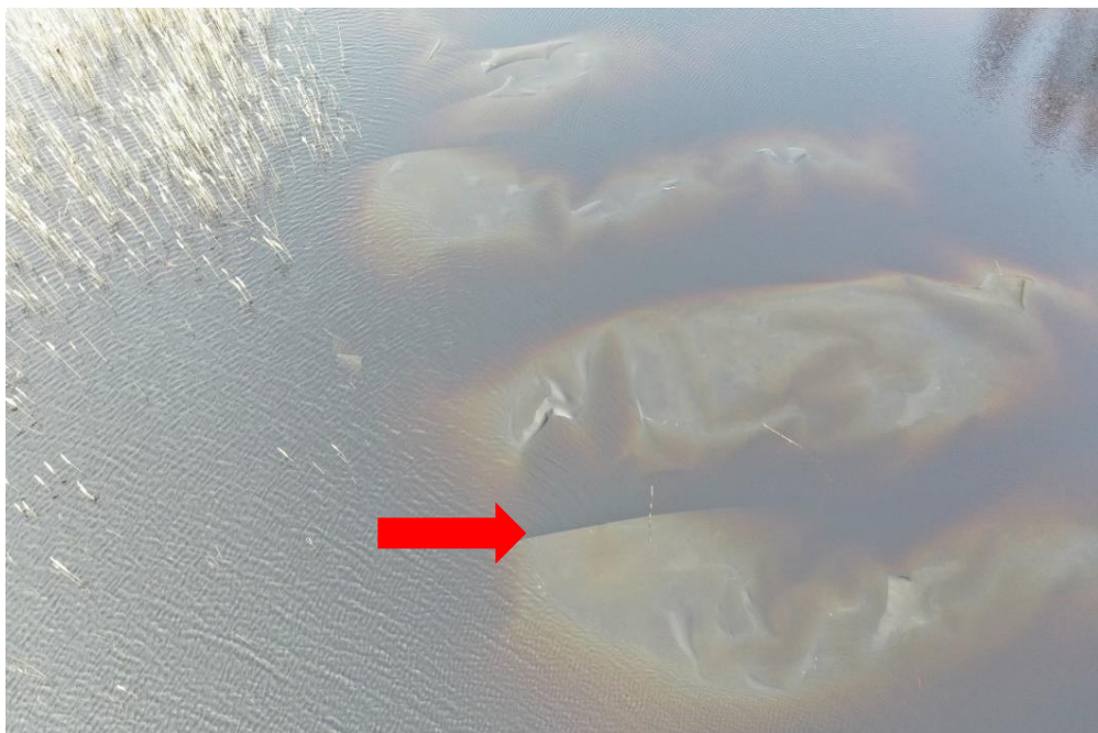
Fig 40: Gasen under duken som lagts på botten har sipprat ut i skarven mellan dukarna (pilen).
