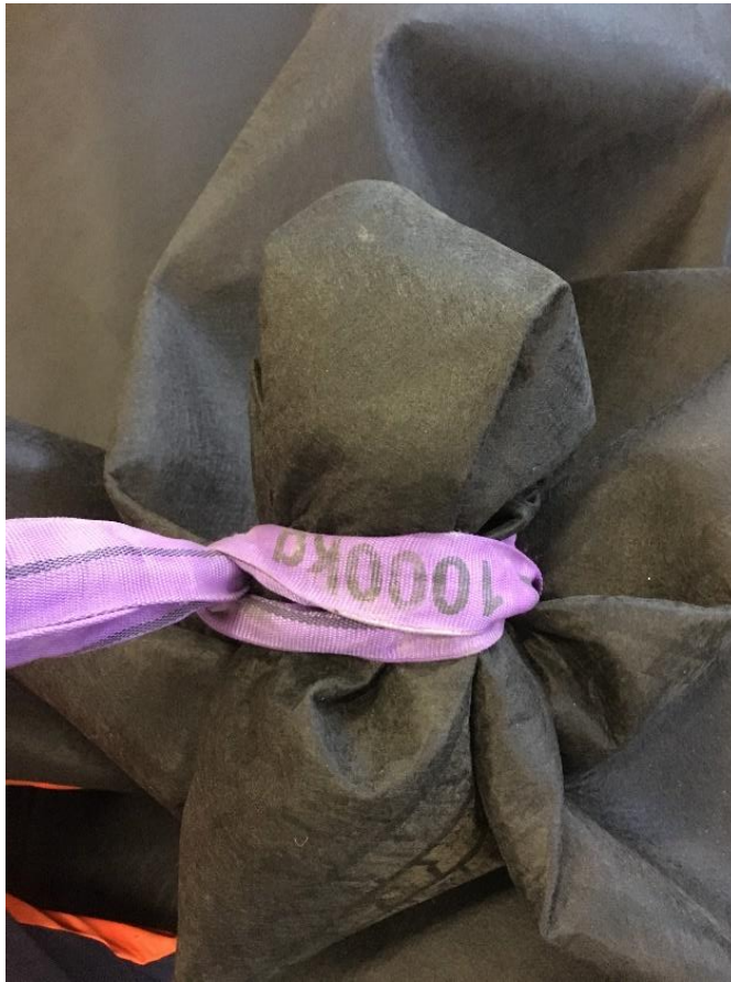
Fig 37: Slingan låser fast duken runt stenen vilket gör att den flytande duken eller strandduken kan dras in med en grävmaskin.
