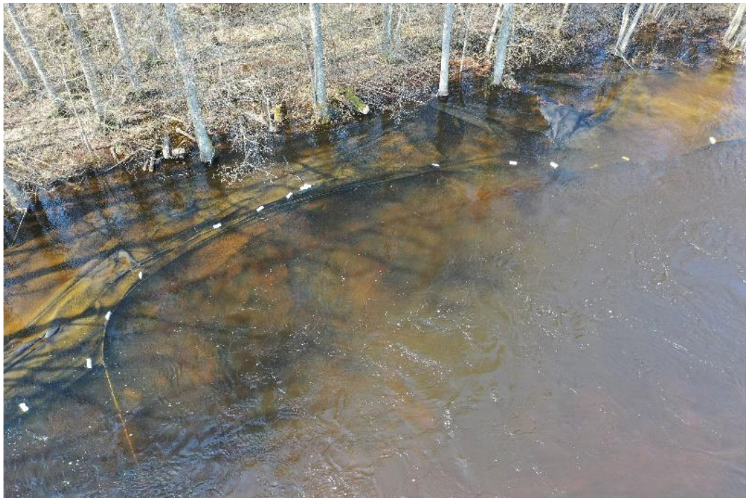
Fig 38: När flödet ökade tryckte strömmen in strandduken eftersom den förankrats med för få ankarstenar.
