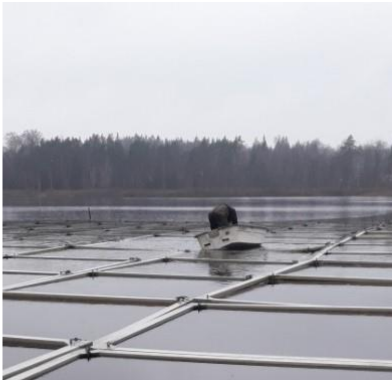
Fig 31: Ett större ramflak delas i lämplig storlek genom att "gå" på ramarna.
